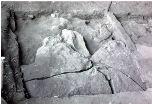
4 第3トレンチC区の落盤
