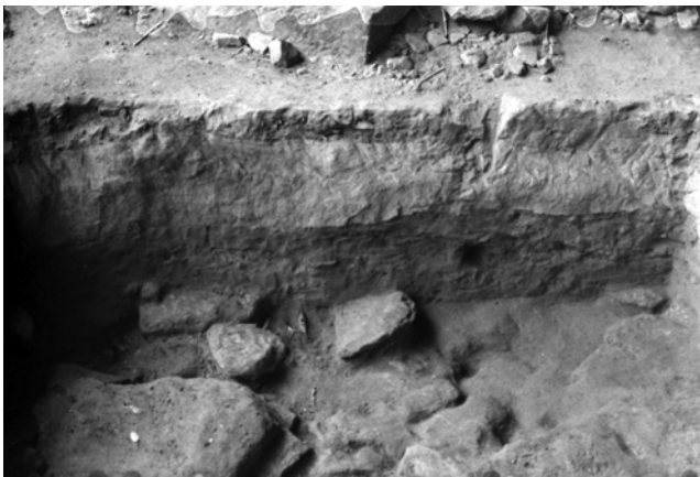
5 第2トレンチ奥壁の落盤
