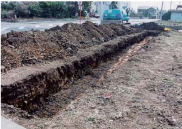
西側調査区トレンチ (南東から)
