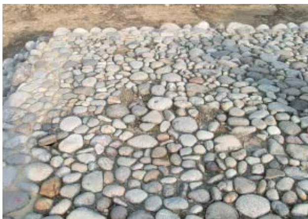
段築平坦面・北西角（修繕前）
