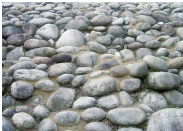
同上 部分（修繕後）
