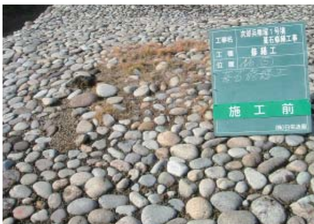
段築平坦面・南側（修繕前）
