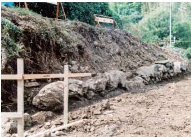
東側石垣の残存状況 (南から)
