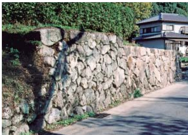
南側の石垣 (欠損部の復元整備後)
