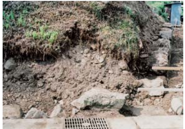
南・東側石垣の角部分 (調査後)
