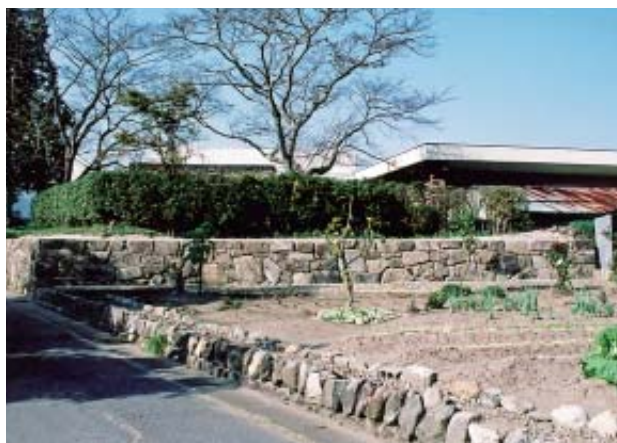
東側の石垣 (欠損部の復元整備後)
