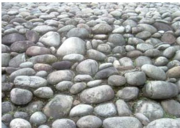
同上 部分（修繕前）
