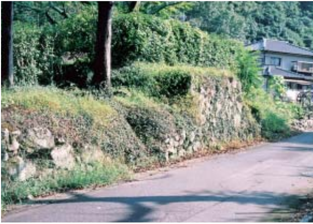
南側石垣の現況 (西から)
