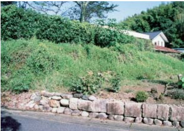
東側石垣の現況 (南から)
