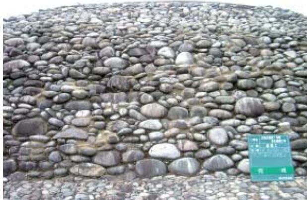
上段葺石・北側（修繕後）
