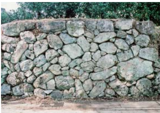
南側石垣の残存状況 (部分)
