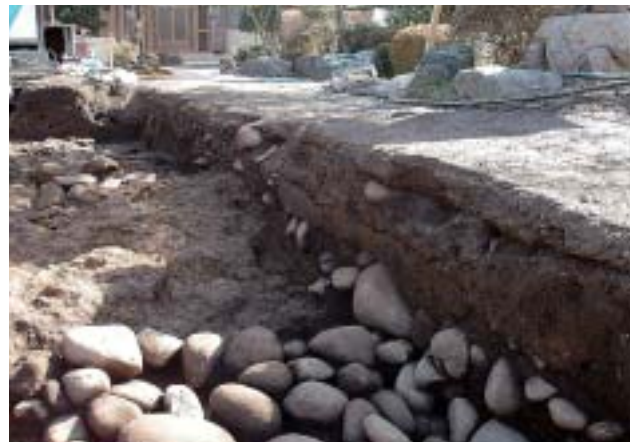
陸橋部分の地山掘り残し（西から）
