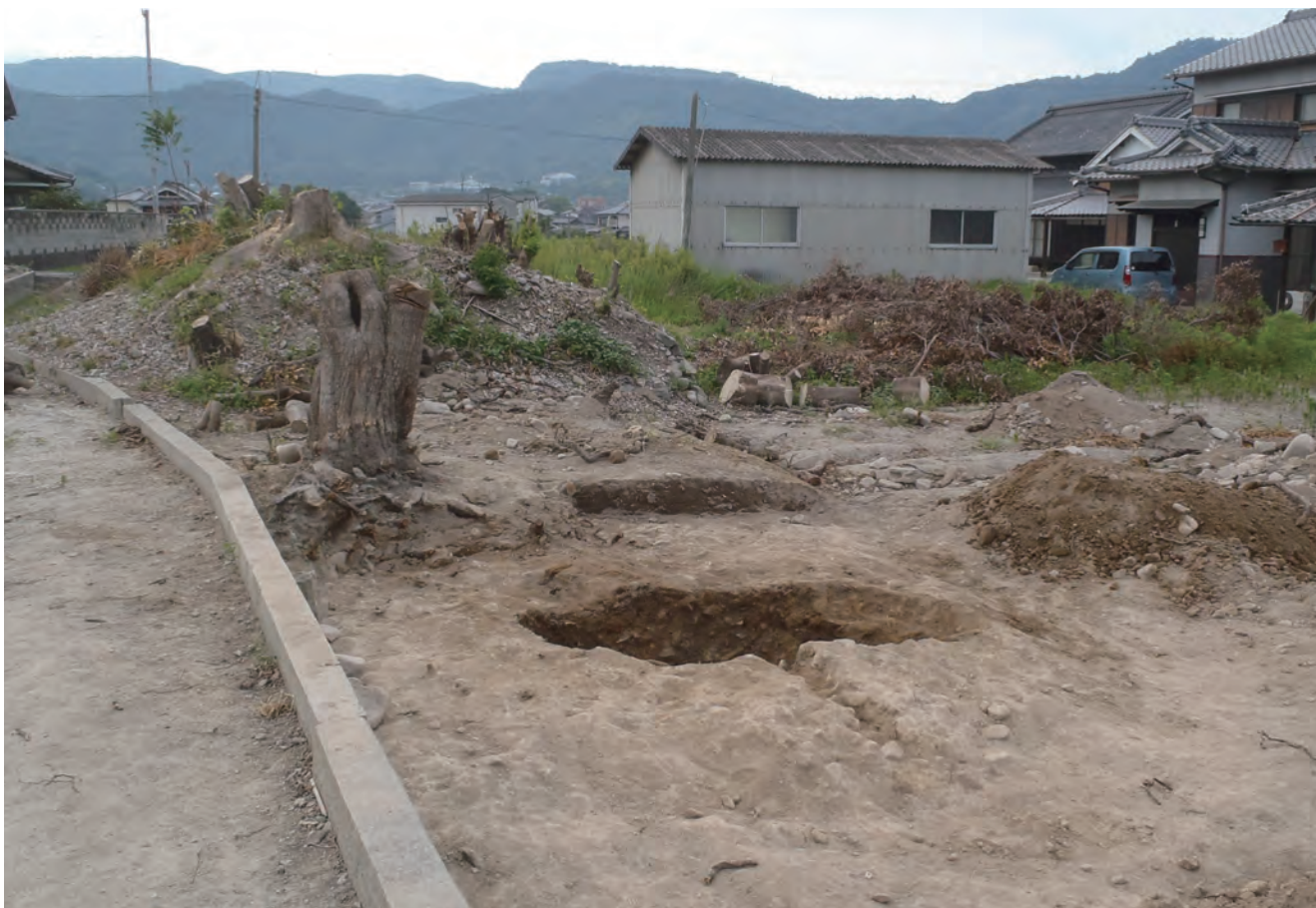
飯田西14号塚 完掘状況（東から）
