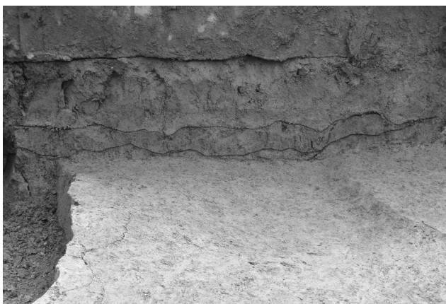
10-SX30 断面（北から）
