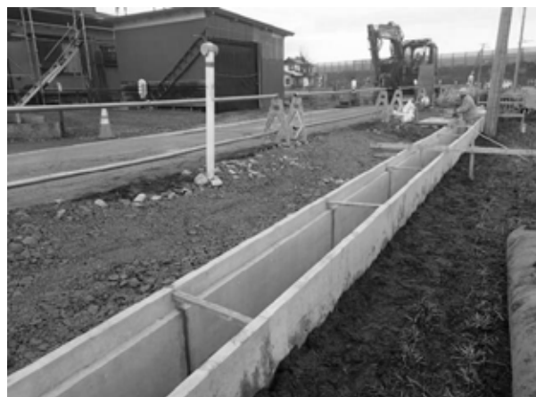
中ノ目字北ノ前田調査状況（南東より）
