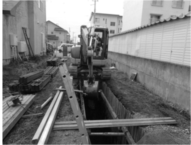
三間通字稲荷調査状況（北より）
