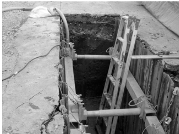
俎柳字中丸・中ノ目下工事状況(南より)
