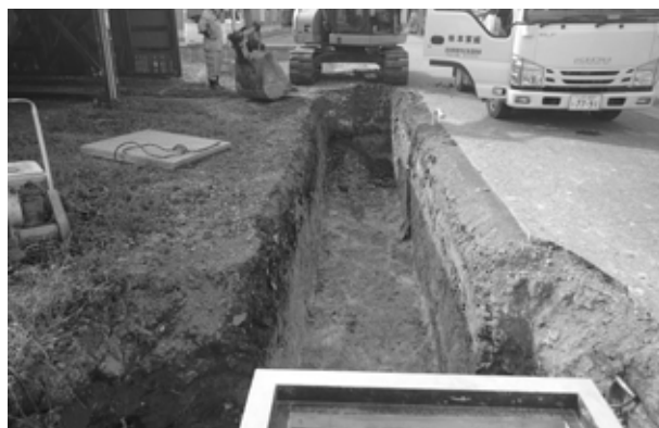
二色根字根小屋全景(南より)
