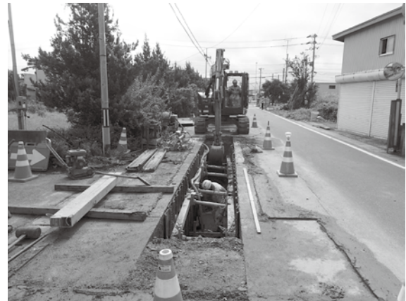
俎柳字内城全景(西より)
