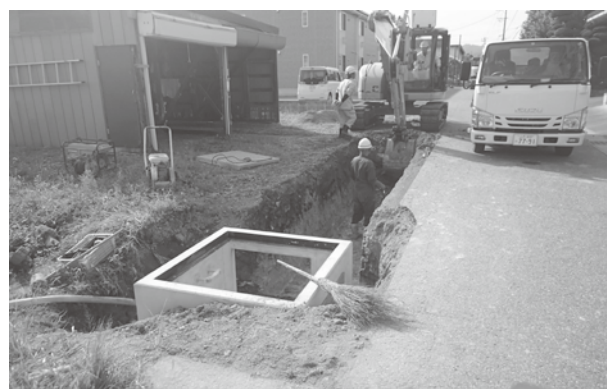
二色根字根小屋全景(東より)
