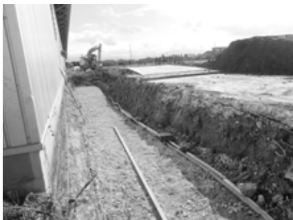
萩生田遺跡調査状況(北より)
