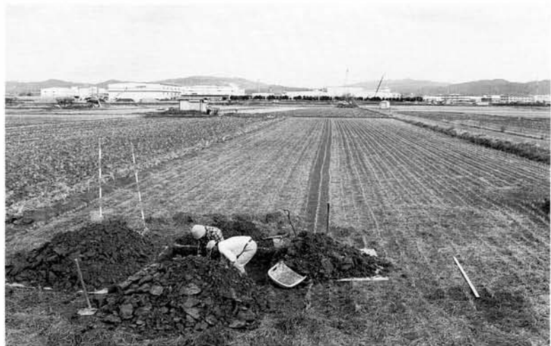
19トレンチ調査風景 (西から)
