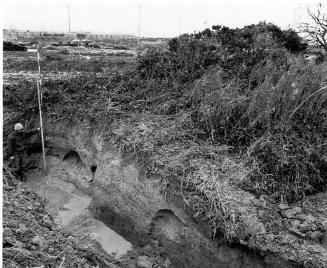
34トレンチ (堤防断ち割り)
