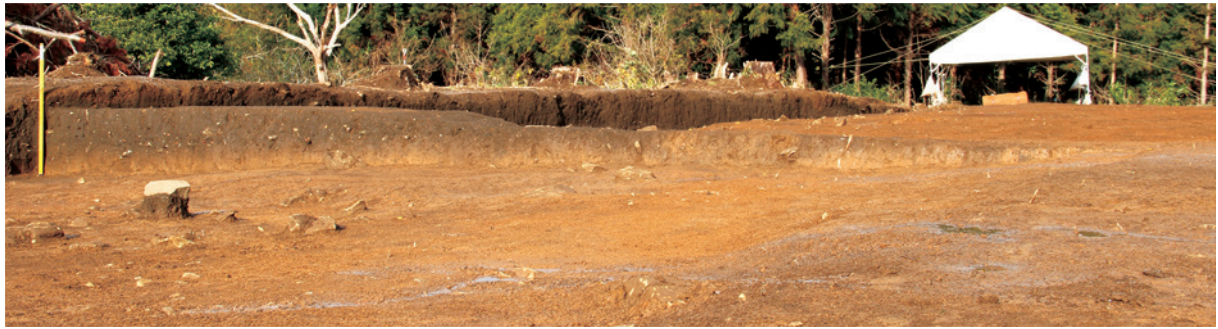
SX2 土層断面 B-B'(南から)
