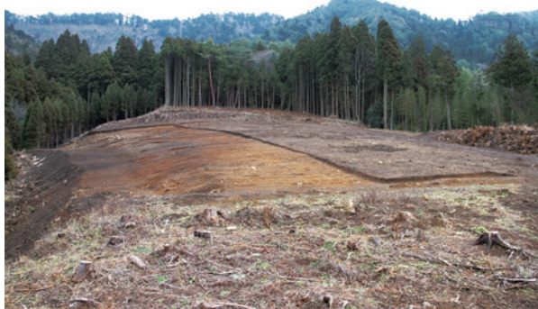
A区及び東端部調査区全景(北西から)
