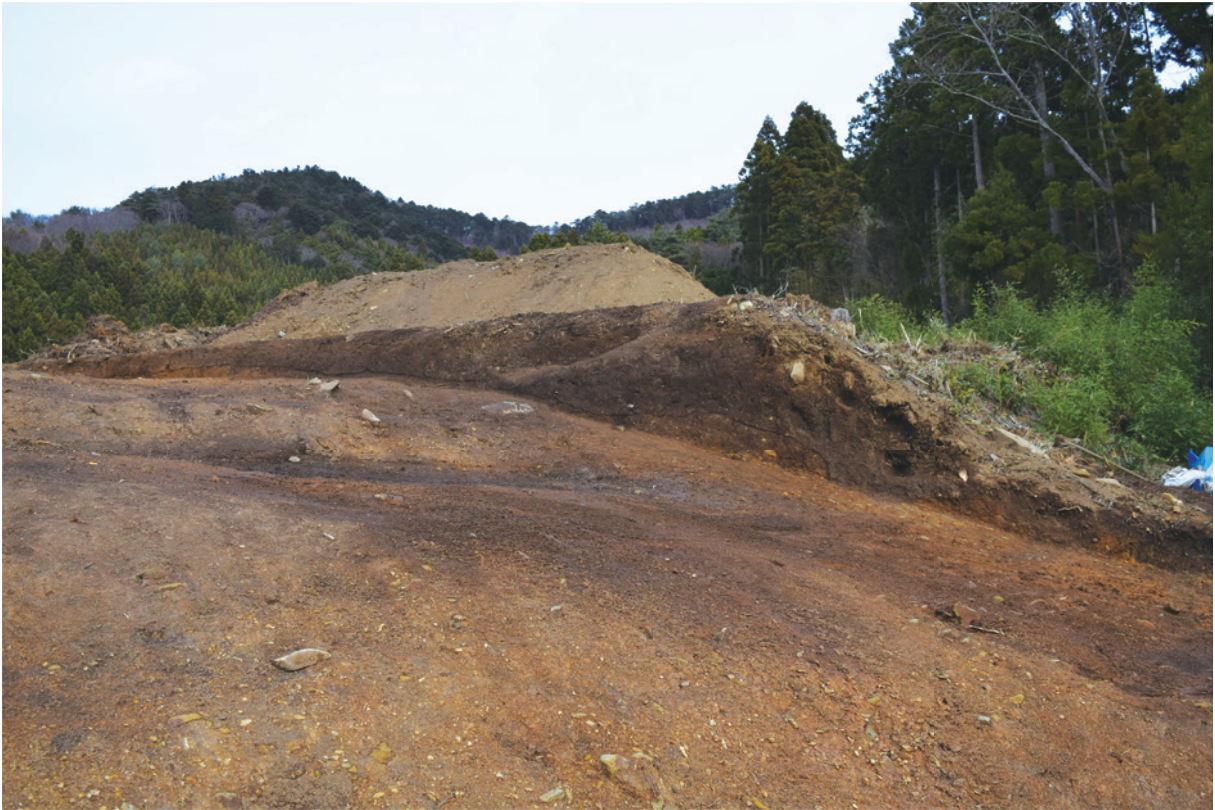
SX3 (北側) 土層断面 C-C' (北から)
