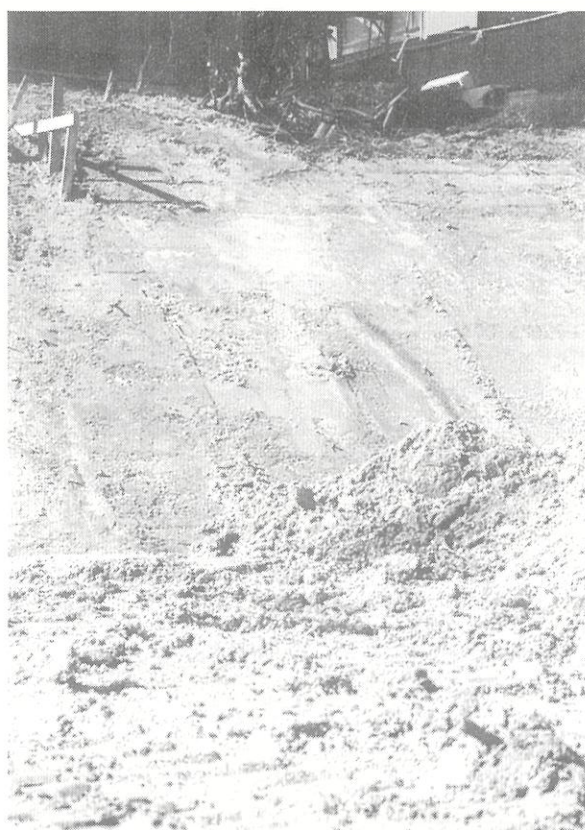
③工事中風景（北東から）
