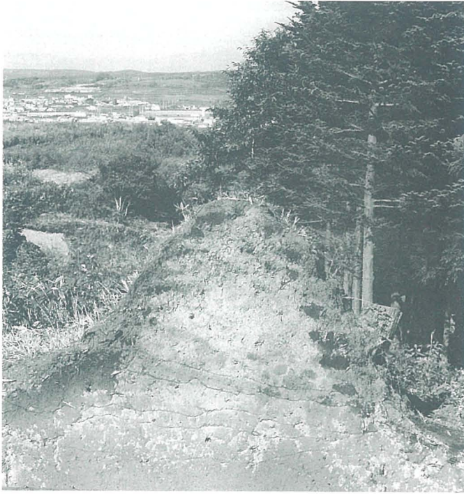
土堤の状況とそのセクション(C22Grid)
