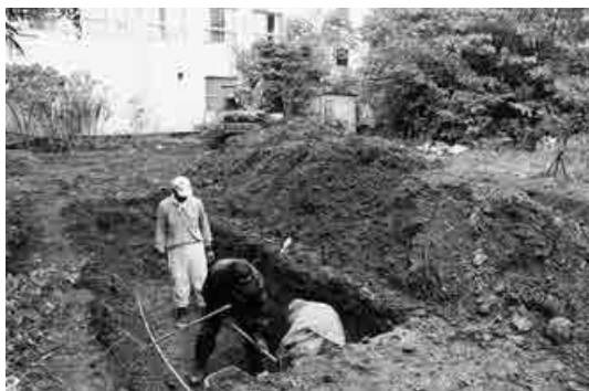
試掘作業風景
