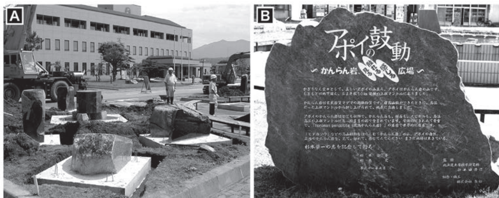
図6. (A) 様似町役場の前庭に建設中のかんらん岩広場（1999.7.17：南健雄氏撮影）。(B) かんらん岩広場のシンボル標本『アポイの鼓動～かんらん岩「見る」「触れる」「感じる」広場～』
