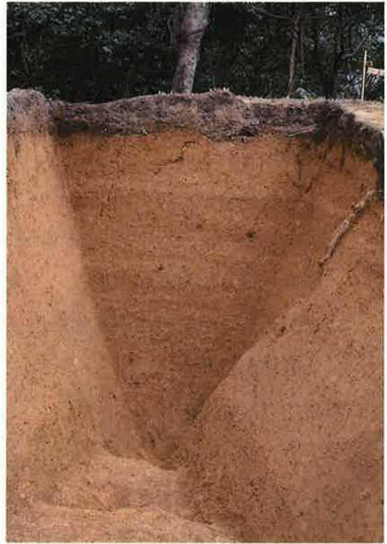
図5 千畳敷曲輪 第17-2トレンチ 東壁 曲輪を造成するための盛土
