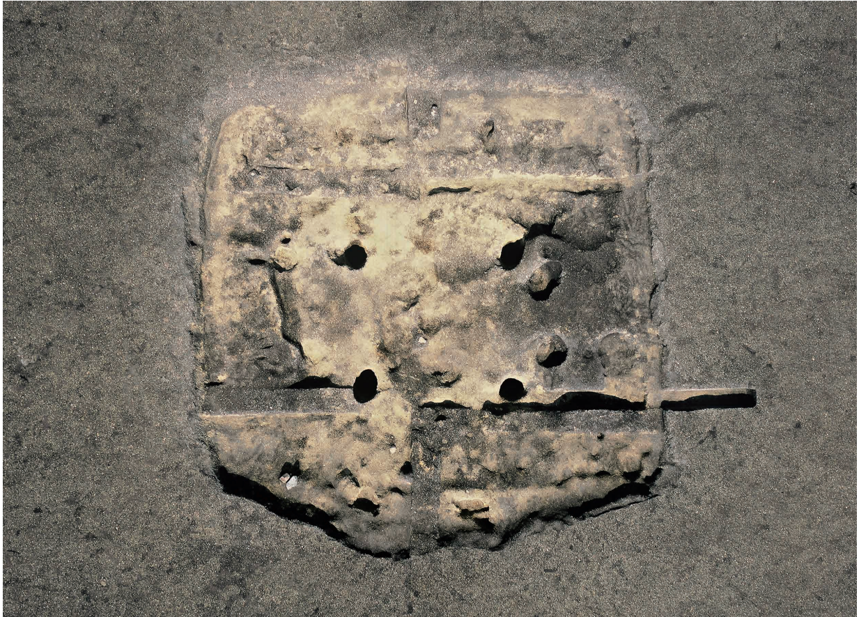
S A 2 建て替え前床面状況① (上が北)
