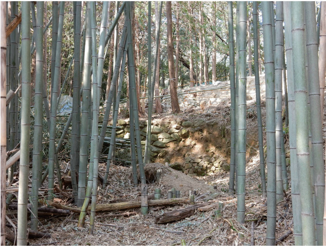
写真図版 1 2 縦堀を塞ぐように構築された石積の一部
