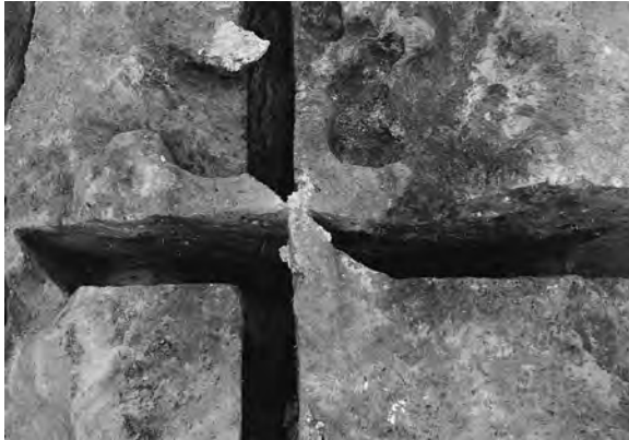
炉底～地下構造断面A（東から）
