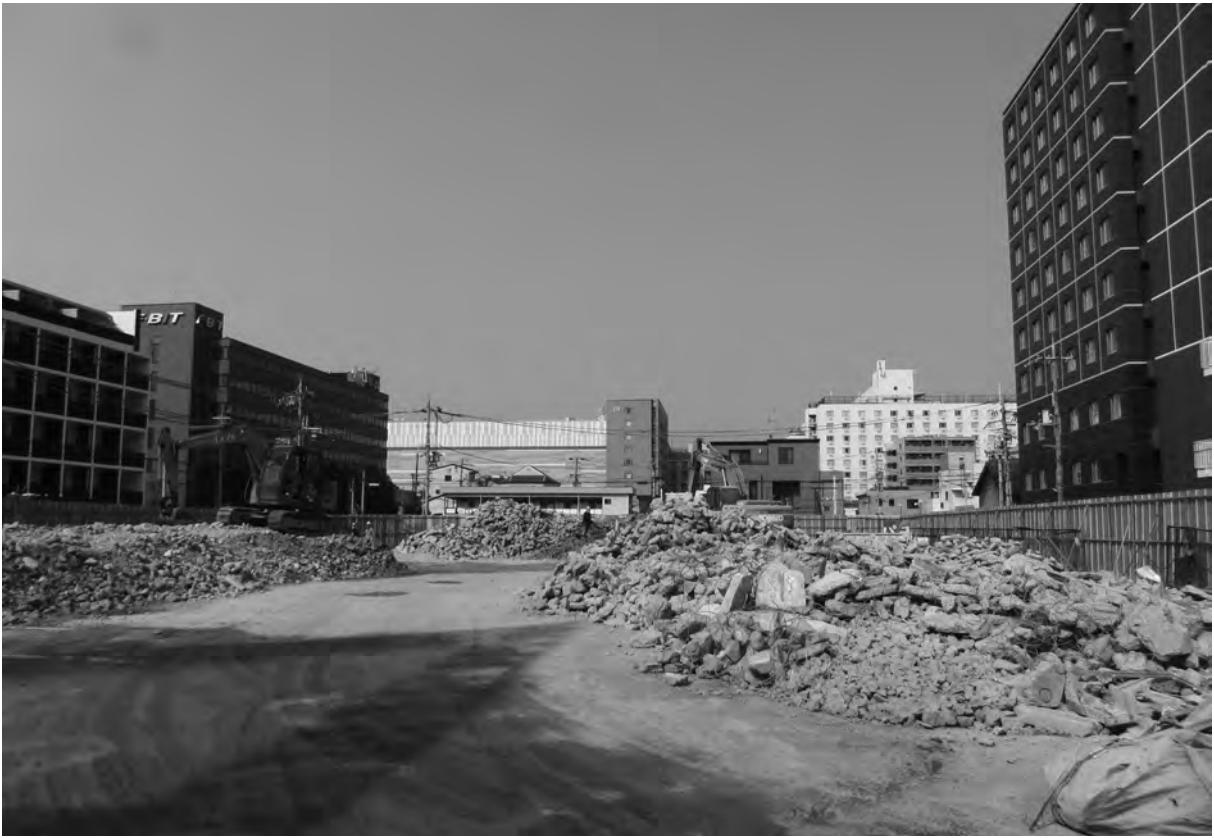
調査前風景（北東から）
