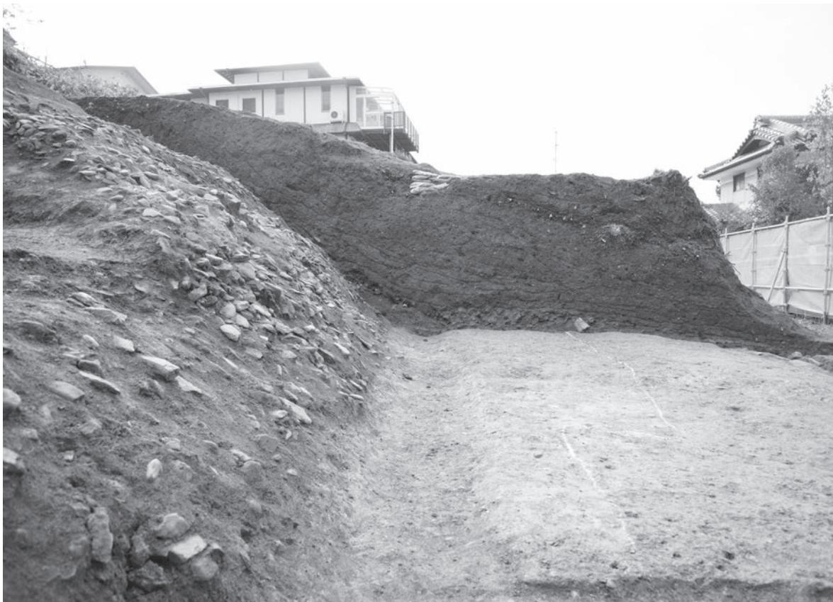
1 石垣 05SL の裏込と壁面（北から）
