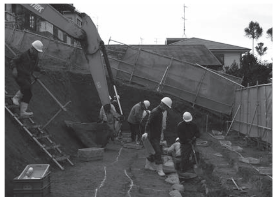
写真2 4区石組溝の掘削作業
