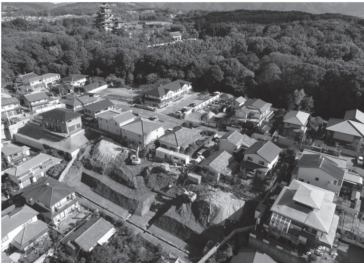
2 調査地、桃山町下野の平場、伏見城跡主郭部等を望む（南西から）
