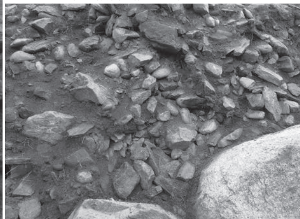
4 裏込栗石の状況（北西から）
