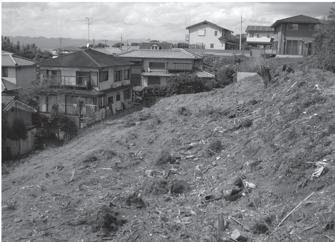
1 調査前の状況（南から）
