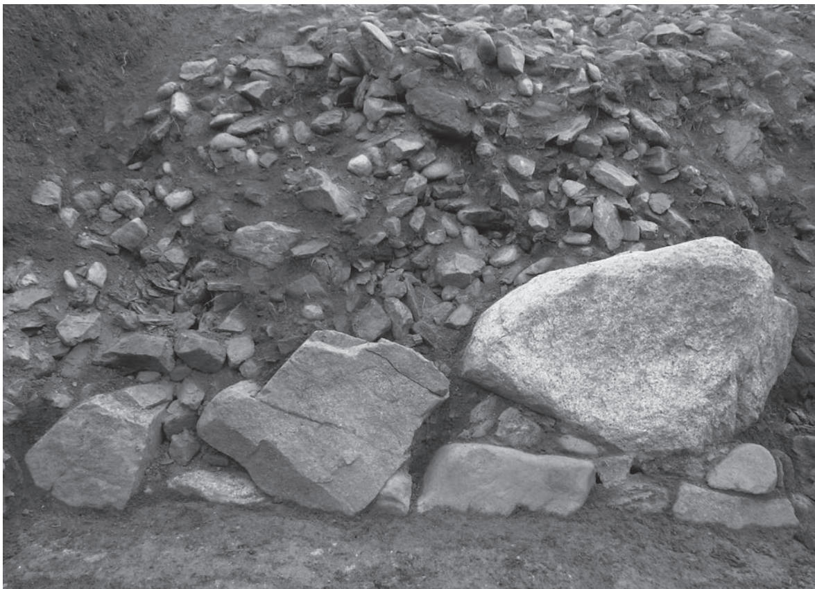
1 路面より上に残存する石垣 01SL (西から)
