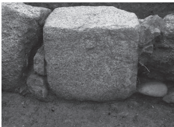
5 石組溝 08SD、6グリット東側列の方形加工された花崗岩（西から）
