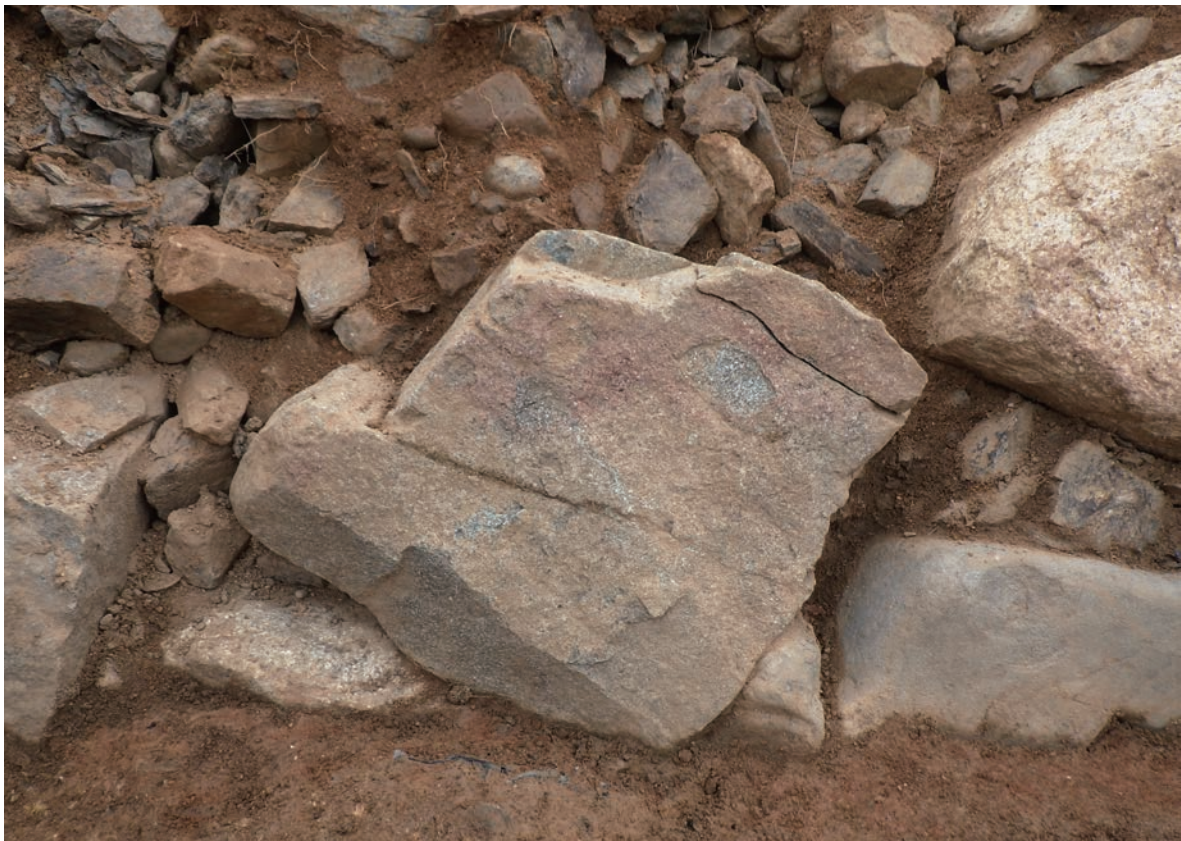
7 石垣 01SL 最上部残存石材（築石）の被熱状態と石爆ぜ（西から）
