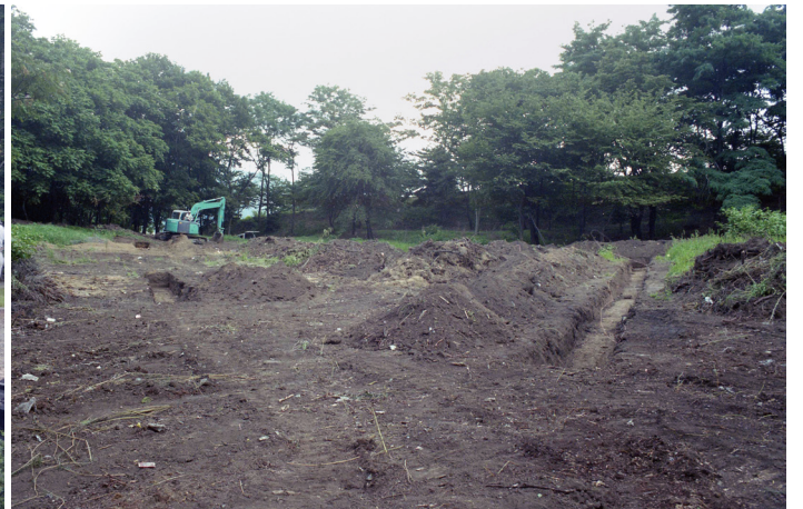
XIII次 トレンチ掘削
