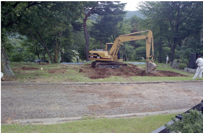
XII次 重機掘削
