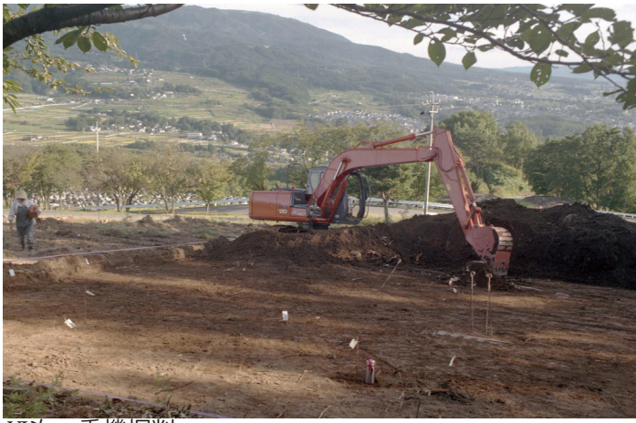
XI次 重機掘削
