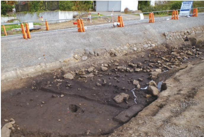
D2区 検出状況 (南西から)
