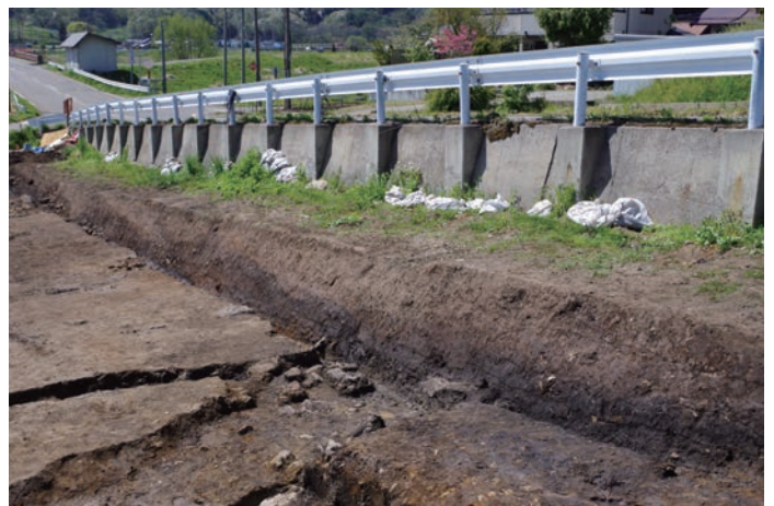
D1区 北壁土層 (南東から)
