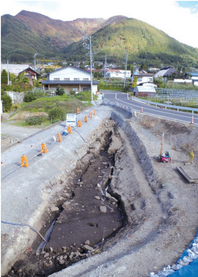
D2区 完掘全景 (西から)
