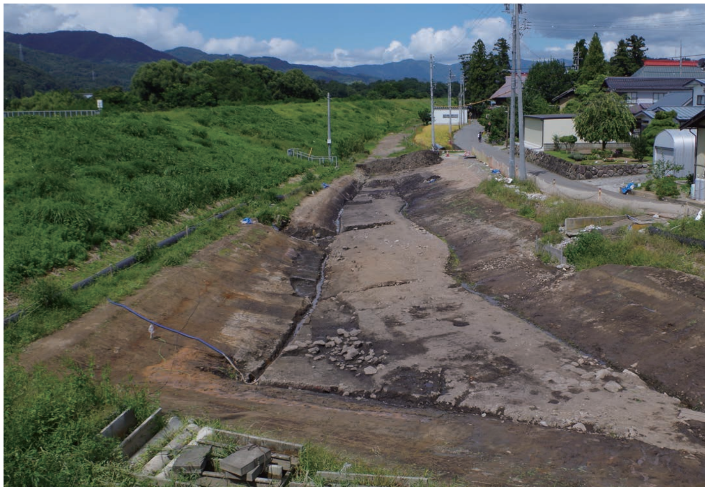
C2区 全景（南から）
