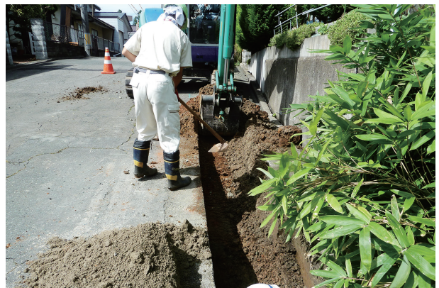
写真3 1号窯跡立会調査状況
