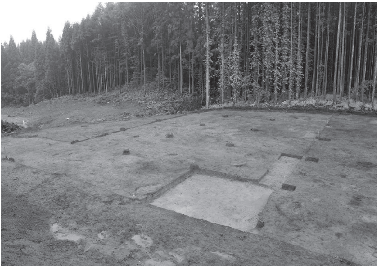
調査終了状況 E → W
