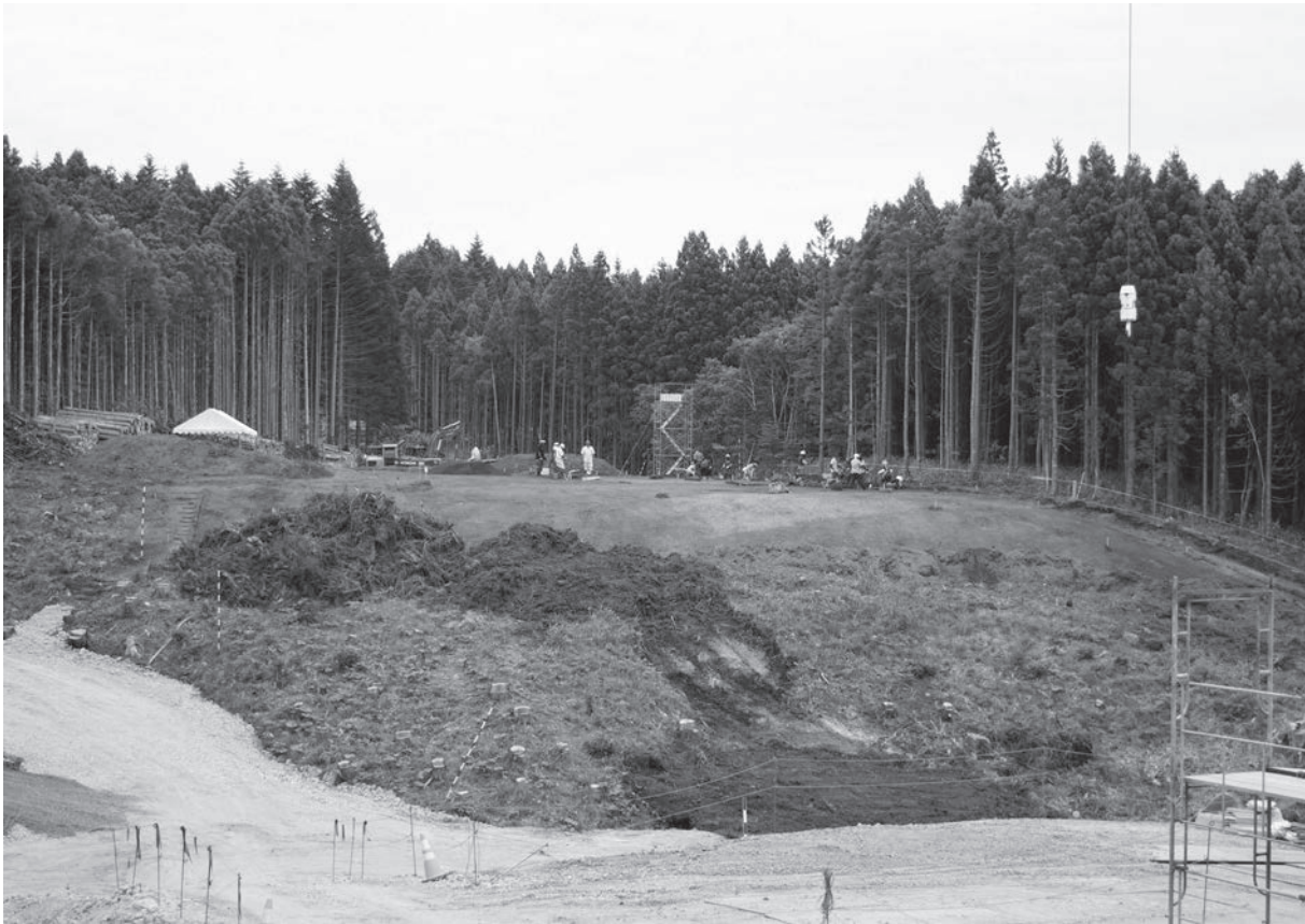
調査状況 NW → SE
