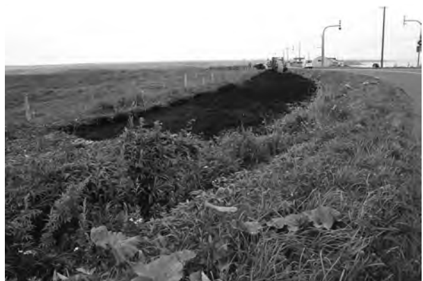
平成23年度表土除去作業状況
