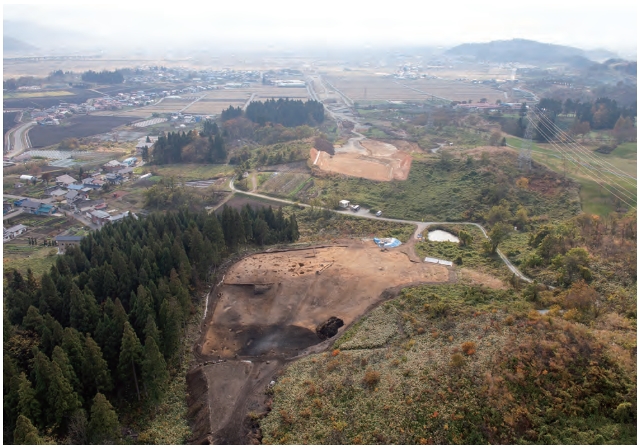
第2次調査遠景（北から）
