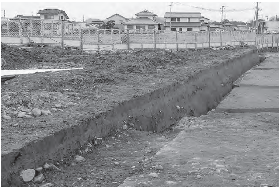
3 河道 3 旧 1 区中央 (北西から)
