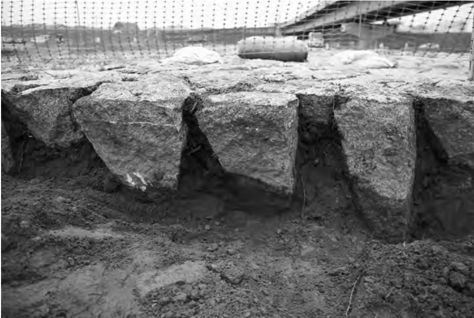
1 越流堤T1 間知石 石積み断面 (南西から)
