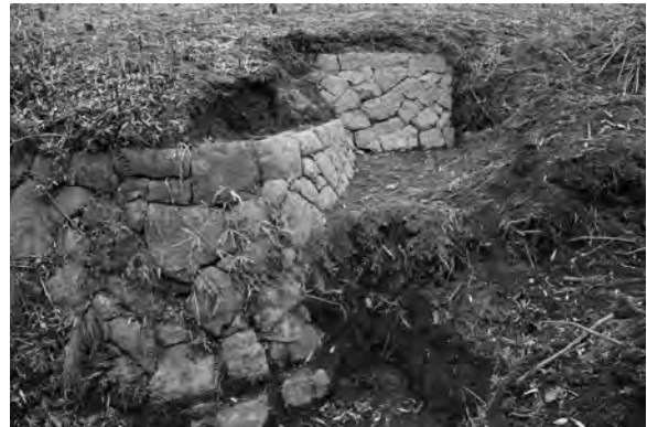
写真9 背割堤旭川側護岸（c地点：北西から） 写真10 背割堤旭川側水制か（d地点：北西から）
