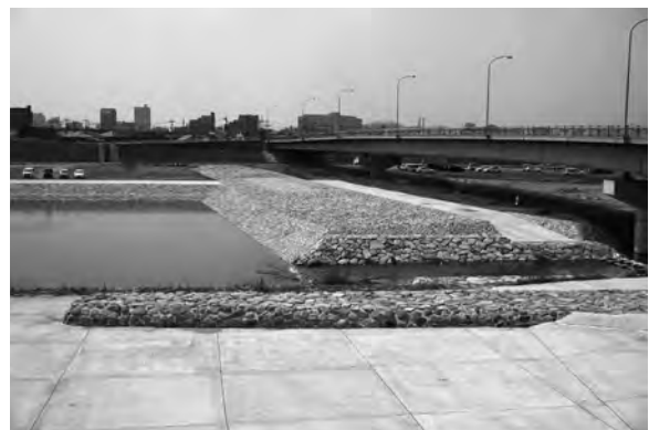
写真5 整備後の二の荒手(東から)
