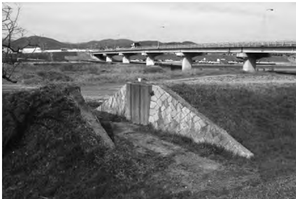
写真2 米田の旧堤防と陸閘
