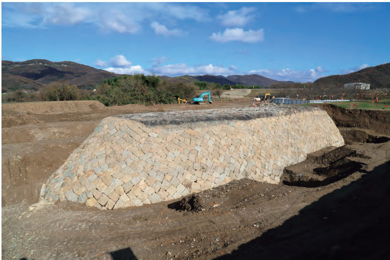
1 一の荒手上流側巻石（南から）
