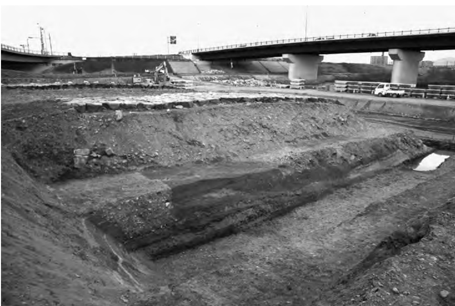
3 越流堤T3 東壁 土層断面 (西から)
