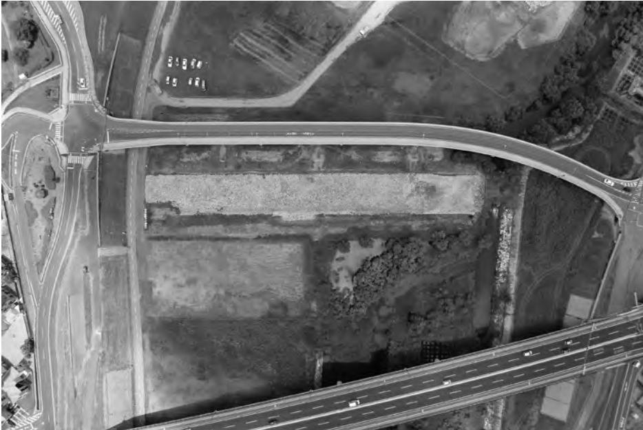
1 二の荒手全景 (直上から、上が北西)
