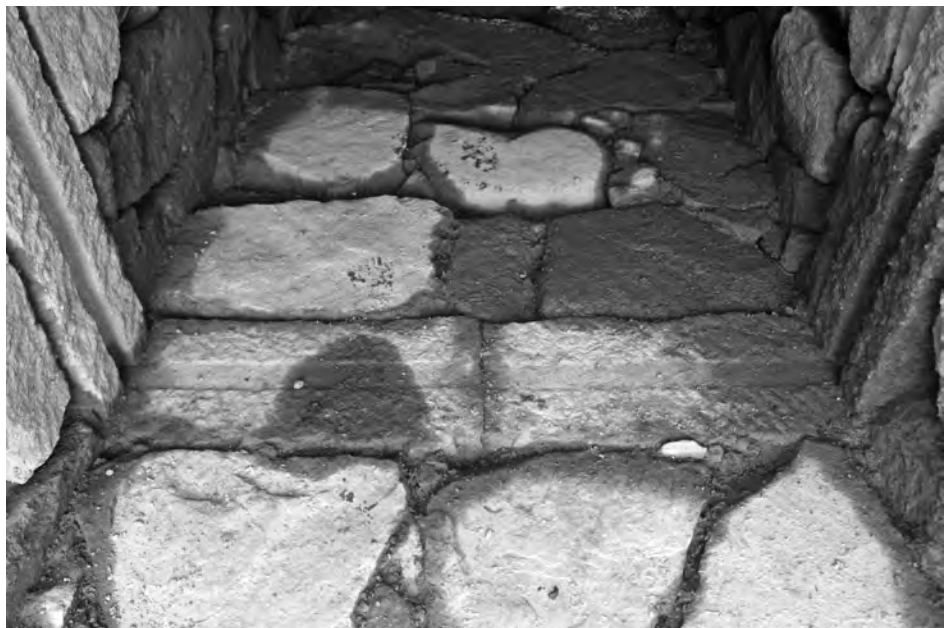
3 背割堤暗渠 樋門底面 (西から)
