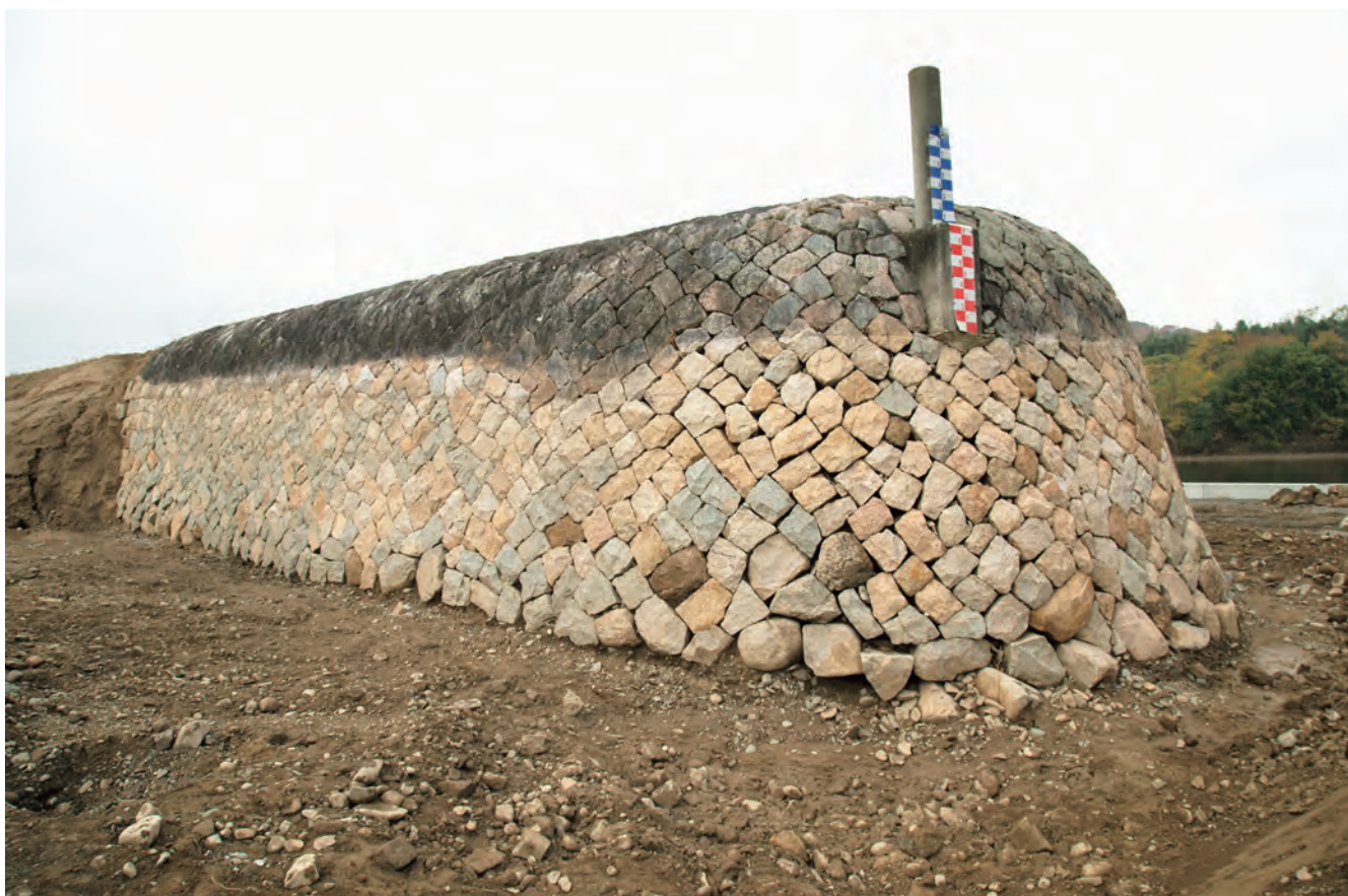
2 一の荒手下流側巻石（東から）
