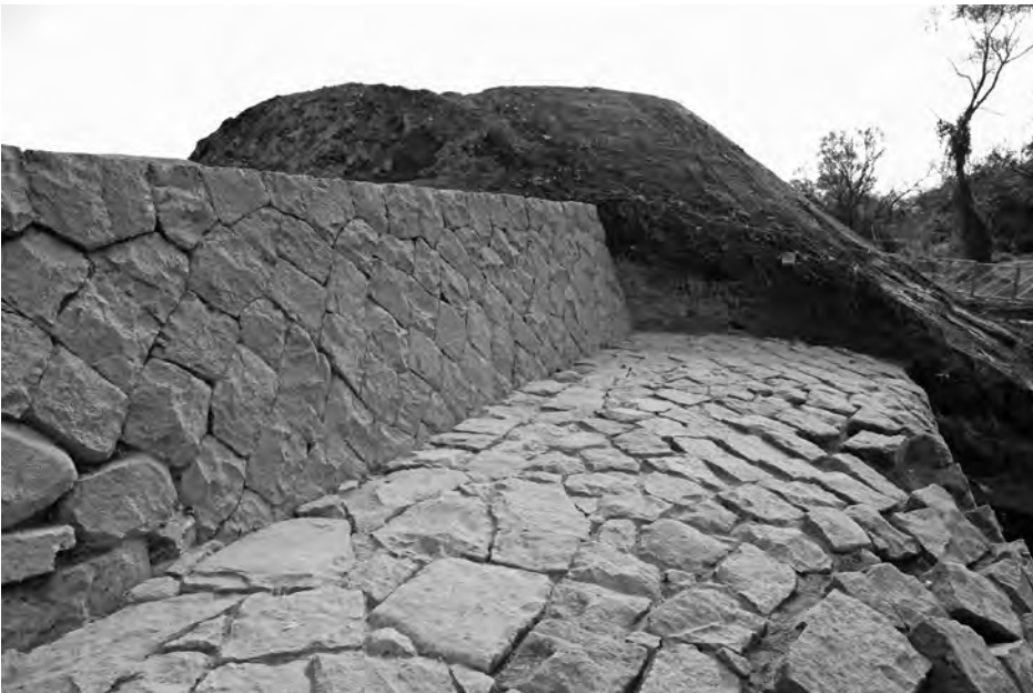
2 背割堤 T 2 旭川側 巻石状石組み (北から)
