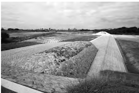
写真4 整備後の一の荒手(北から)
