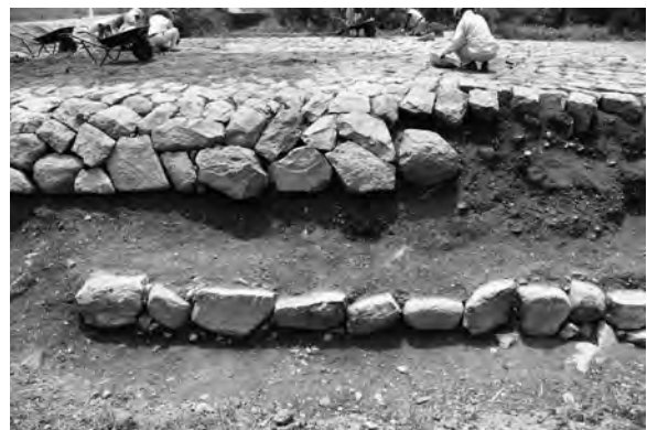
写真14 越流堤北東隅付近の巻石状石組みと石垣基底部(北西から)
