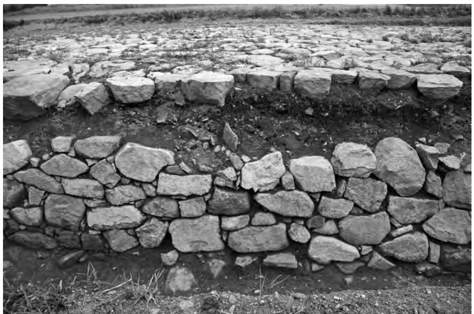
3 越流堤上流側法面 石垣（北西から）
