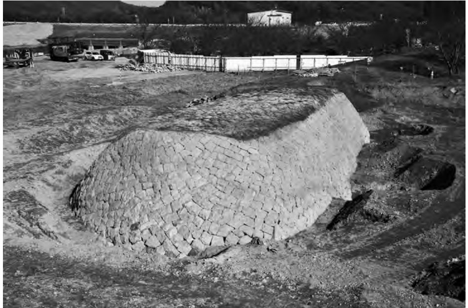
1 上流側巻石全景 (南西から)
