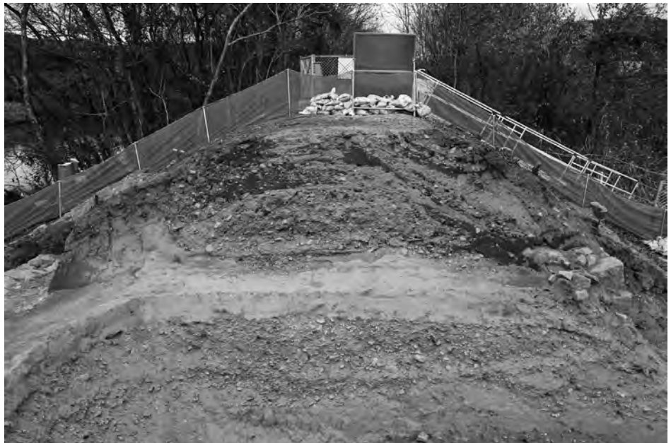
2 背割堤 T 2 北壁 土層断面 (南西から)
