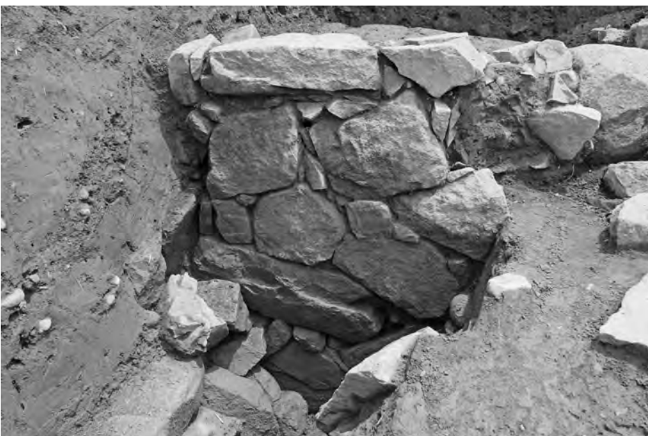
3 背割堤暗渠 旭川側開口部石垣 （西から）
