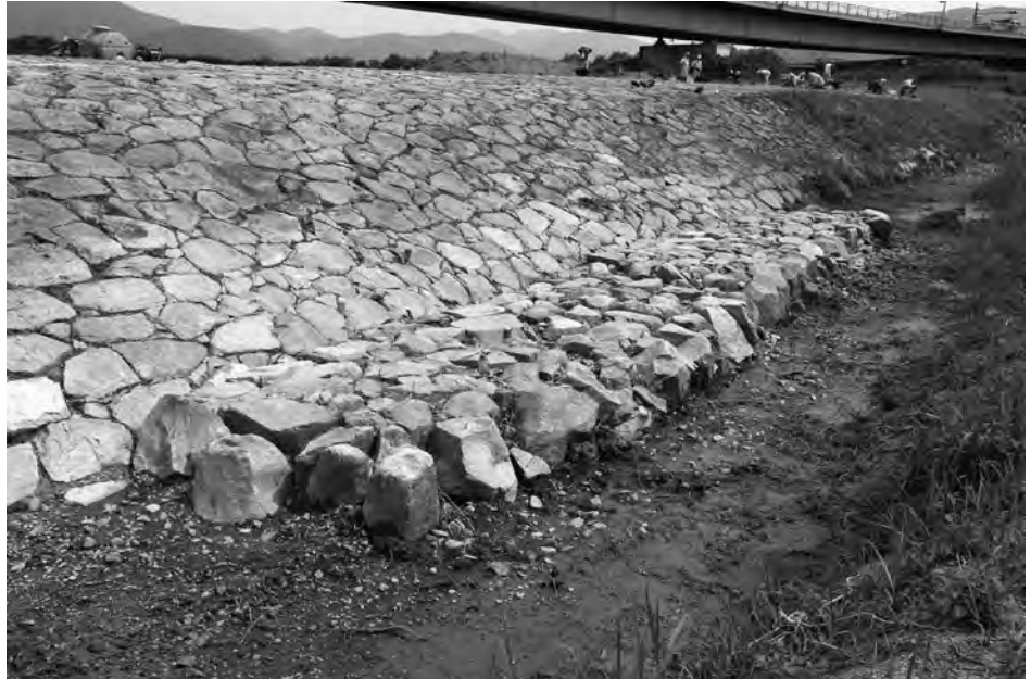
1 越流堤下流側 突出部（南から）
