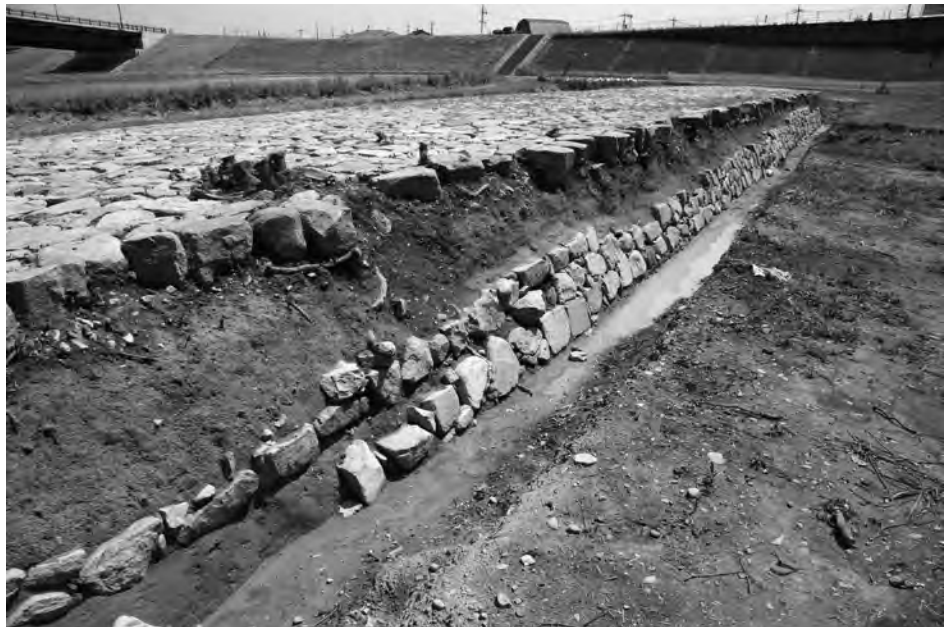
2 越流堤上流側法面 （北から）
