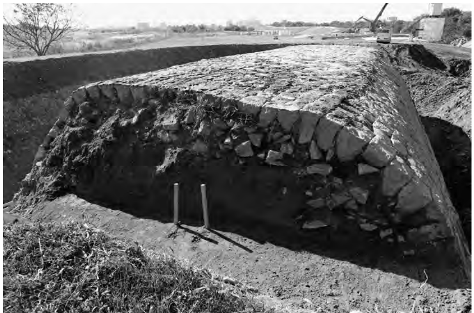
3 上流側巻石断面 (北東から)
