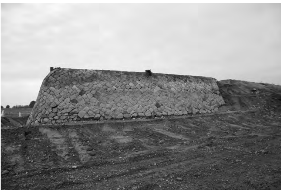
3 下流側巻石 旭川側法面（北西から）
