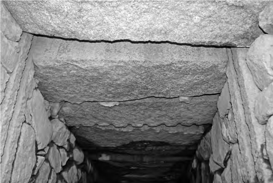
1 背割堤暗渠 樋門上部（西から）
