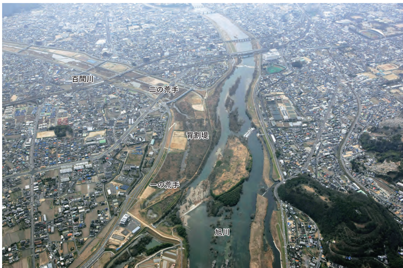
2 百間川分流部全景（北から）
