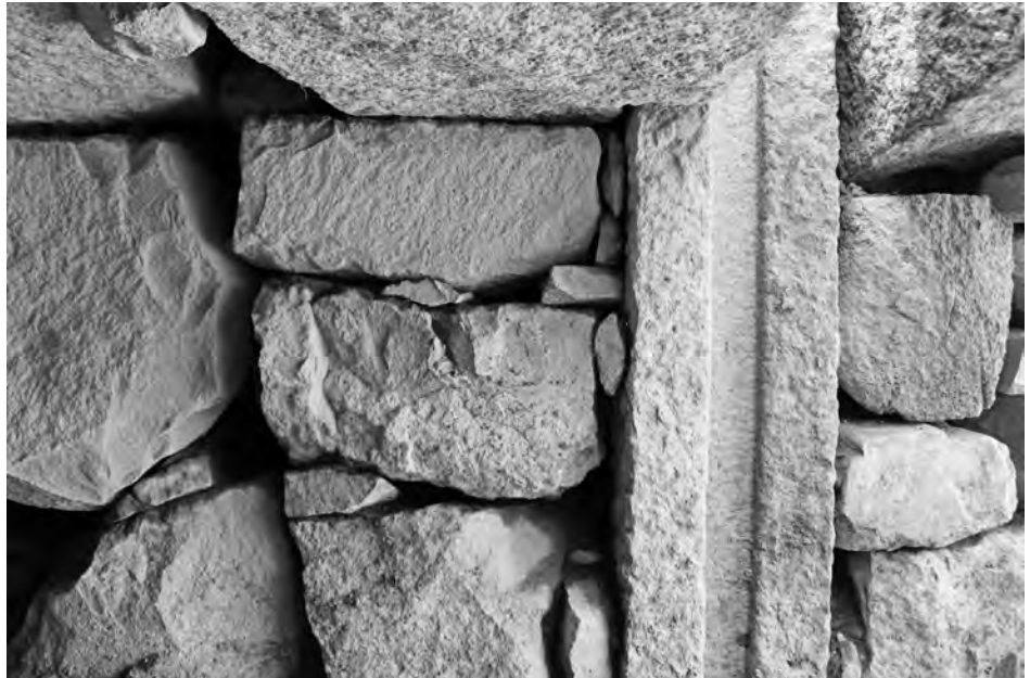
2 背割堤暗渠 樋門南壁 (北から)
