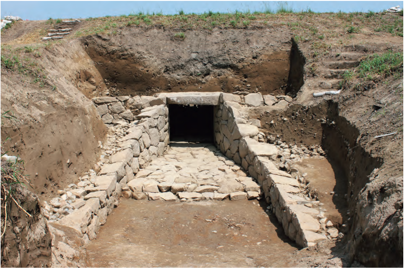
1 背割堤暗渠の旭川側開口部（西から）
