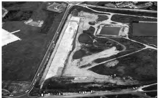
写真20 中島竹田橋竣工前の二の荒手（南西から） （国土交通省岡山河川事務所提供）
