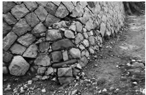
写真7 下流側巻石先端基底部の石積み (北から)
