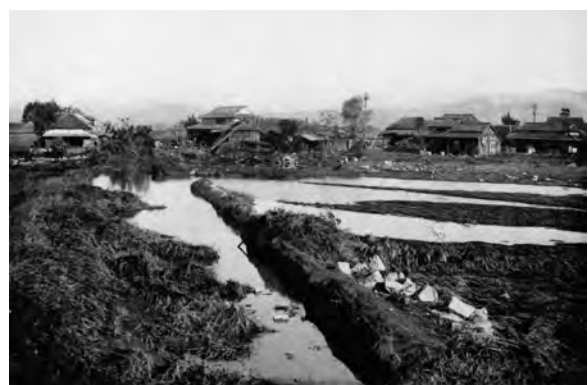
写真1 室戸台風による百間川二本松東側堤防決壊状況（文6より）
