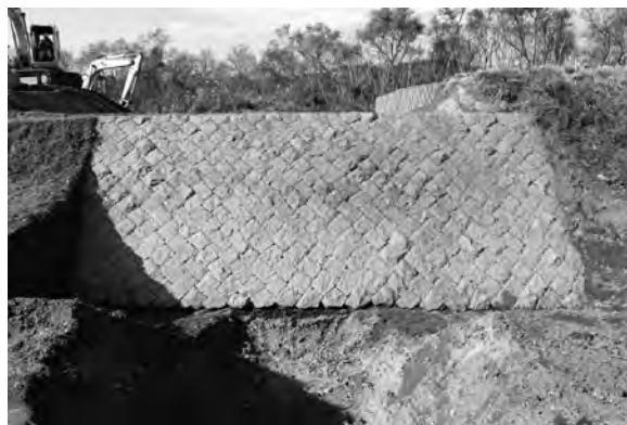
写真12 背割堤 T 4 百間川側石垣（東から）
