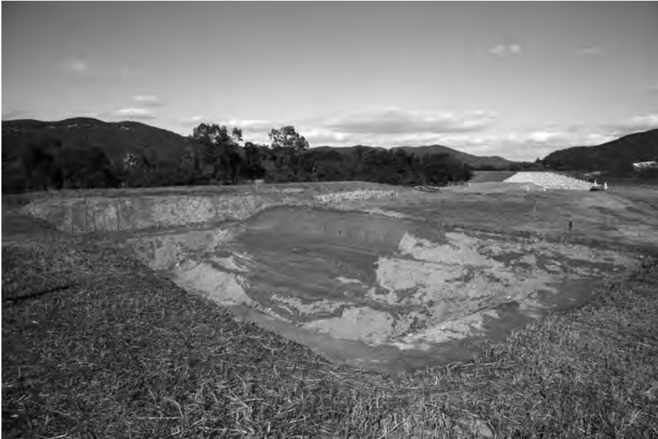
1 越流堤東壁土層断面 (南から)
