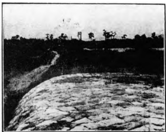
写真18 大正期の上流側巻石(文2より)
