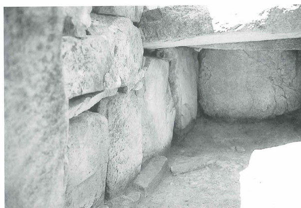
横穴式石室石柵架設状況
