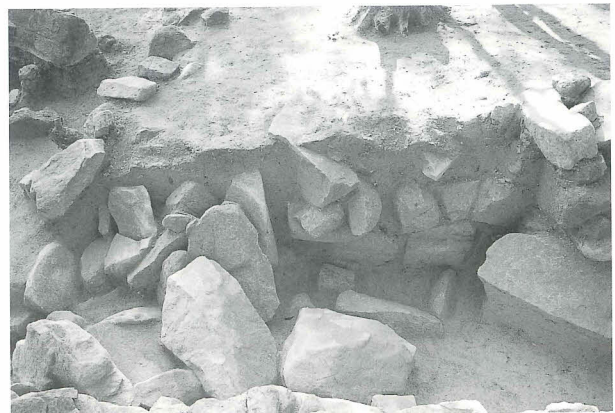
横穴式石室羨道部石材崩落状況
