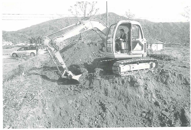
ミニショベル掘削
