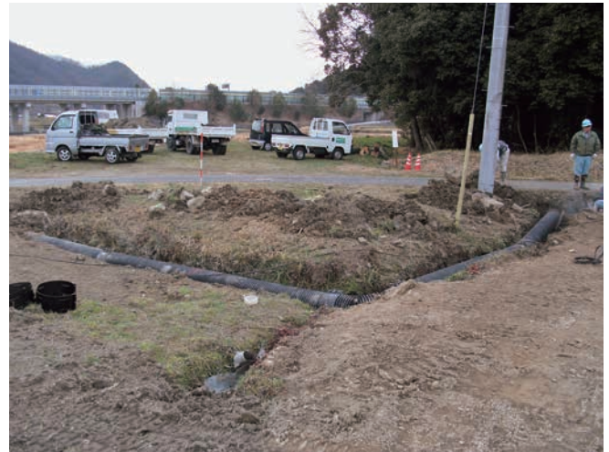
2 暗渠排水管敷設状況 (東から)
