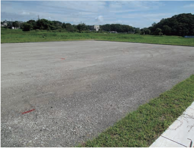
1 砕石路盤工施工状況（南西から）
