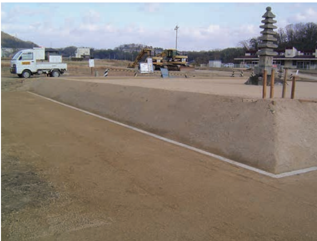
3 基壇盛土・縁石施工状況（南西から）
