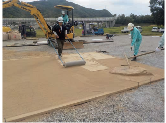
2 真砂土舗装施工状況（北東から）
