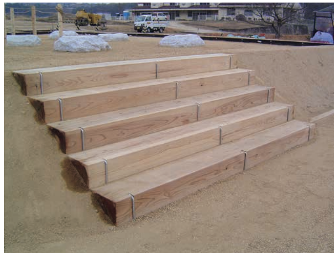
2 枕木階段2施工状況（南西から）
