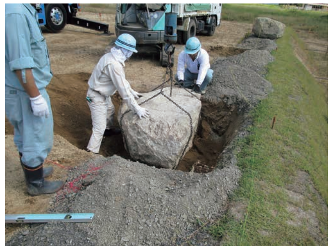
6 礎石（遺構石）表示状況（西から）
