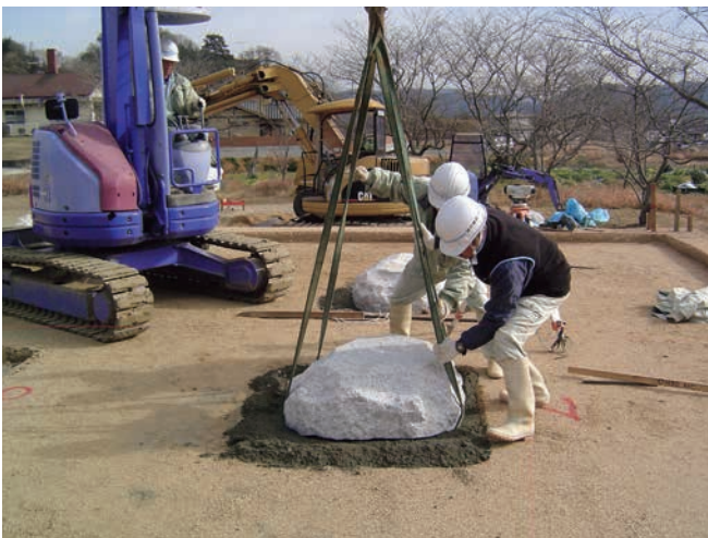
5 模擬礎石施工状況（西から）
