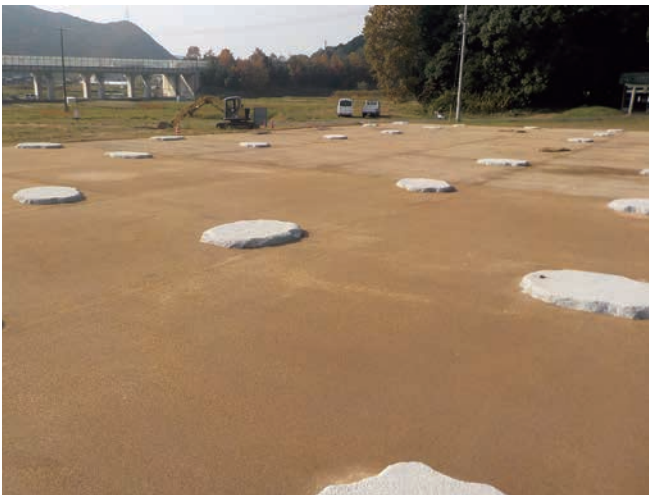
3 真砂土舗装施工状況（北東から）
