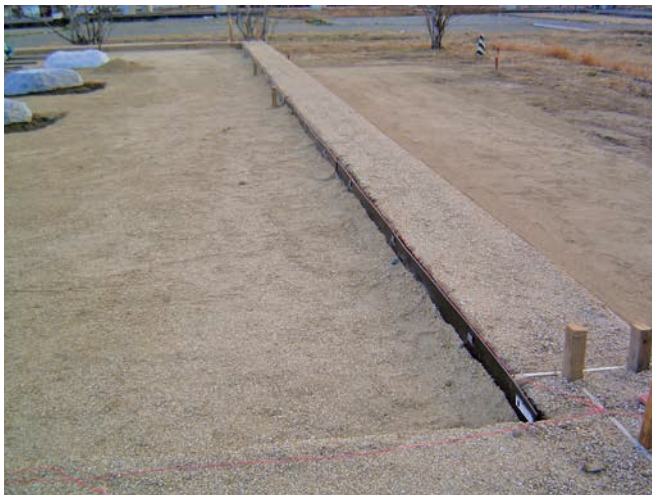
1 舗装止め施工状況（北から）
