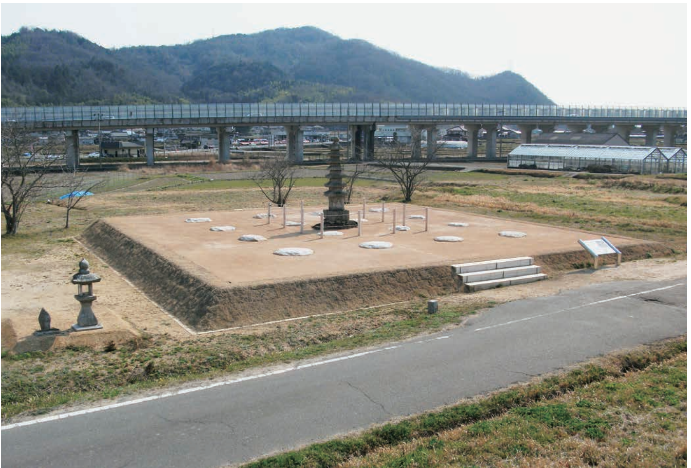
2 塔地区（北東から）
