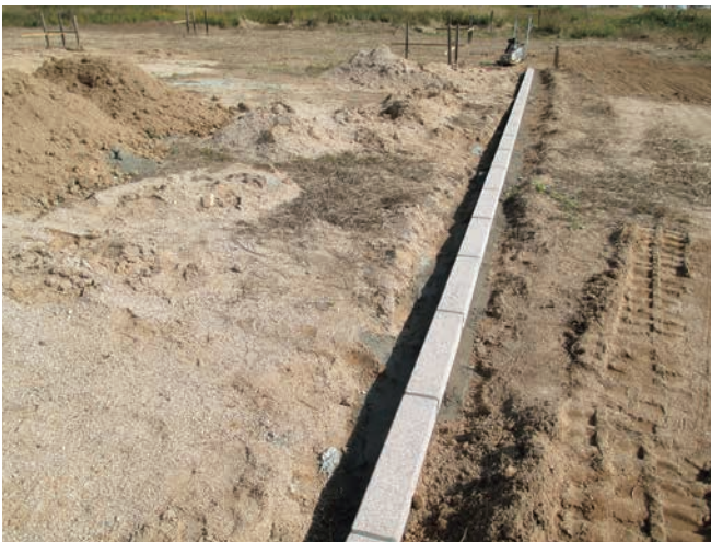
3 縁石施工状況（西から）
