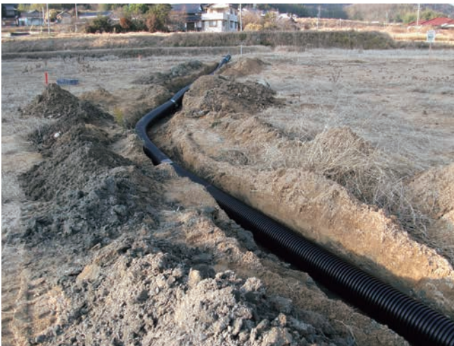
3 暗渠排水管敷設状況 (南から)
