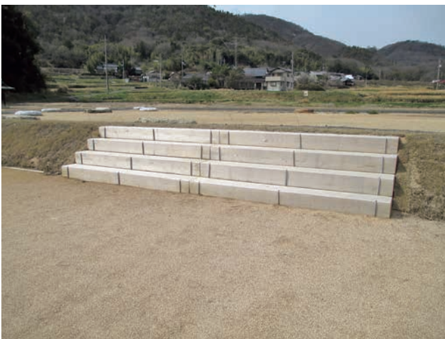
5 枕木階段2施工状況（南から）
