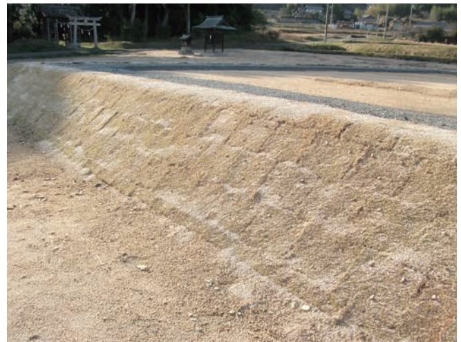
4 張芝施工状況（南東から）
