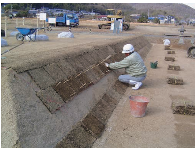
3 張芝施工状況（南東から）
