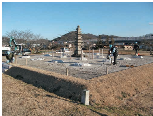
4 碎石路盤工施工状況（北西から）
