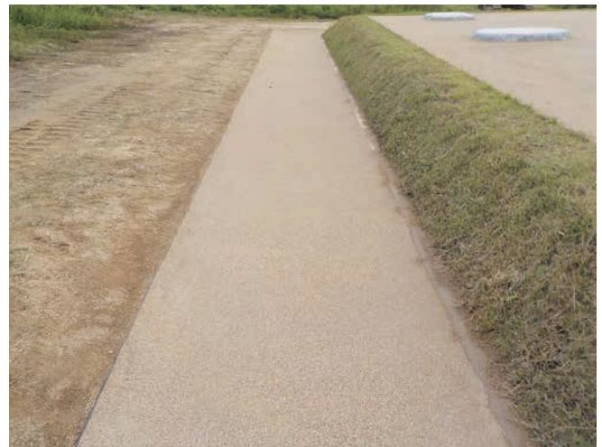
4 雨落溝表示施工状況（西から）
