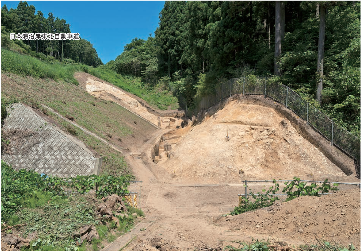
平成28年度調査区（南から）
