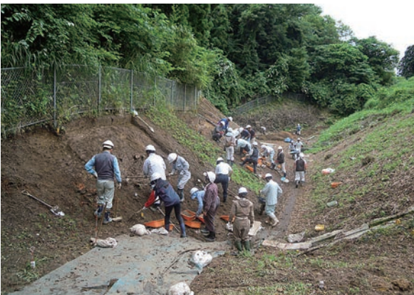
作業風景（北から）
