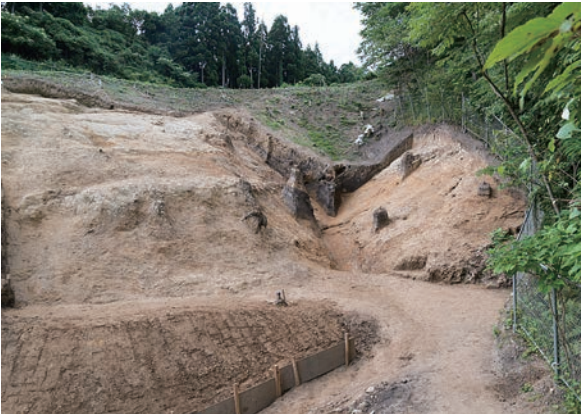
平成29年度調査区（南から）
