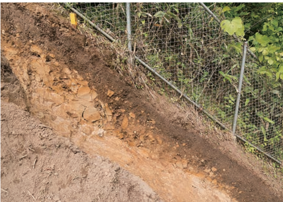
第2トレンチ断面（西から）
