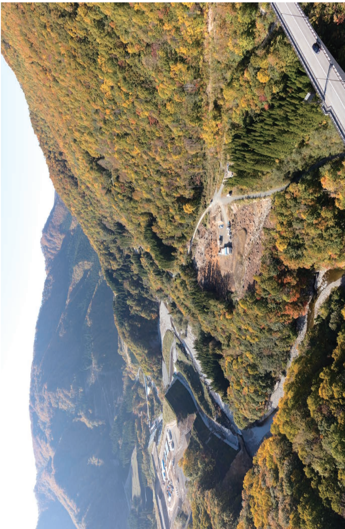
1 トクラ遺跡全景(東側上空から)
