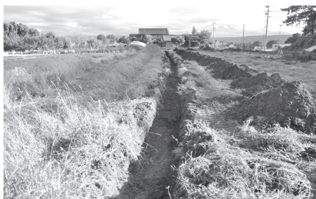
試掘調査状況（北から）
