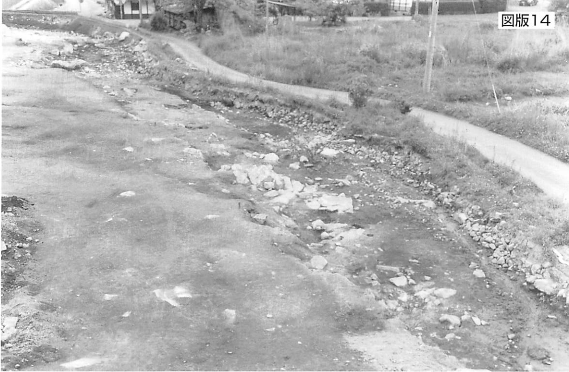
a D区全景 (北から)
