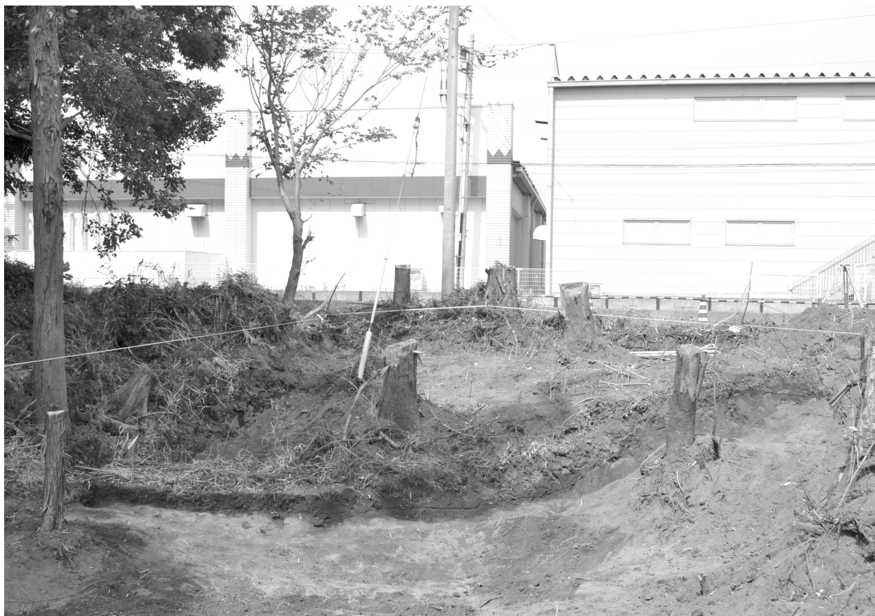
土層断面 SPB-B' (南西より)
