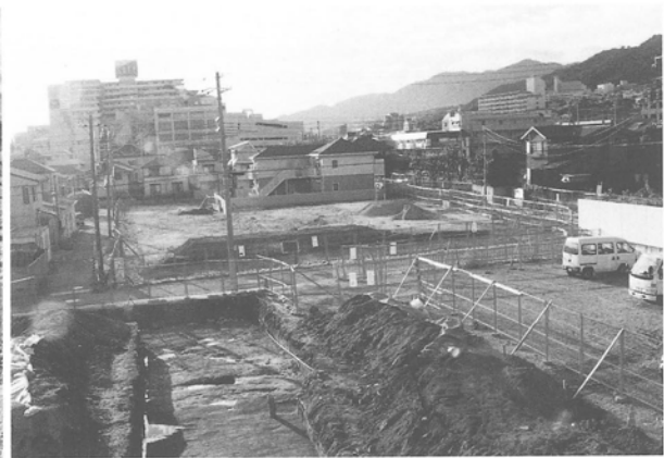
B-15区 東半 (東から)
