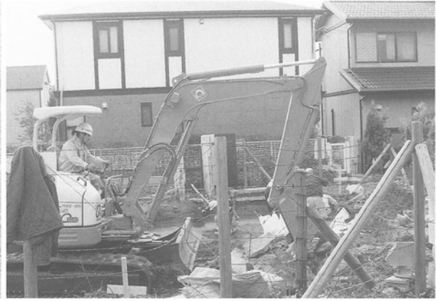
A-3区 機械掘削の状況
