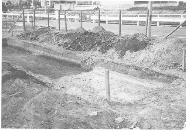
1 トレンチ (南東から)
