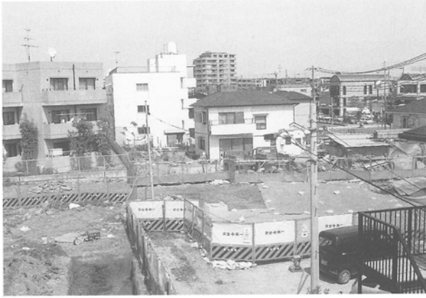
B-6区 全景 (南東から)
