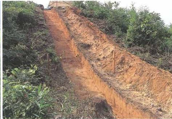
④5 トレンチ西部 若水古墳南東斜面 (南東から)
