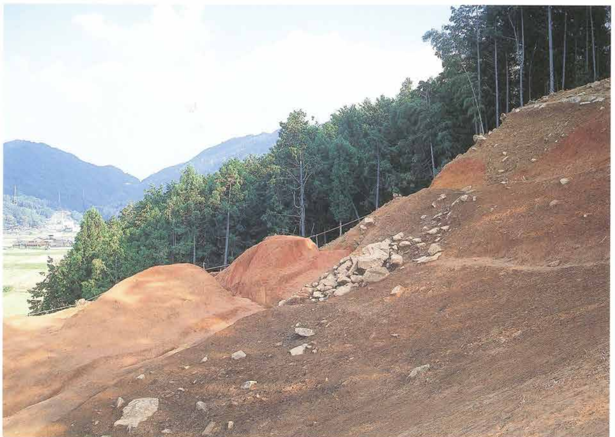
若水城跡 東部地すべりの状況（西から）
