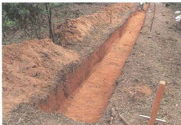
⑦11 トレンチ 全景 (北東から)
