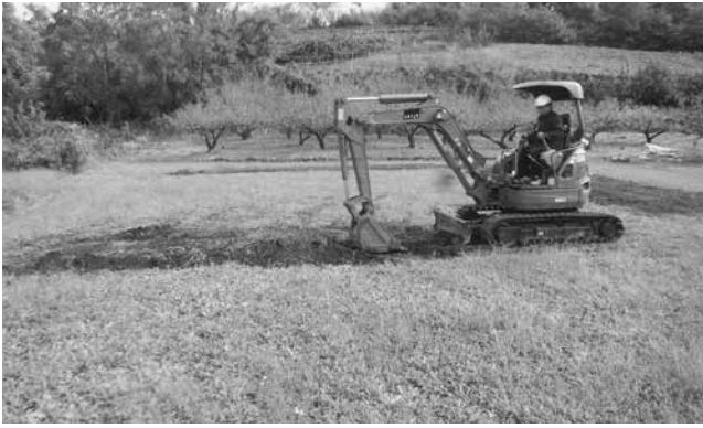
重機による掘削（表1③）
