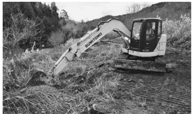
重機による掘削（表1⑳）
