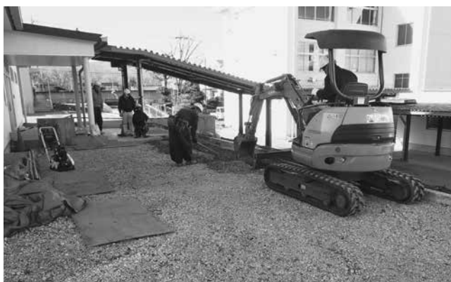
消火管埋設工事立会調査状況
