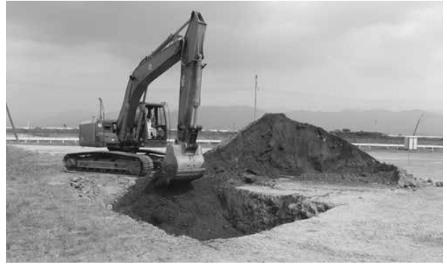
重機による掘削（表1①）
