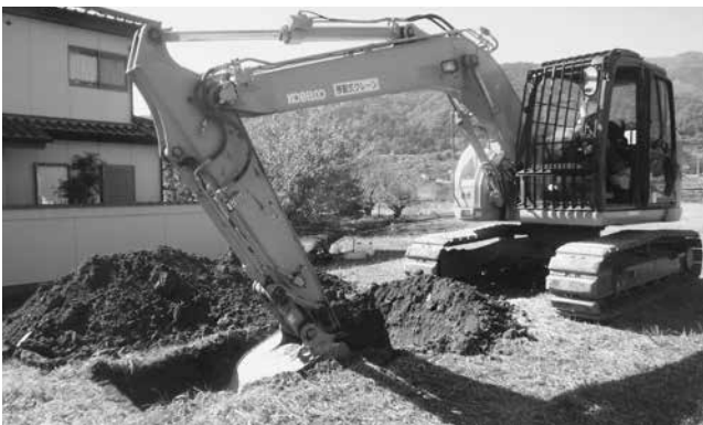
重機による掘削（表1⑬）
