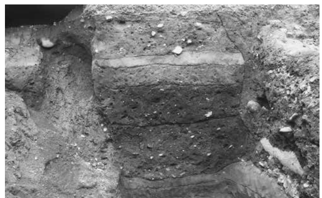
排水管埋設工事トレンチ断面
