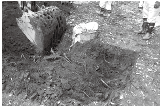
ケヤキ抜根作業立会 追加調査の実施
