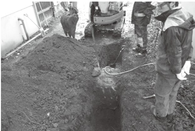
給水管工事立会 追加調査の実施
