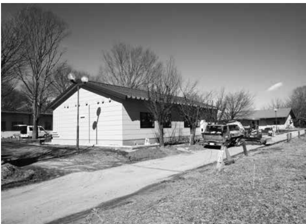
調査後の施工状況
