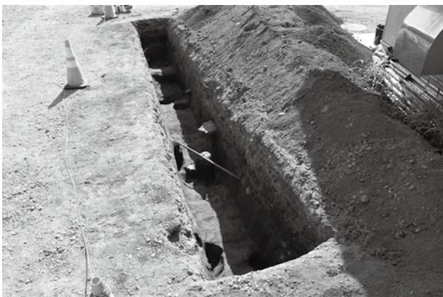
外構C区地点 完掘状況
