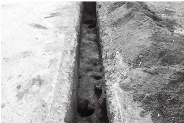
電気配管埋設工事立会 14号住居跡の調査
