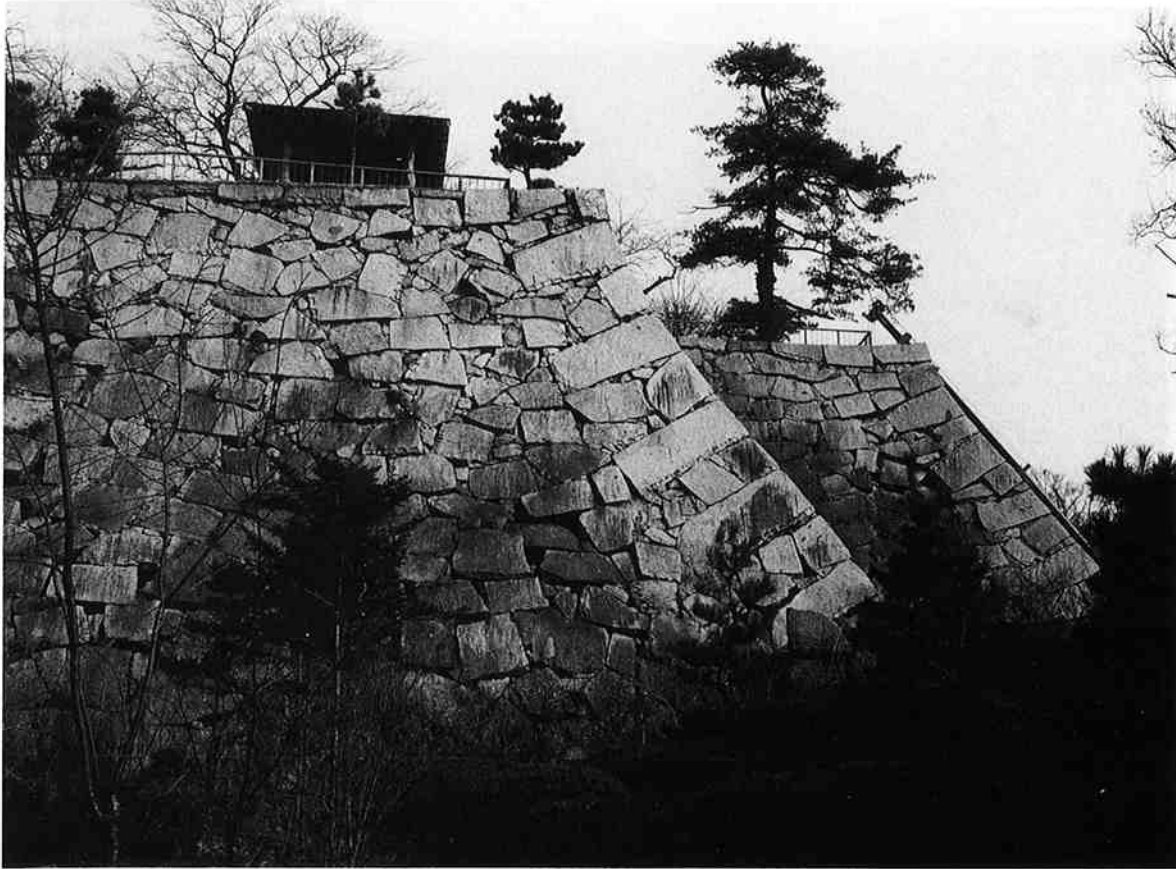
腰曲輪 二階橋石垣 (S→N)
