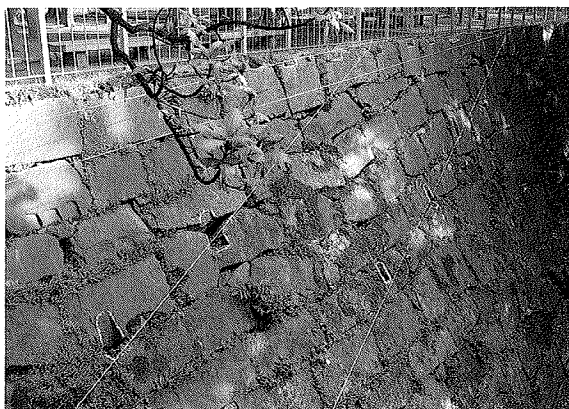
柱脚切込み改修部 (本丸西面)
