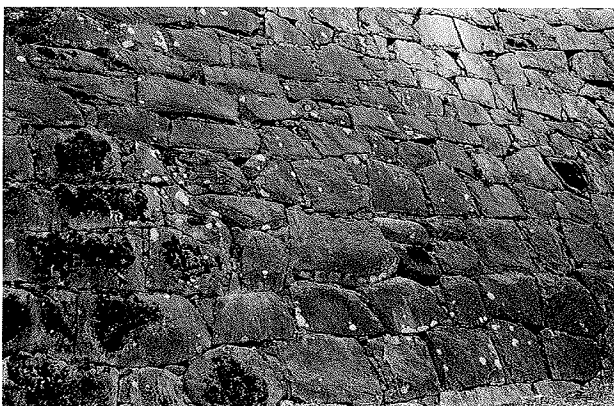
整層積B改修部（二ノ丸北東部）
