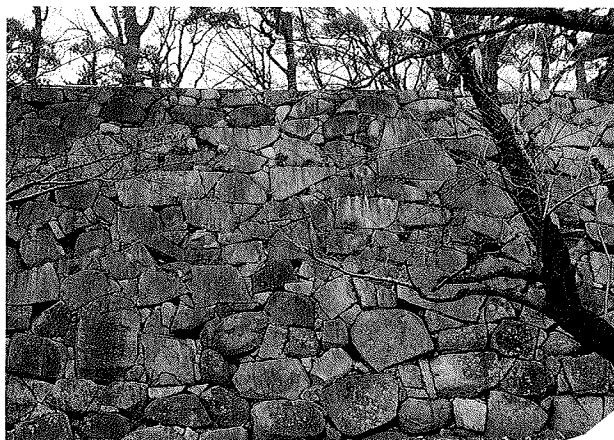
乱層積A改修部（本丸南面）
