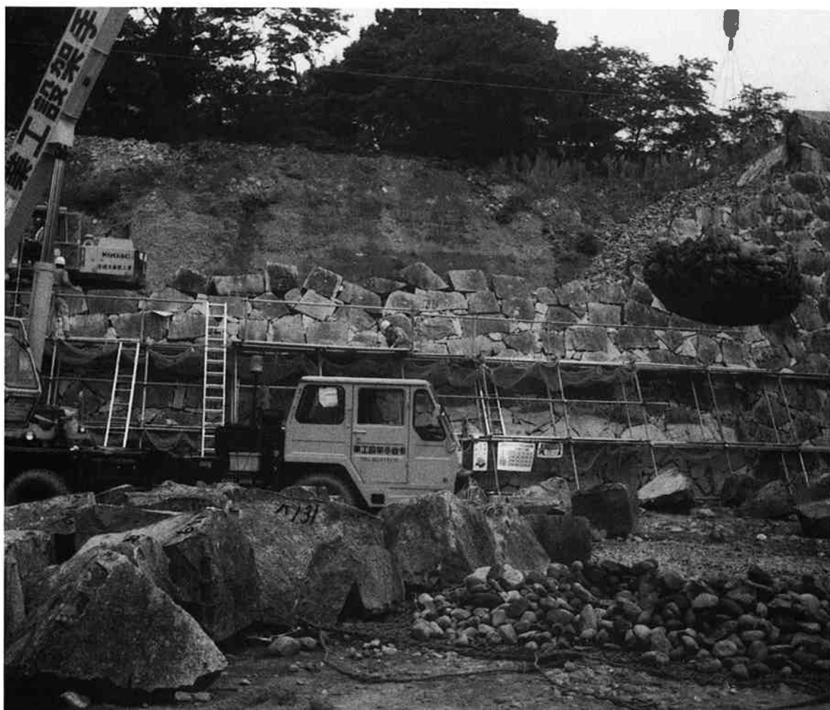
裏込栗石投入 (トラッククレーン)
