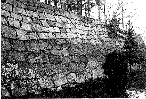
整層積 D 改修部 (三ノ丸北面)
