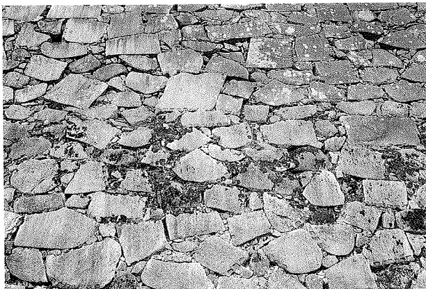
乱層積B (三ノ丸南東面)
