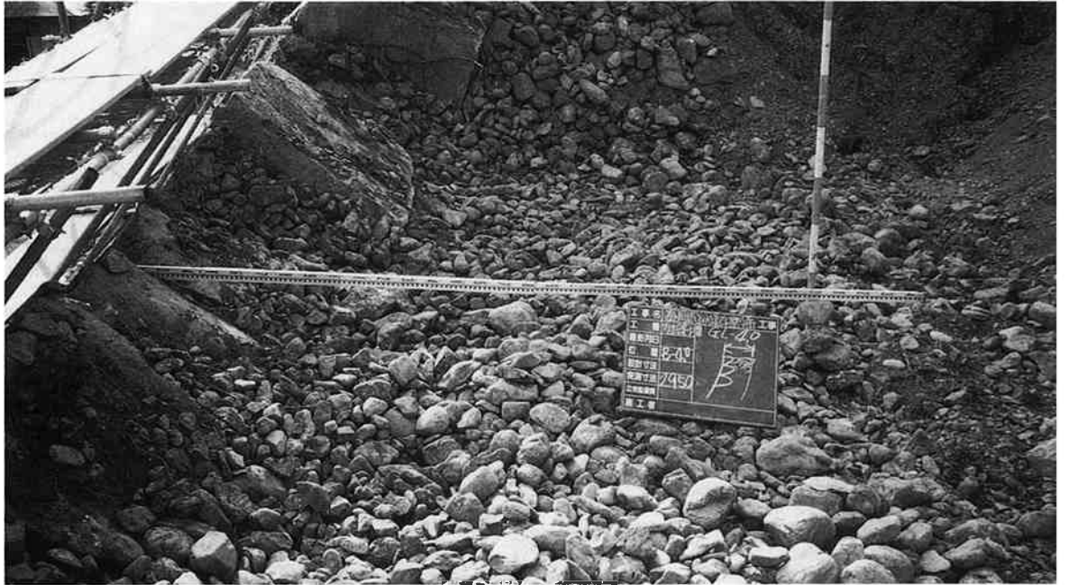
既設栗石幅の測定
