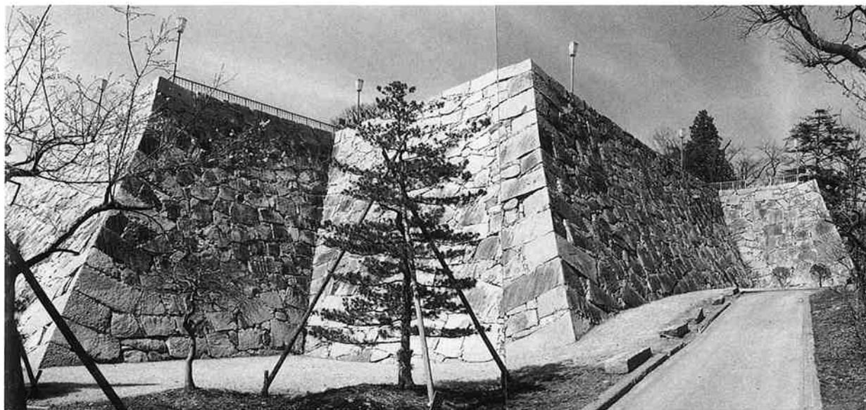
淡路丸南東隅
