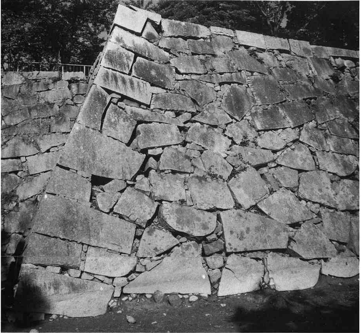
淡路丸南東隅
