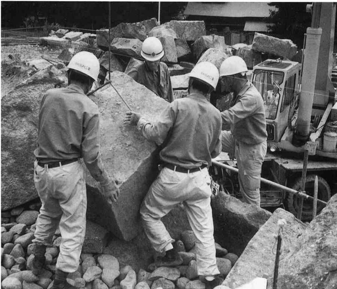
石積復原・礎盤石
