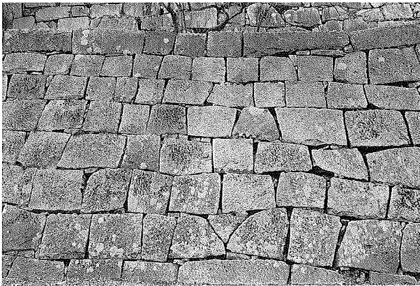
整層積 E 改修部 (二ノ丸東側)
