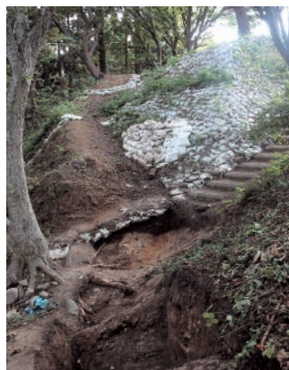
3. トレンチ2 完掘状況(北西から)
