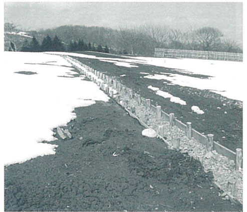
5・6 敷地・地割界溝整備状況
