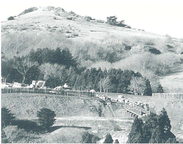
1 木橋・柵整備工事
