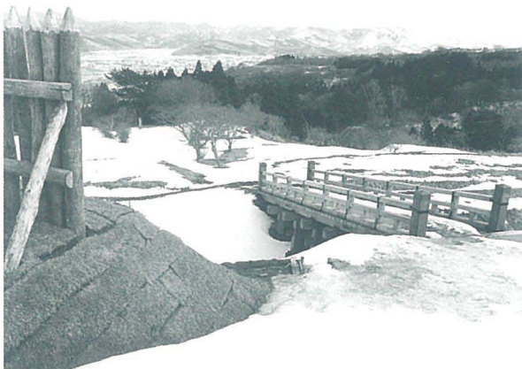
5 柵、木橋整備状況
