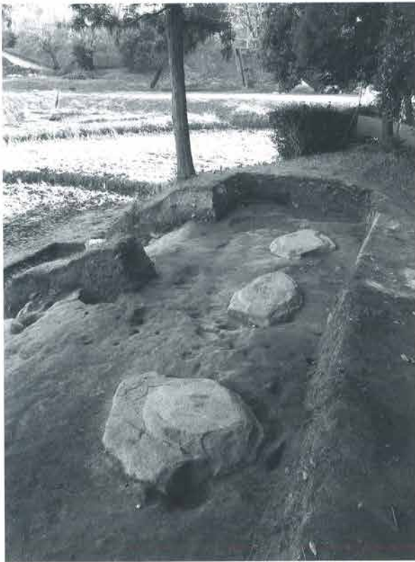
基壇・側柱礎石検出状況（北西から）
