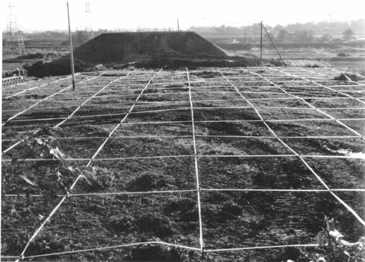
2. グリッド設定状況 北東より
