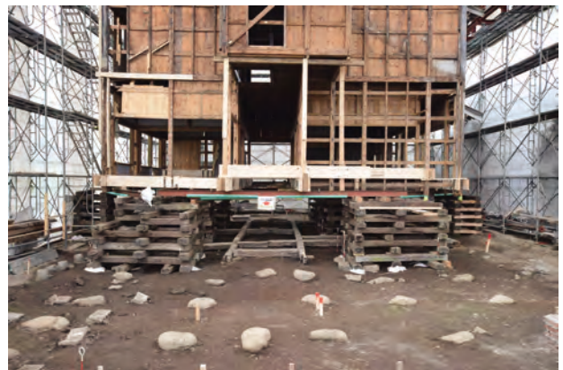
ジャッキアップ完了 (1.5 m)
