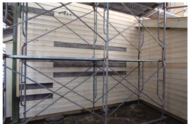
下見板張り施工完了「北棟」北東よりみる
