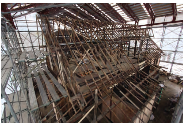
小屋組立完了「南棟」南西よりみる
