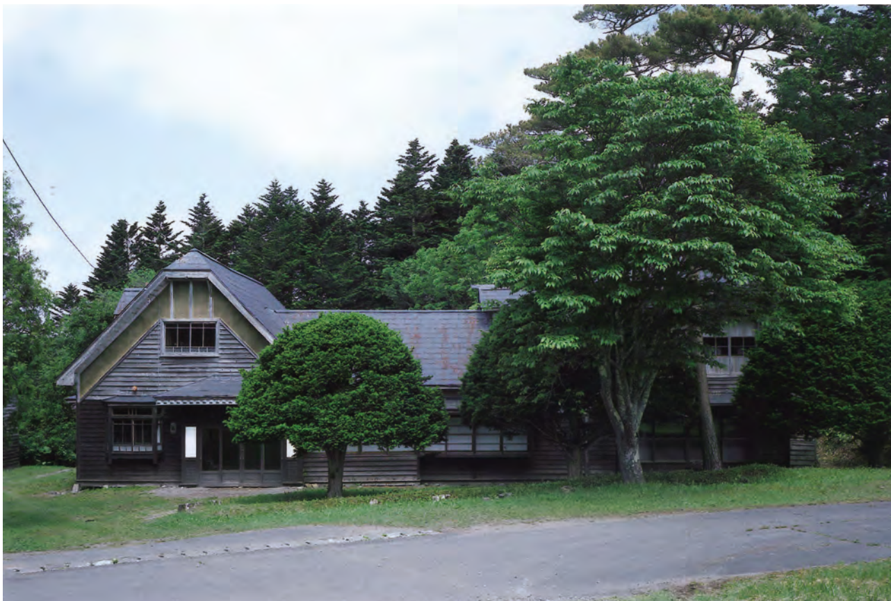
【修理前】外観正面（東面）
