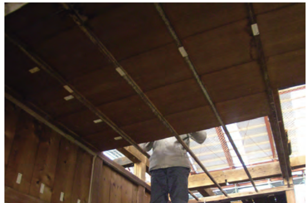
天井解体状況「南棟」廊下 北東よりみる
