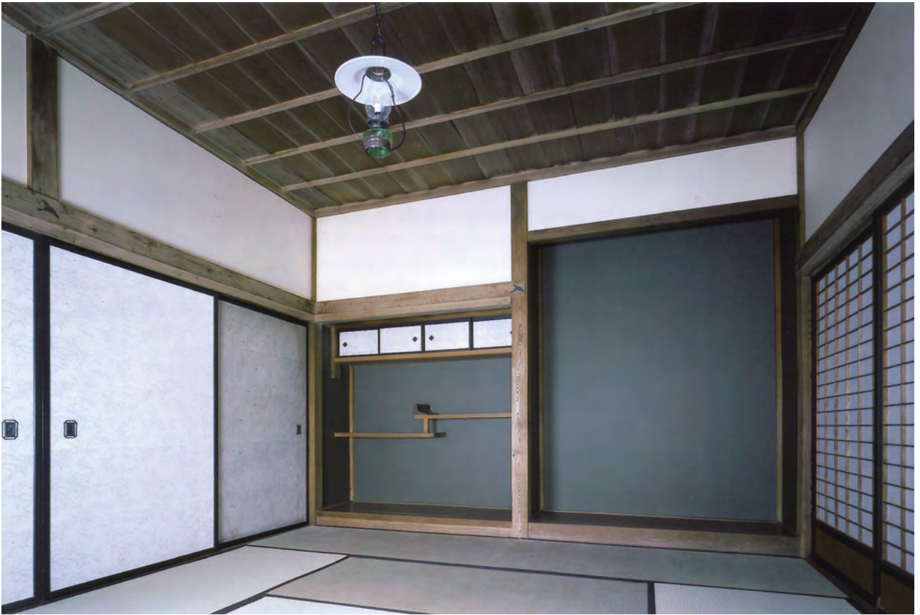
竣工 客室 5 南東よりみる
