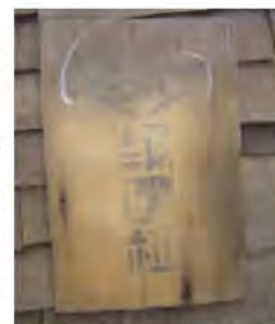
写 3-5-16 桁板の印字 <報国桁> (昭和 16 年)
