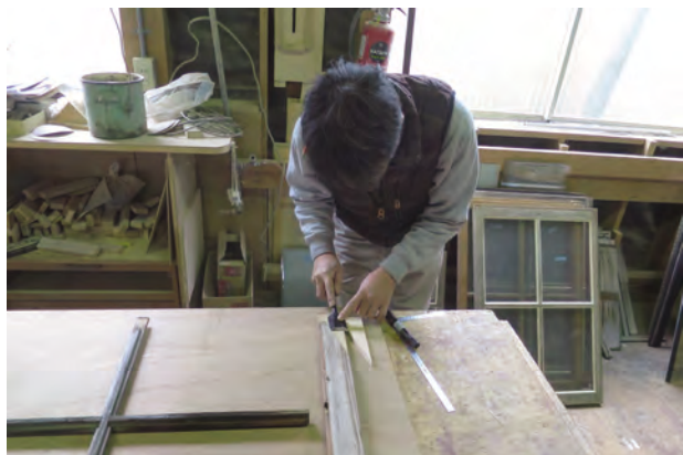
框繕い作業状況
