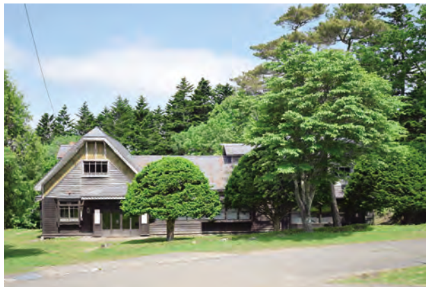
【修理前】外観正面（東面）
