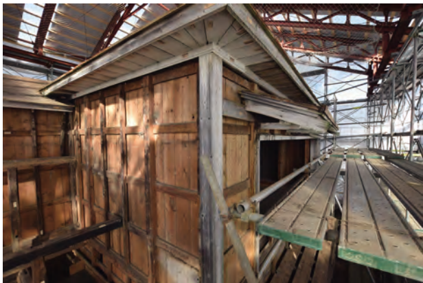
下見板解体完了 二階 南東よりみる
