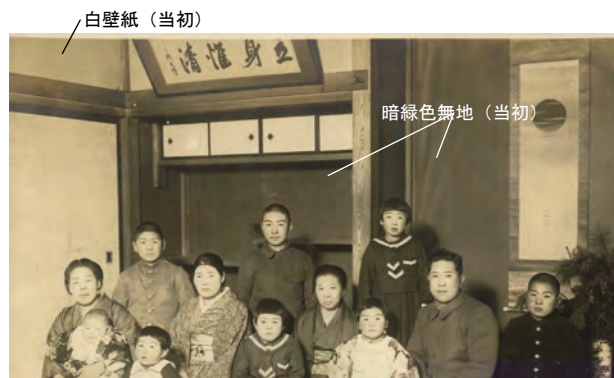
写 3-5-37 客室5の壁紙仕様 (昭和15年頃)
