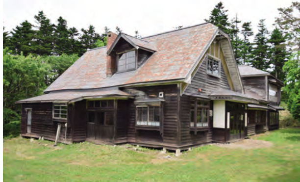
【修理前】外観 南東より
