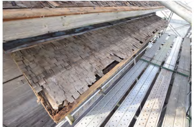
桁葺 東側庇 南東よりみる
