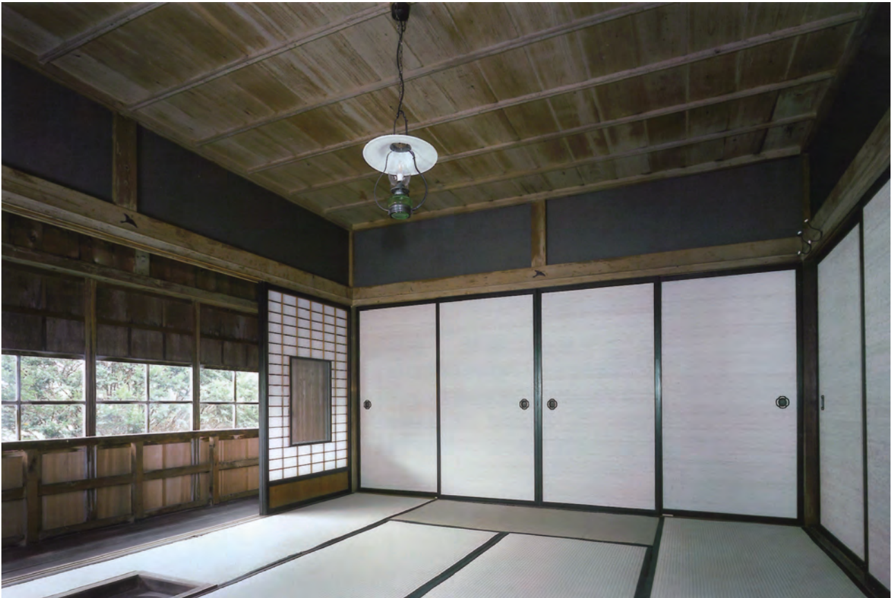
【竣工】 客室 8 北西よりみる
