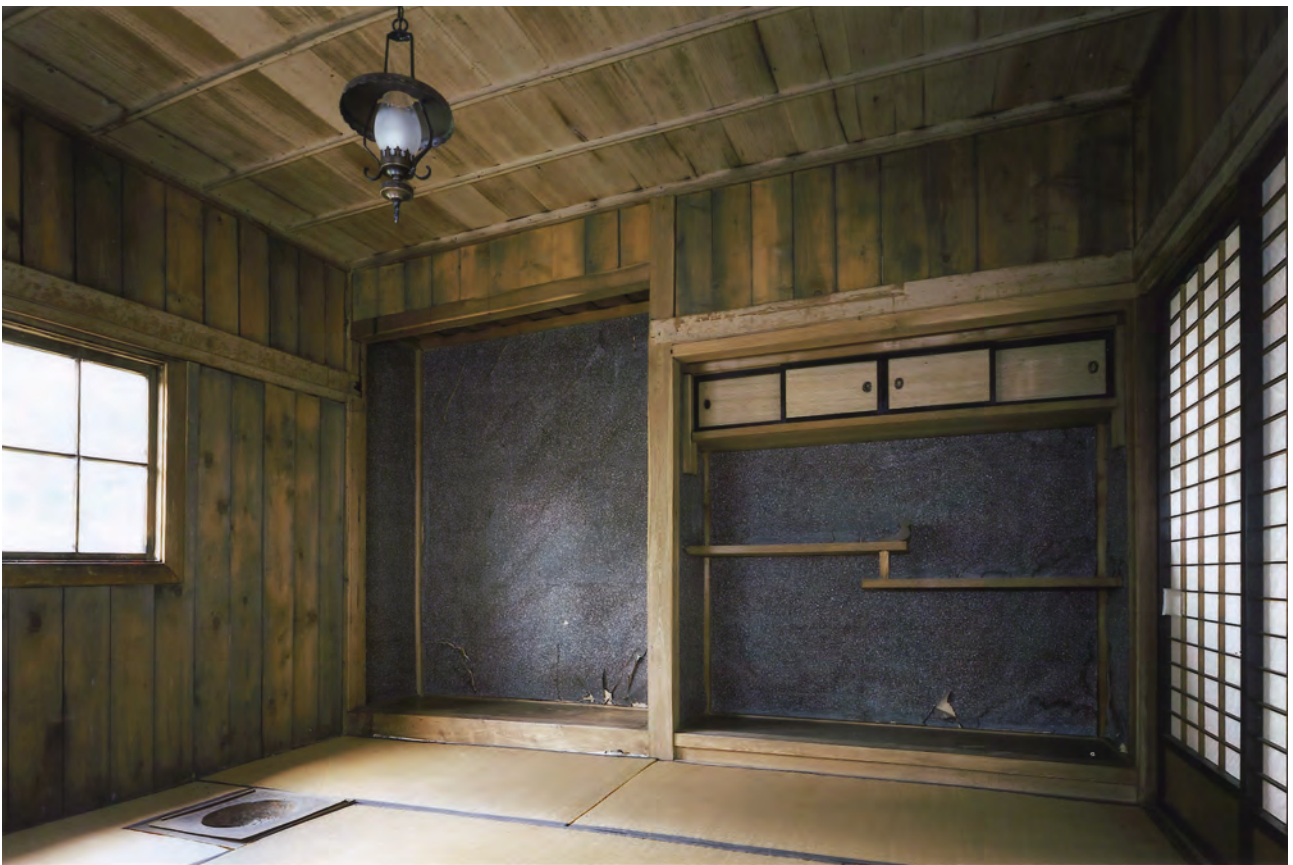
【修理前】客室 7 南東よりみる
