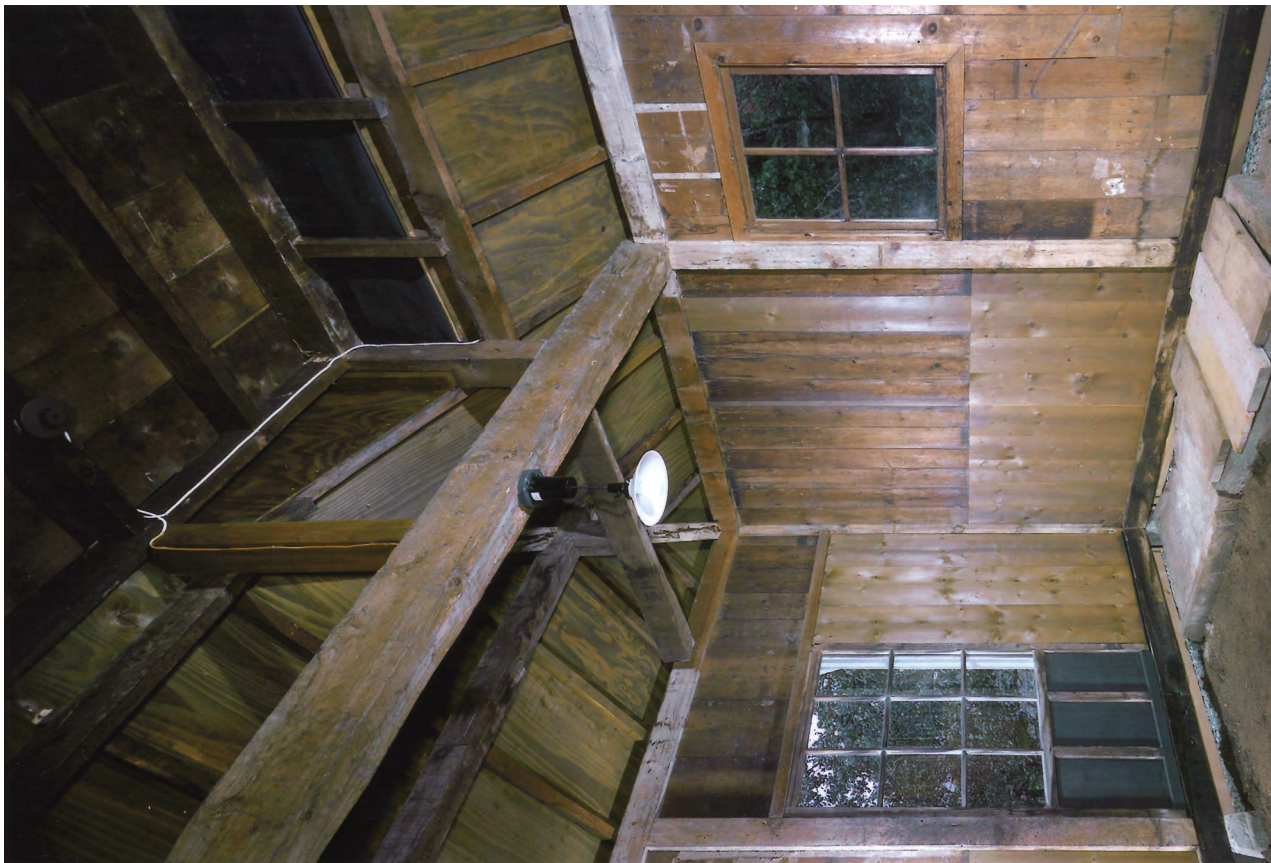
【竣工】物置 北東よりみる
