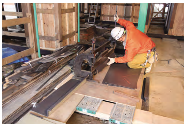
板金加工状況
