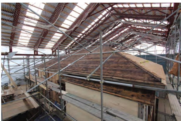
野地板施工完了「北棟」北西よりみる
