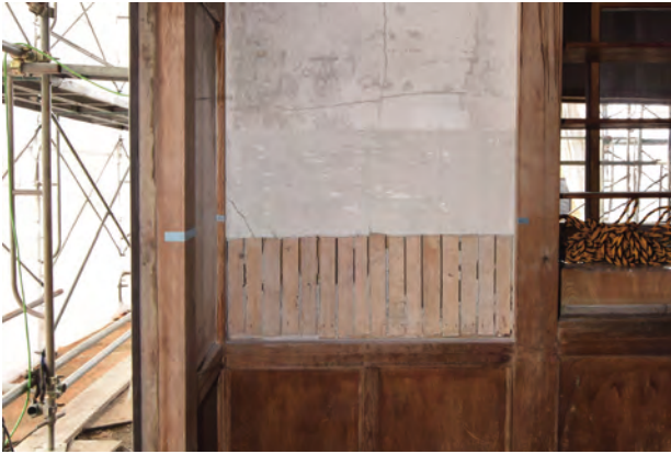
壁面層出し 玄関内脇壁 南側
