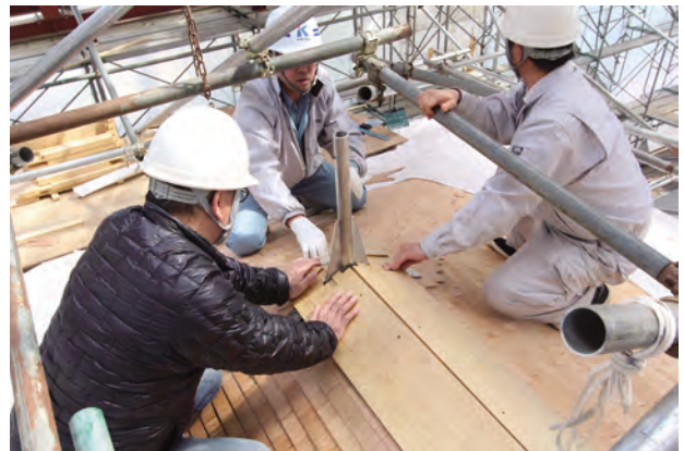
補強金物据付状況
