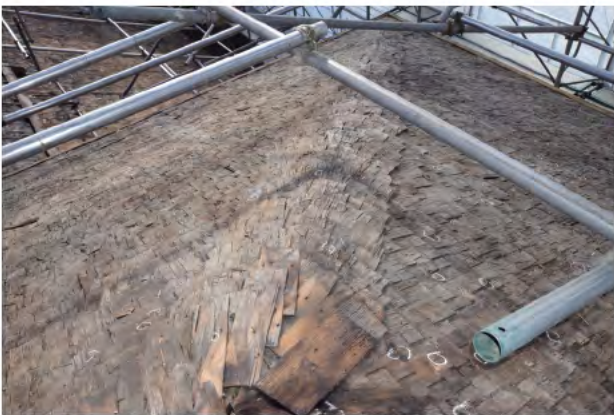
遺存していた桁葺の隅棟
