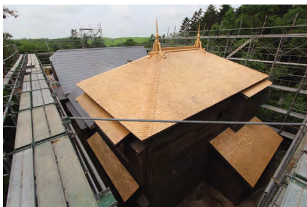
葺葺施工完了「北棟」北東よりみる
