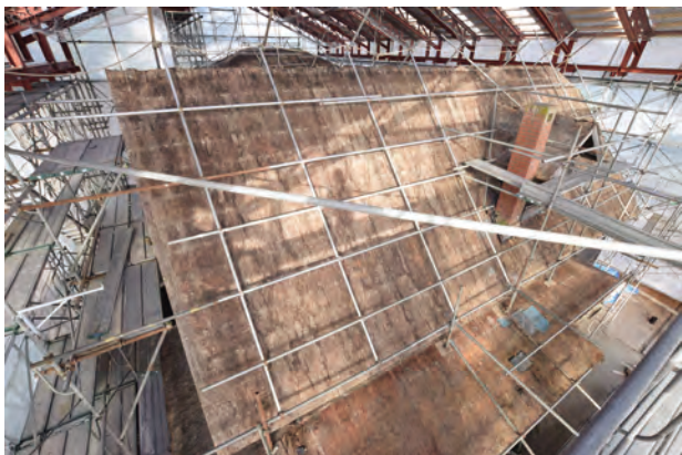
鋼板葺解体完了 桁葺
