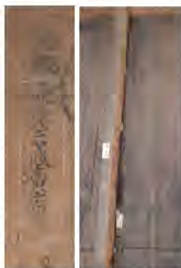
写3-5-7 天井板の印字 左：事務所、右：廊下
