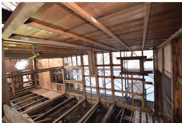
縦板張解体完了 客室2北東よりみる
