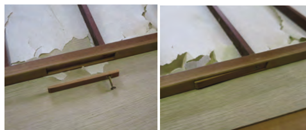
写 3-5-26 摺り上げ障子の機構
