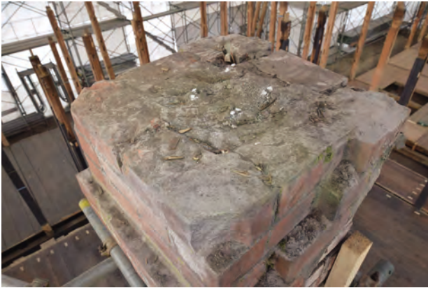
写 3-5-48 煙突後補部を撤去した状況 当初煉瓦の二階床レベル付近までコンクリートが充填されている。
