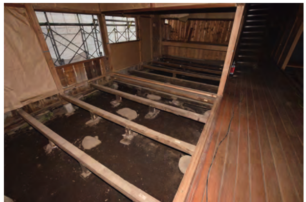
大引 客室1、2 南東よりみる
