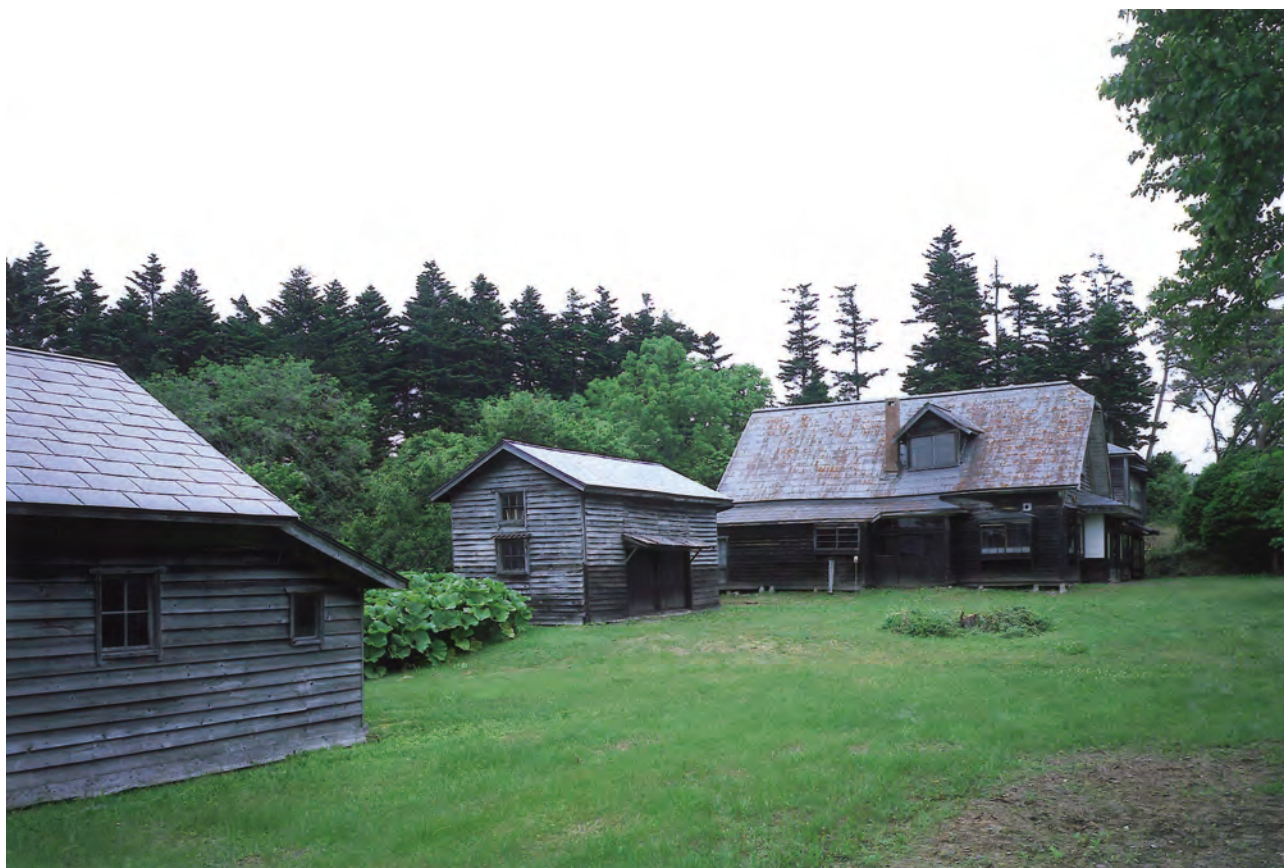
【修理前】外観 南東よりみる
