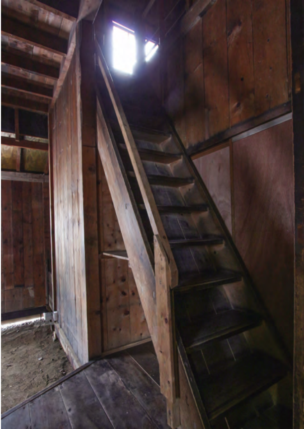
【竣工】「南棟」階段 南東よりみる
