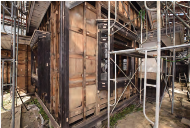
下見板解体完了 南東よりみる
