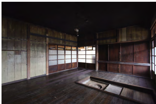
【竣工】居間 南西よりみる
