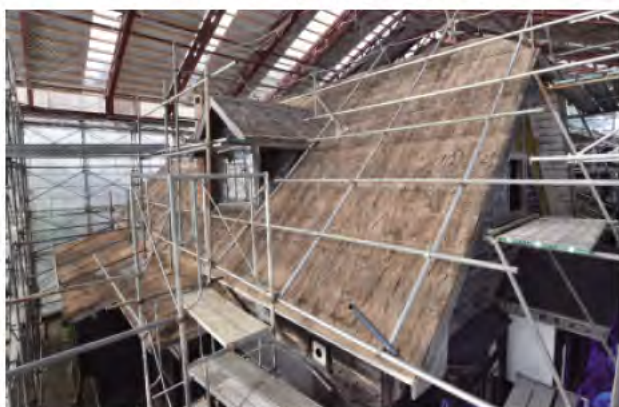
写 3-5-14 「南棟」 下葺とした桁葺
