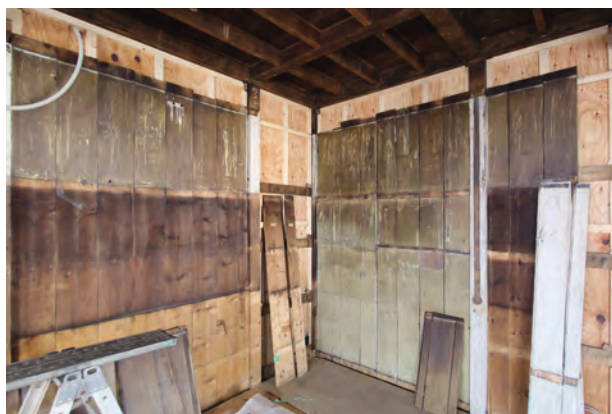
化粧板施工状況 居間 南東よりみる
