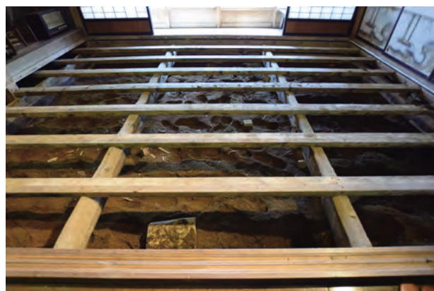
荒床解体完了 床組 客室5 西よりみる
