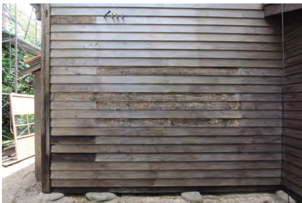
古色塗り完了「北棟」北面
