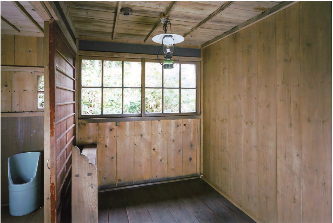
【竣工】洗面所 南西よりみる
