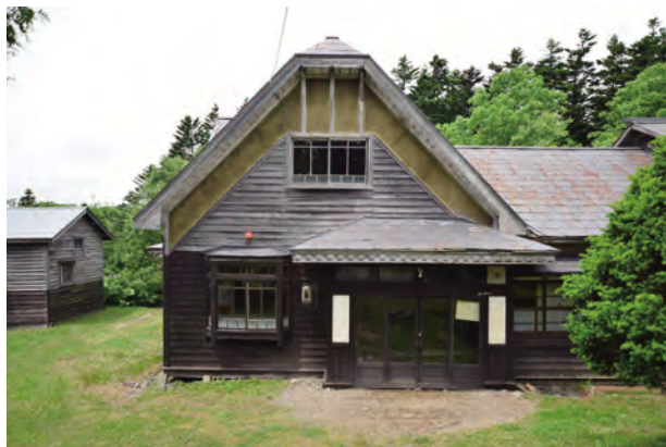
【修理前】「南棟」正面
