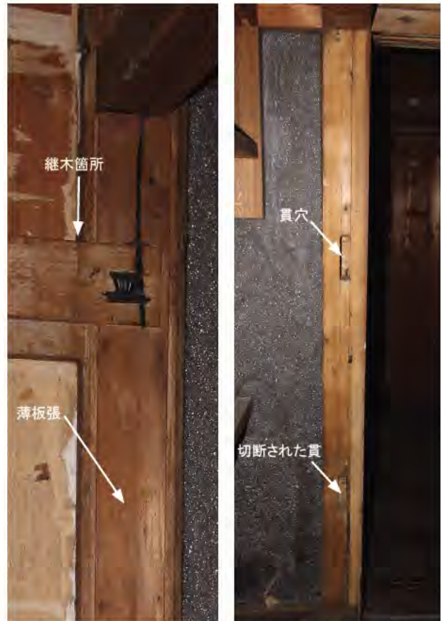
トコ長押の継木（北西角柱）
