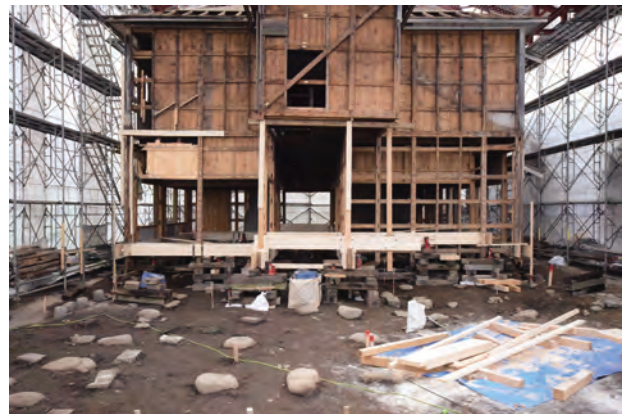
ジャッキアップ状況
