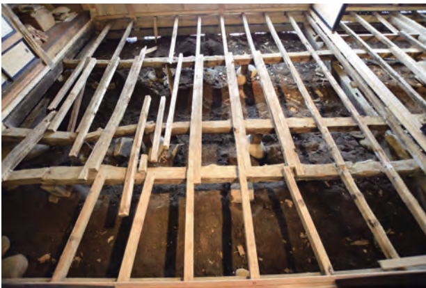
荒床解体完了 床組 仏間 西よりみる
