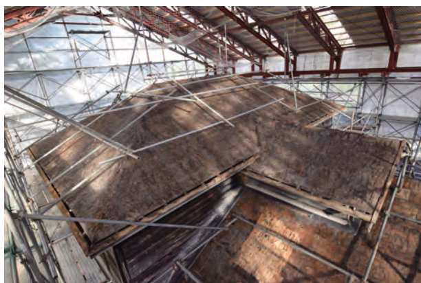
鋼板葺解体完了 桁葺
