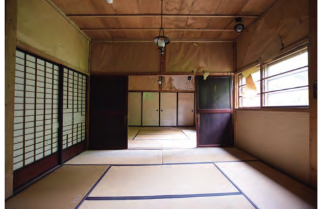
【修理前】客室2より客室1を見通す
