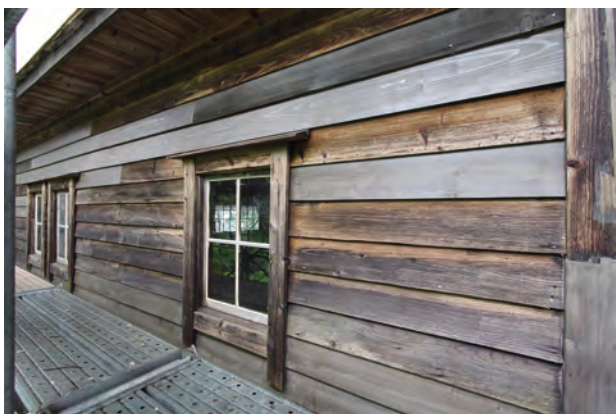
古色塗り完了「北棟」二階 西面
