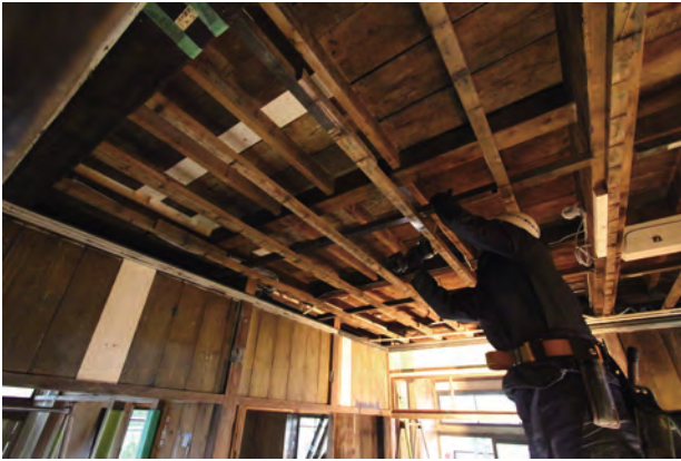
天井組立状況
