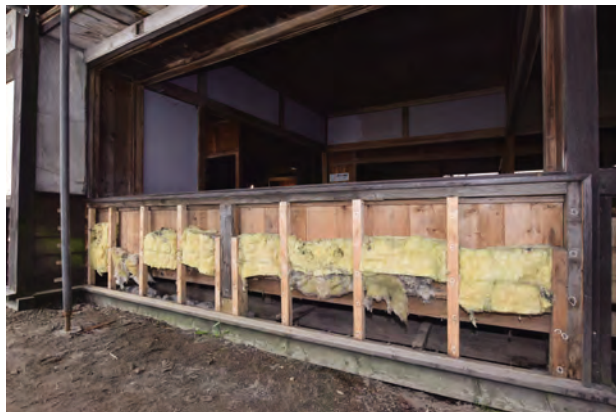
茶の間窓台 下見板解体完了
