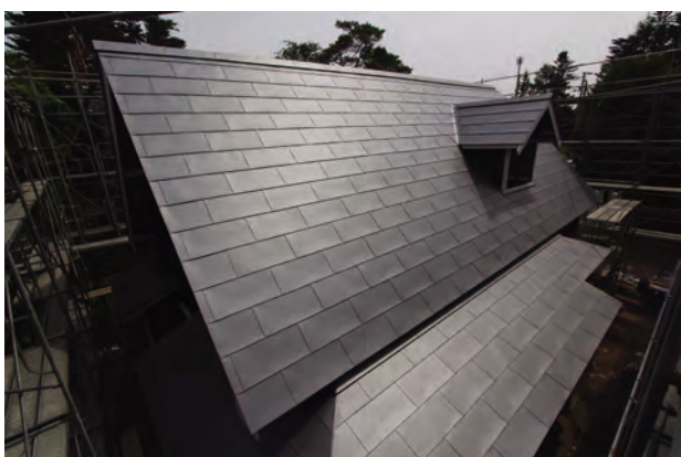
鋼板葺完了「南棟」南西よりみる
