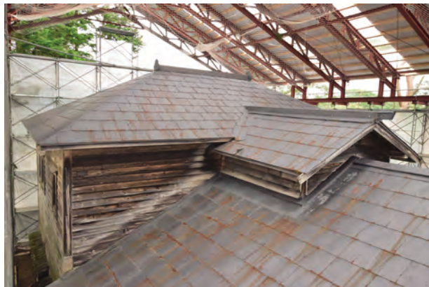
解体前状況 南西よりみる
