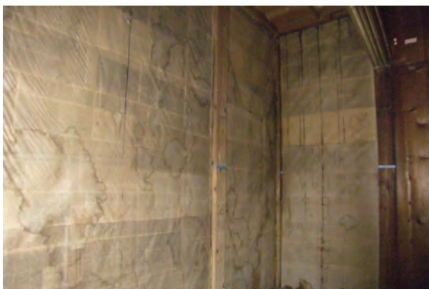
修理前袋貼仕上 二階廊下押入
