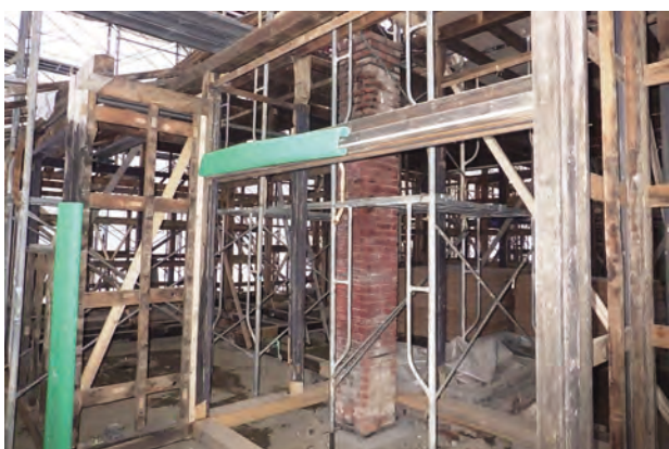
煙突施工完了
