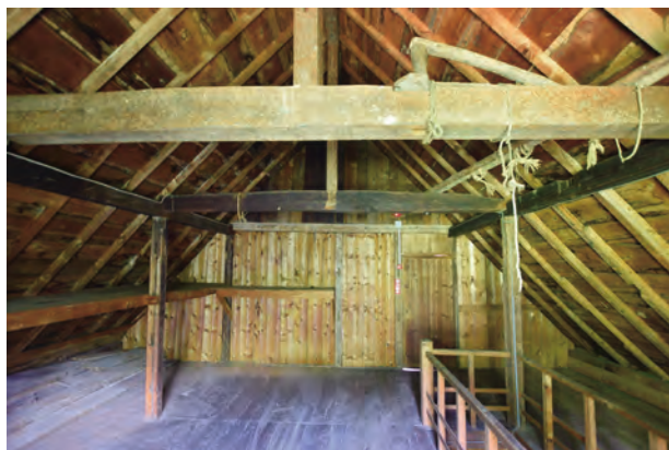
【修理前】小屋裏物置 西よりみる
