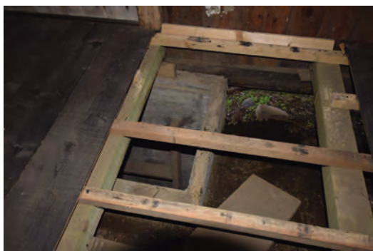
床下に遺存していたムロの開口部
