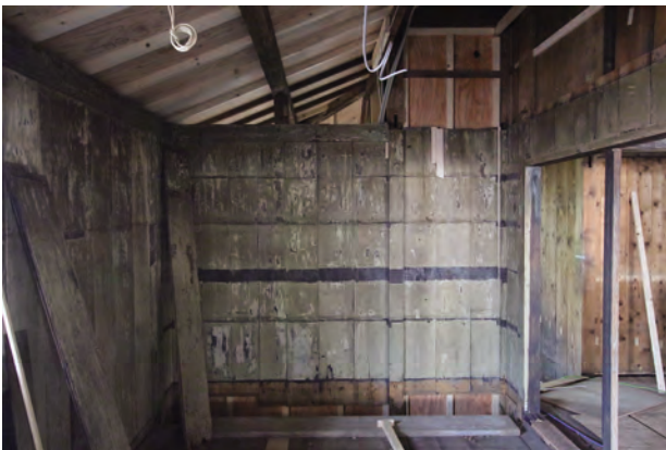
化粧板壁施工状況 台所 東よりみる
