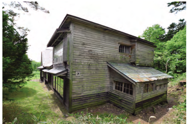
【修理前】外観 北東より
