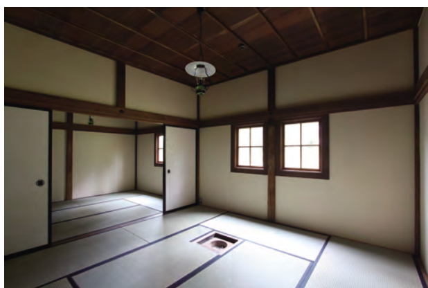
【竣工】 客室 4 北東より客室 3 を見通す
