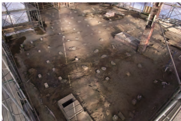
土台解体完了 礎石
