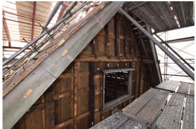
下見板解体完了 西面
