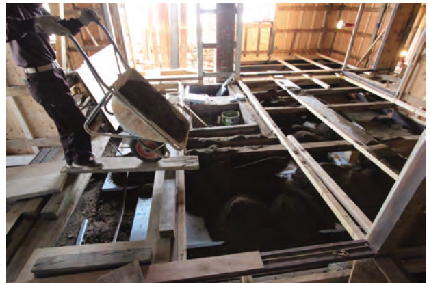
保護砂敷設状況
