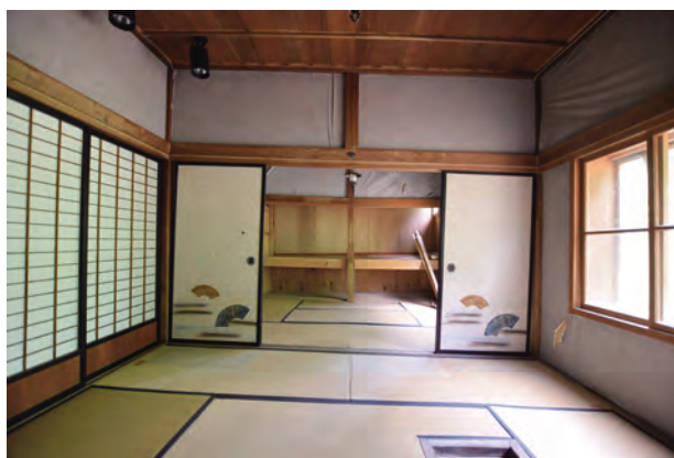
【修理前】 客室 4 より客室 3 を見通す
