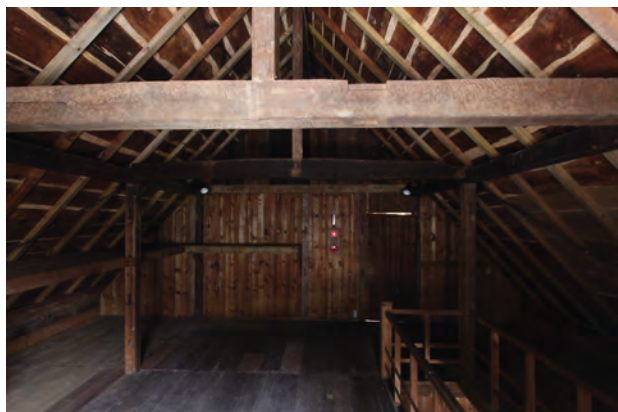
【竣工】小屋裏物置 西よりみる
