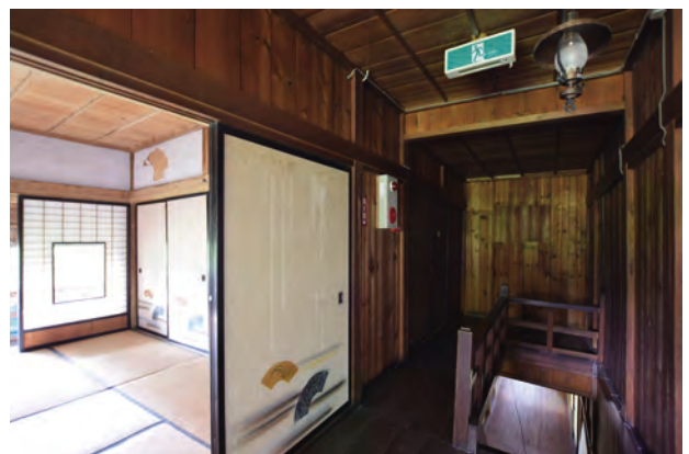
【修理前】「北棟」二階廊下 北西よりみる
