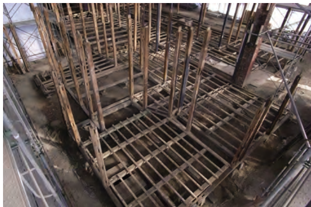
二階床組解体完了 一階軸部
