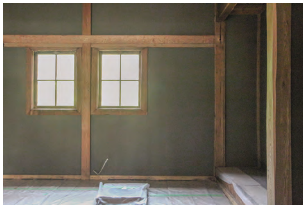
貼付壁施工完了「北棟」客室7
