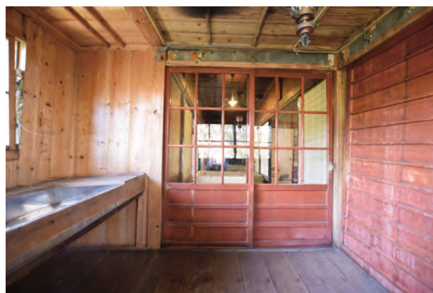
【修理前】「北棟」洗面所 北よりみる
