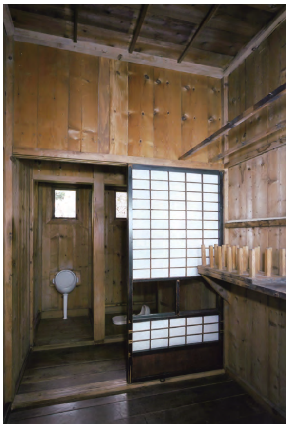
【竣工】ランプ室より便所を見通す
