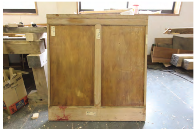
仮組状況 事務所腰板
