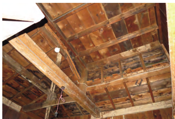
【修理前】 物置 小屋現わし天井
