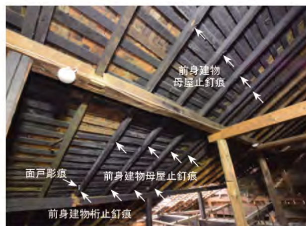
写 3-5-17 「中央棟」 前身建物垂木の痕跡
