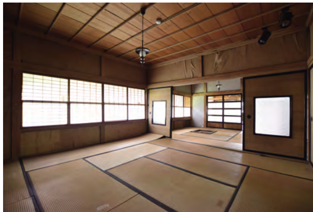
【修理前】仏間南西より茶の間を見通す
