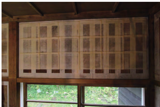
袋貼施工状況
