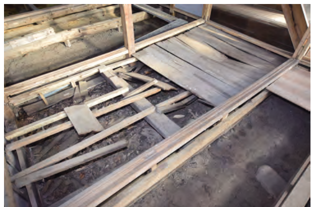
後設床板撤去状況 客室2より客室2 押入、客室3 押入をみる
