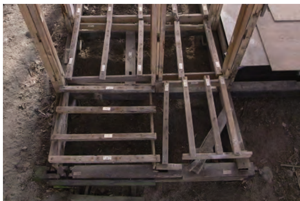
床板撤去状況 床組 便所 西よりみる
