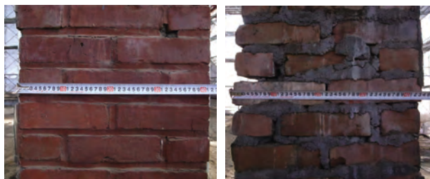
写 3-5-47 煙突化粧面（左）と壁付き面（右）
