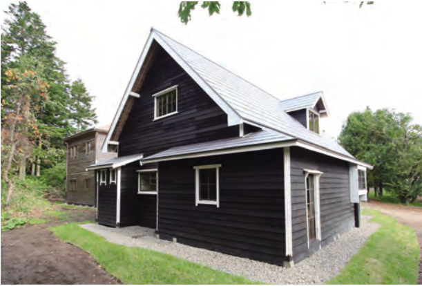
【竣工】外観 南西より
