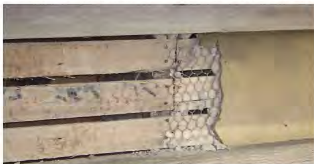
写 3-5-21 「中央棟」セメント壁解体時状況
