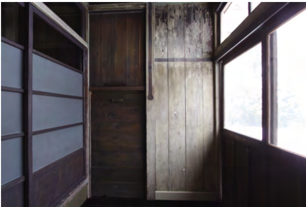
【竣工】裏玄関 西よりみる
