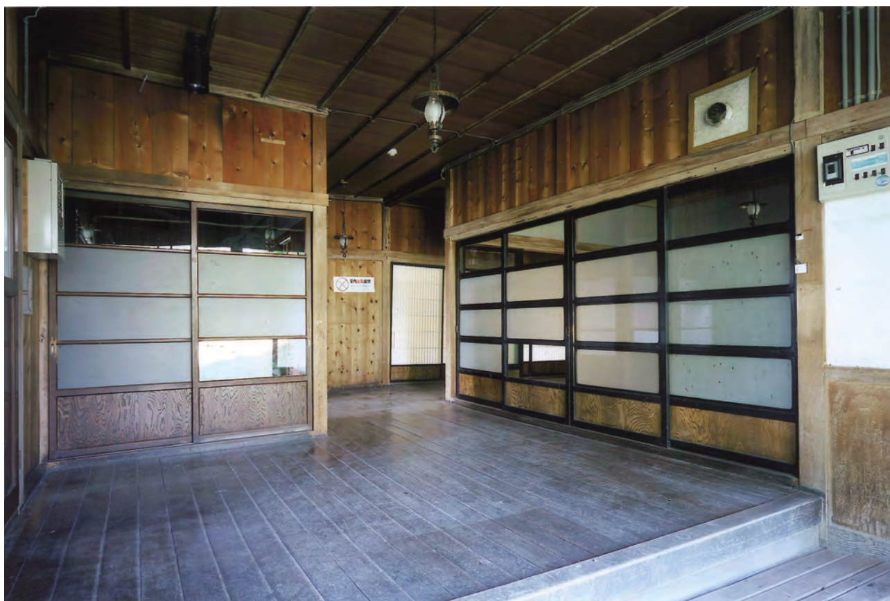
【修理前】玄関 南東よりみる
