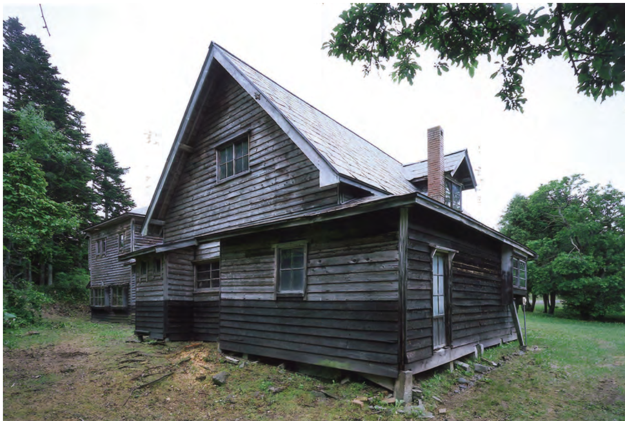
【修理前】外観 南西よりみる
