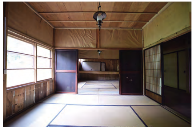
【修理前】客室1より客室2を見通す
