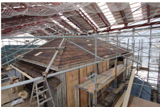
野地板施工完了「北棟」北東よりみる
