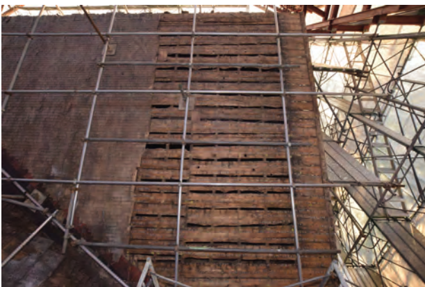
桁葎解体 西側北面野地板
