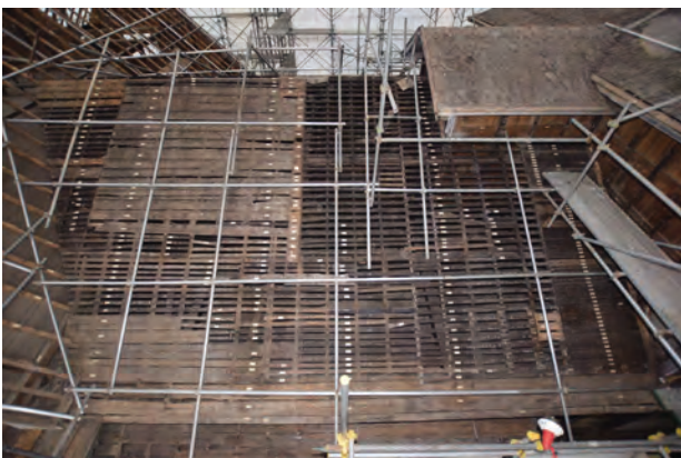
桁葺解体完了 野地板
