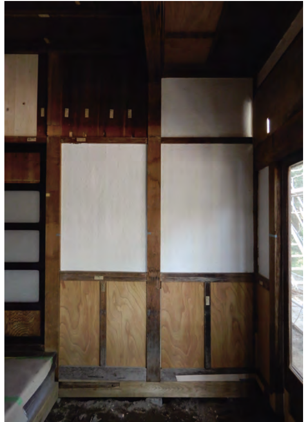
漆喰壁施工完了 玄関
