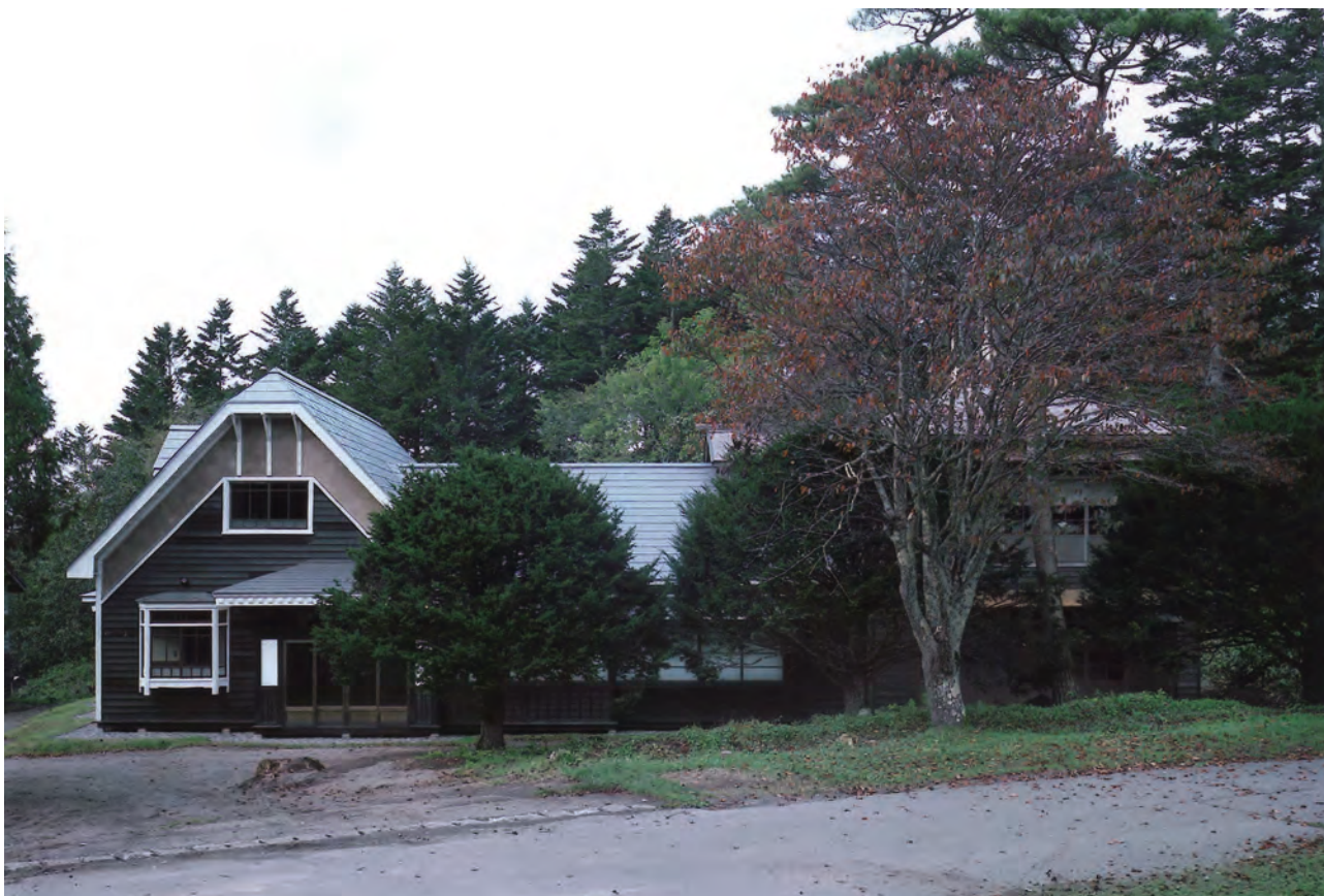
【竣工】外観正面（東面）
