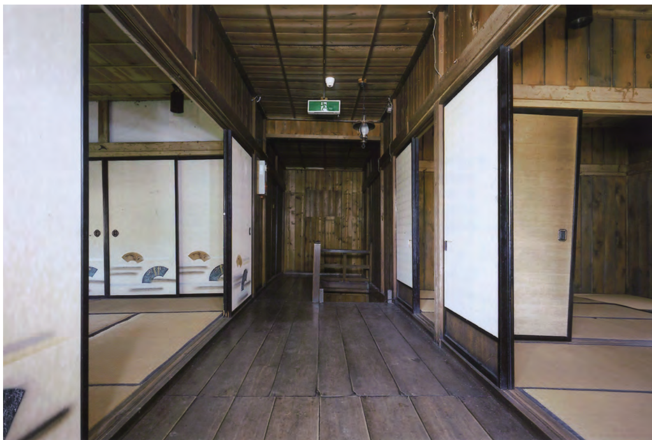
【修理前】二階廊下 北よりみる
