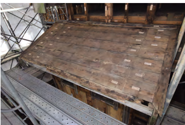
野地板 西側下屋 南西よりみる
