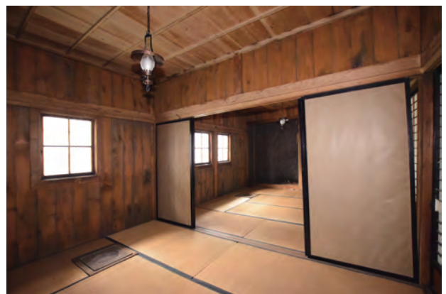
【修理前】客室 6 南東より客室 7 を見通す
