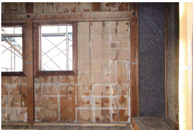
後設化粧板解体完了 客室7西面
