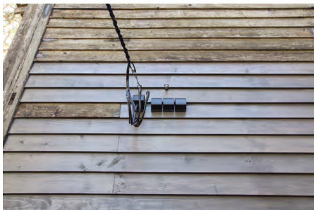
引込設備施工完了
