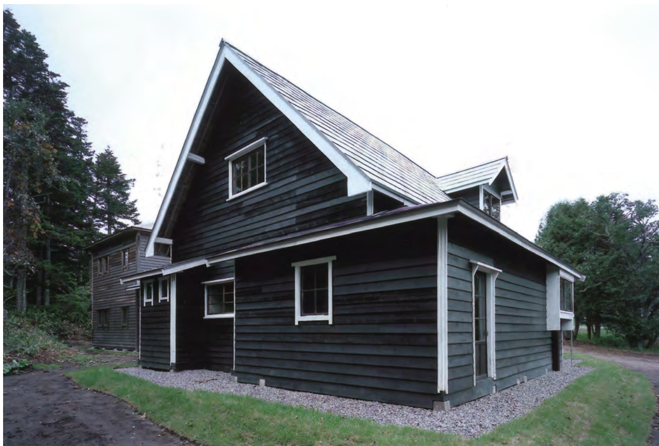
【竣工】外観 南西よりみる
