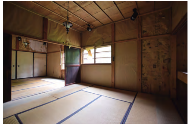
【修理前】客室2北東より客室1を見通す
