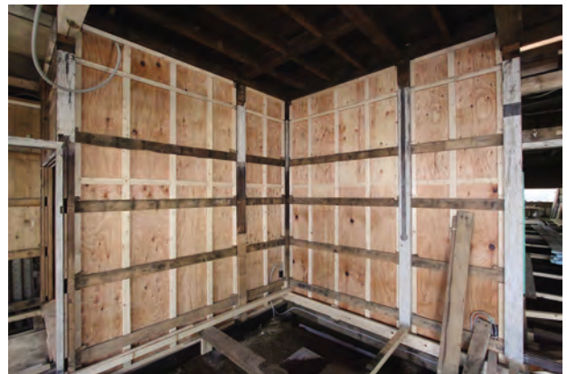
耐力壁施工状況 居間 南東よりみる
