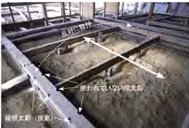
写3-5-5 客室5の足固め
