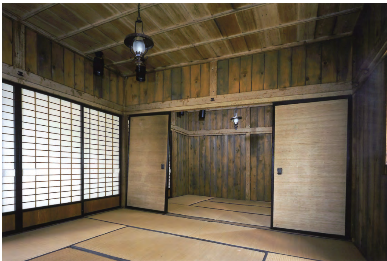
【修理前】 客室7 北西より客室6を見通す
