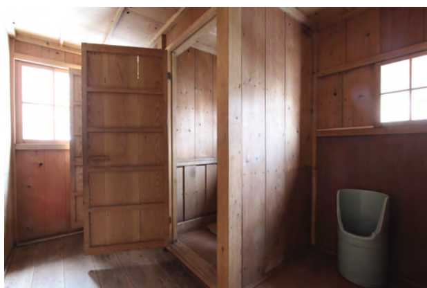
【竣工】「北棟」便所 南東よりみる
