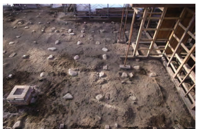
土台解体完了 礎石
