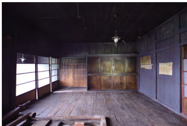
【修理前】居間 東よりみる
