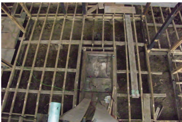
床板解体完了 床組 居間 南よりみる
