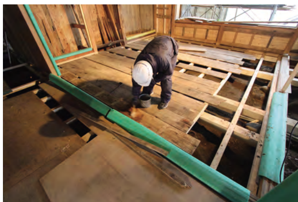
荒床施工状況 仏間
