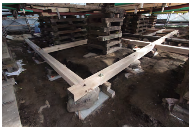
土台組立完了「北棟」南西よりみる
