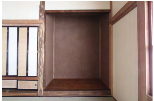
鋸屑壁施工完了 仏間トコ
