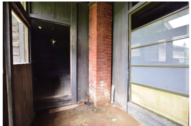
【修理前】裏玄関 南東よりみる
