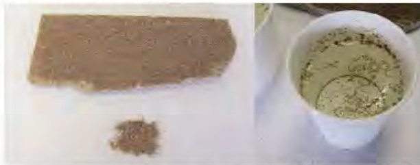
写 3-5-23 鋸屑壁調査状況 （左：解体壁部分、右：構成材料の確認）
