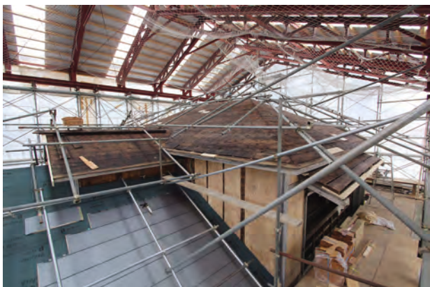
野地板施工完了「北棟」南東よりみる
