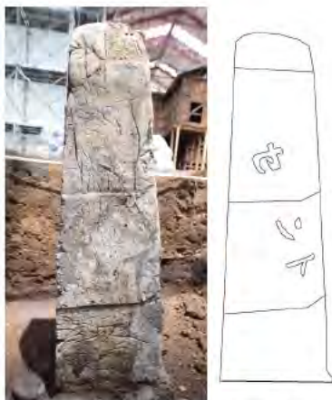
写 3-5-3 コンクリート独立基礎地業 (L=70 cm) 型枠の剥離に用いたセメント袋の文字が転写されている。
