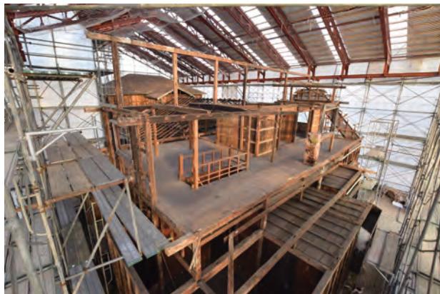
垂木解体状況 小屋組
