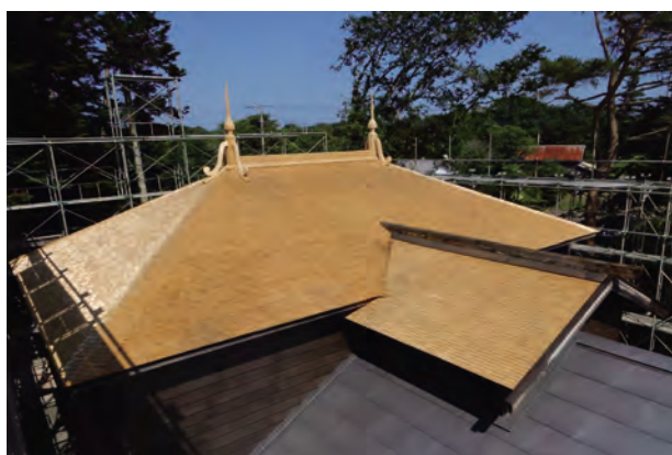
葺葺施工完了「北棟」南西よりみる
