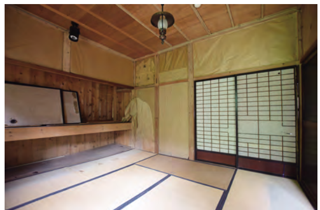
【修理前】客室2南西よりみる
