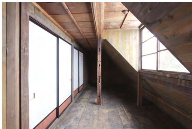
【竣工】小屋裏廊下 西よりみる
