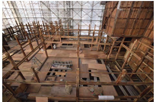
小屋組解体完了 軸部
