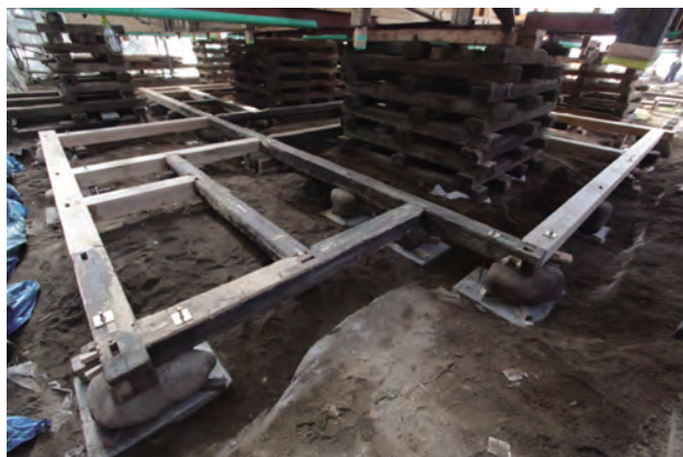
土台組立完了「北棟」北西よりみる
