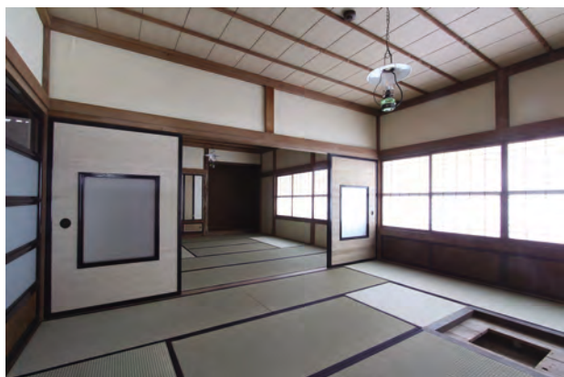
【竣工】茶の間北西より仏間を見通す
