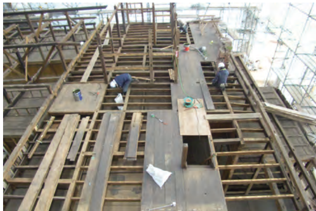
床板解体状況 二階 西よりみる
