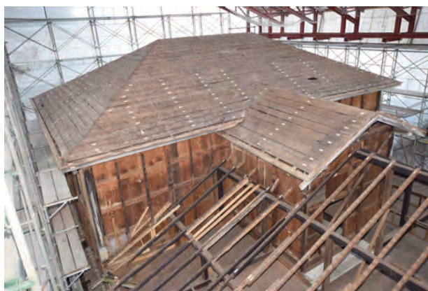
桁葺解体完了 野地板
