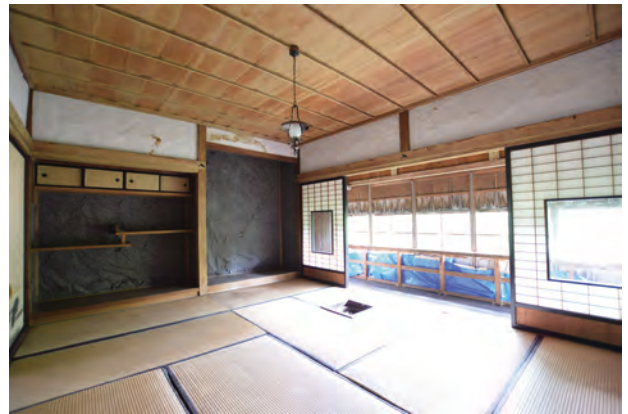
【修理前】客室 8 南西よりみる
