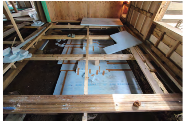
断熱材敷設状況「中央棟」客室1北よりみる
