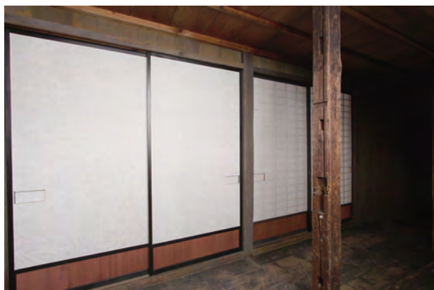
【竣工】小屋裏廊下 南西よりみる
