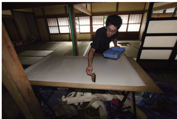
上貼作業状況
