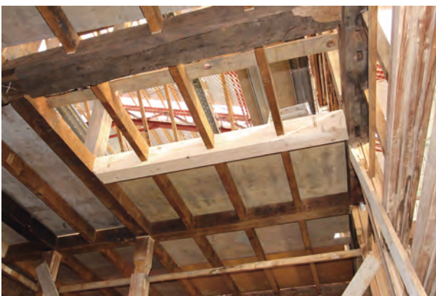
構造補強梁設置状況
