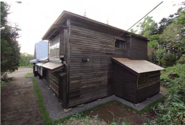
【竣工】外観 北東より
