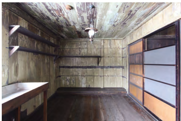
【竣工】台所 東よりみる
