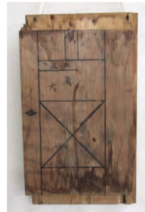
矩計板図（一部） 茶の間窓棚板に転用
