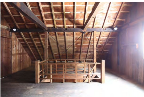
【竣工】小屋裏物置 北よりみる
