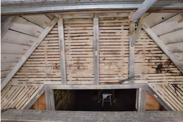
正面妻壁木摺下地
