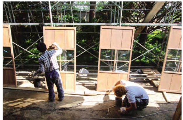
建具古色塗り状況
