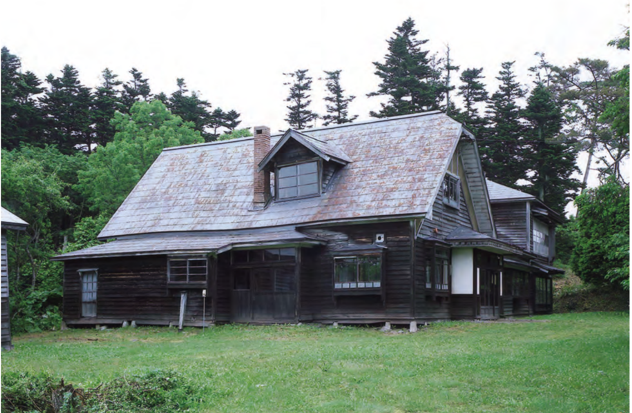
【修理前】外観 南東よりみる
