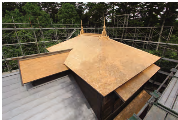
葺葺施工完了「北棟」南東よりみる
