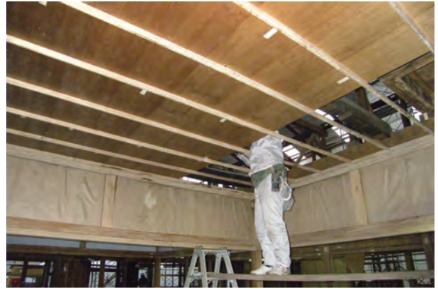
天井解体状況「中央棟」仏間 北東よりみる
