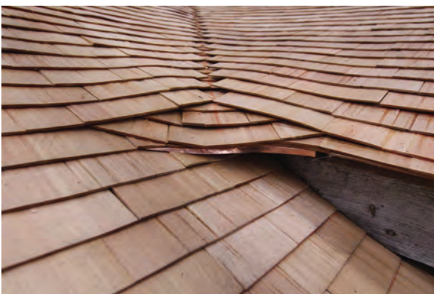
谷部施工完了
