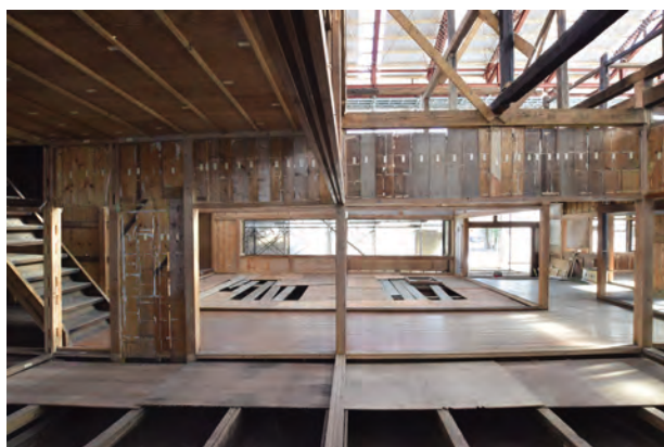
紙貼解体完了 客室1、客室2西よりみる
