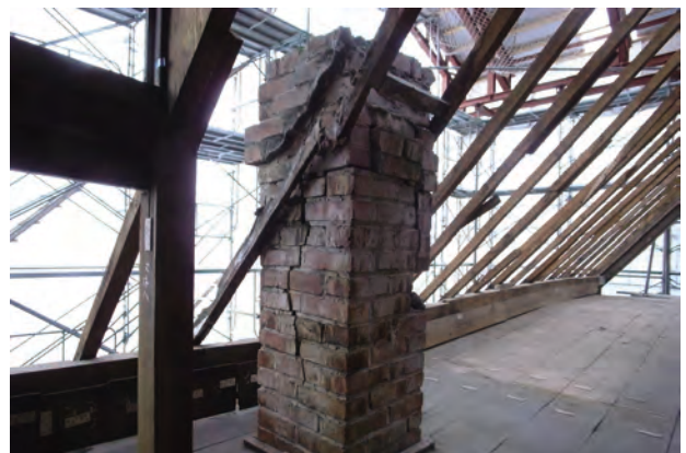
二階小屋裏廊下の煙突と垂木の取付部
