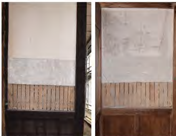
写 3-5-22 玄関袖壁漆喰壁層出し状況（左：外部 右：内部）
