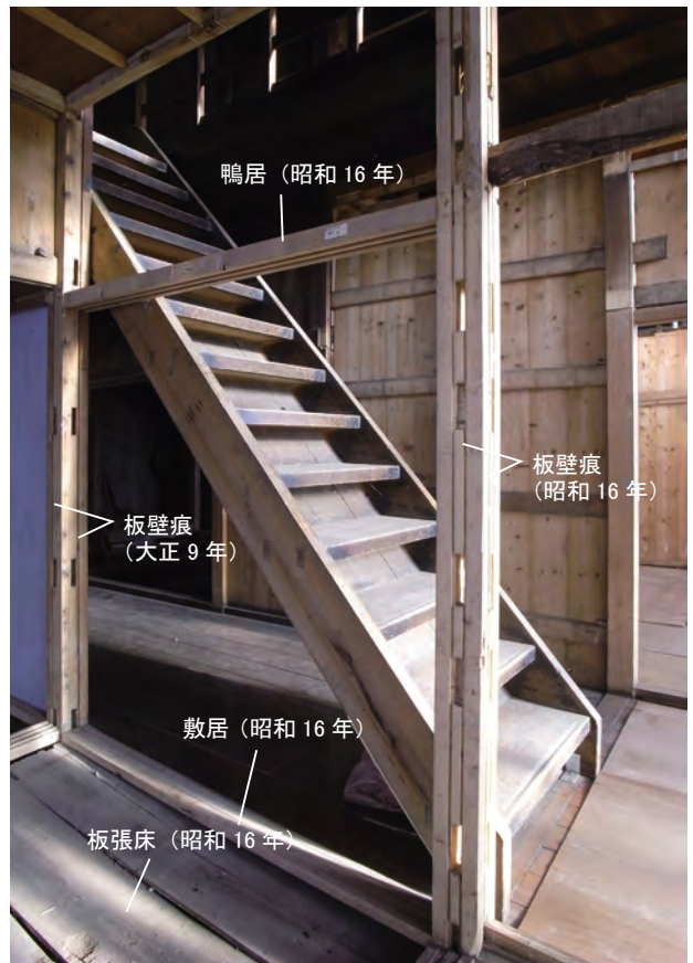
客室2・3境押入東面の壁板撤去状況 壁板を撤去したところ旧開口部の敷鴨居が現れた。床板は天端を仕上げた板張であったことがわかる。「北棟」側の柱には「北棟」創建時の板壁であった痕跡(貫、板溝、下見板釘痕)がある。
