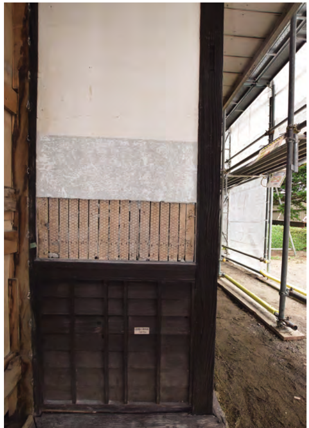
壁面層出し 玄関外脇壁 南面
