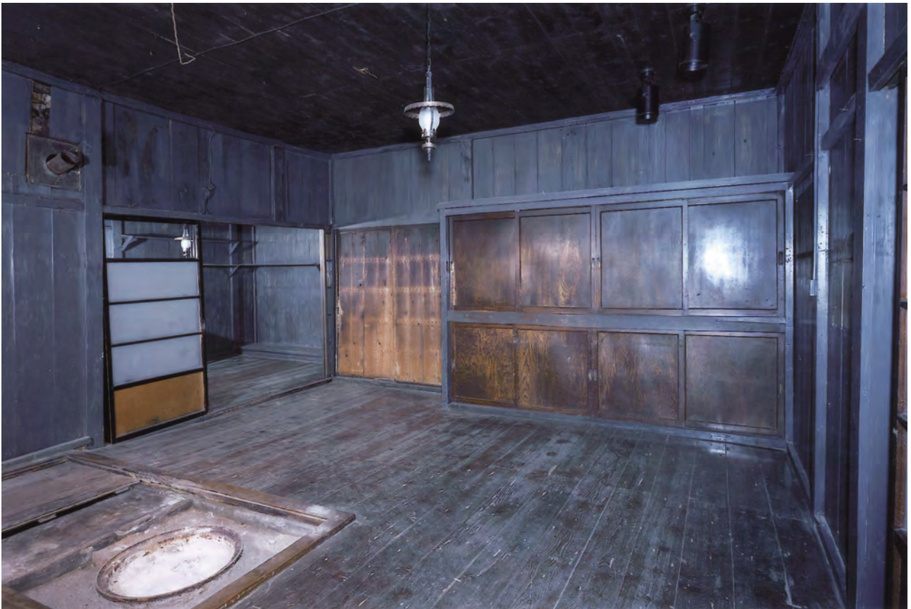
【修理前】居間北東より台所を見通す
