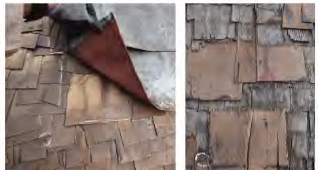
写3-5-11 左：片面が赤く塗られる 右：葺板に付着した赤い塗料
