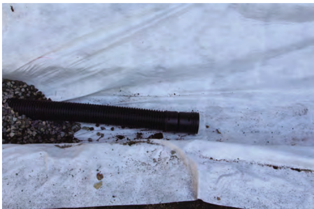
雨落溝有孔管、砂利敷設状況
