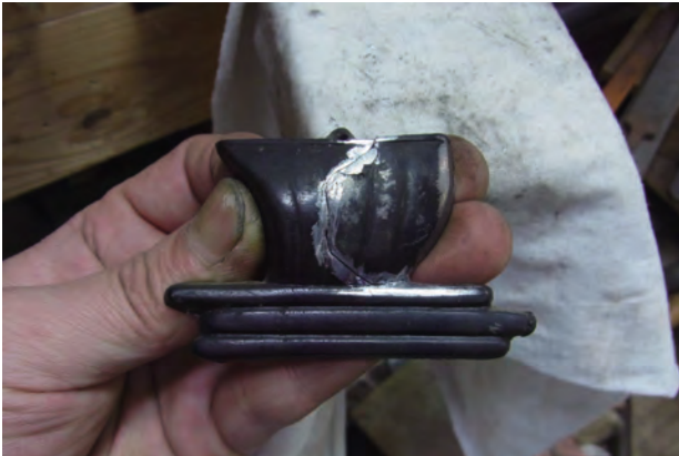
半田接合補修
