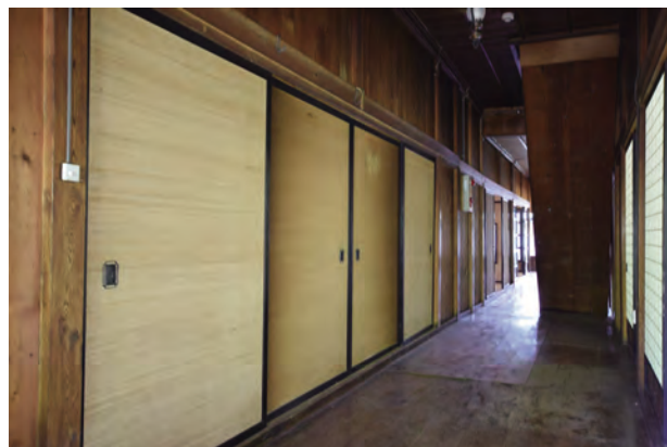
【修理前】「北棟」廊下 北西よりみる
