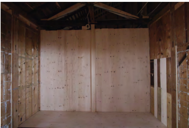
化粧板壁施工完了「中央棟」客室2 押入 南よりみる
