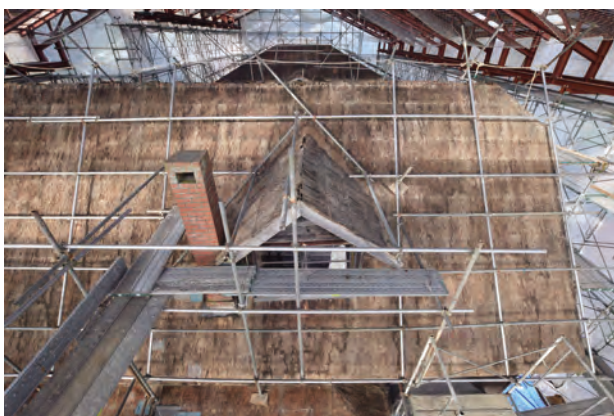
「南棟」屋根面足場 南よりみる
