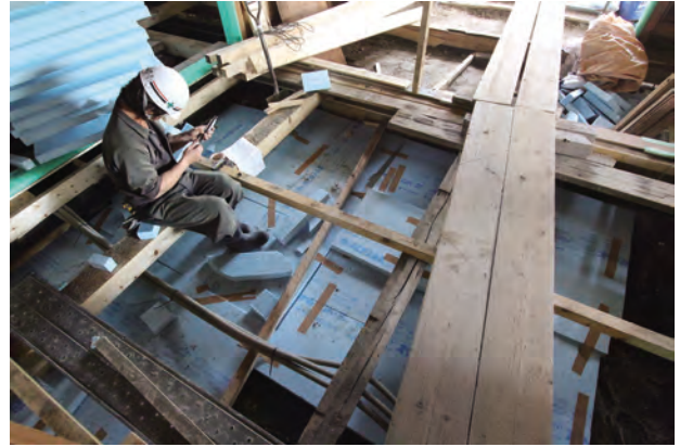
断熱材敷設状況
