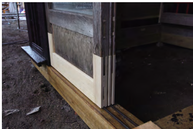
建具繕い完了 玄関引戸
