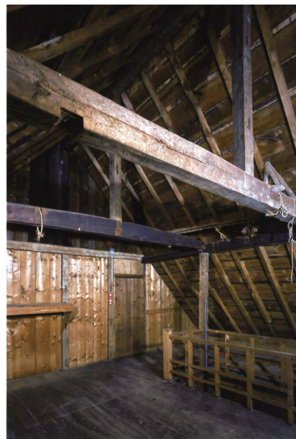
【修理前】小屋裏物置 北西よりみる
