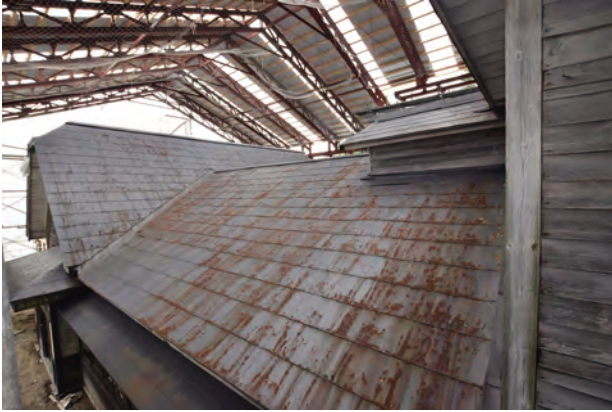
解体前状況 北東よりみる
