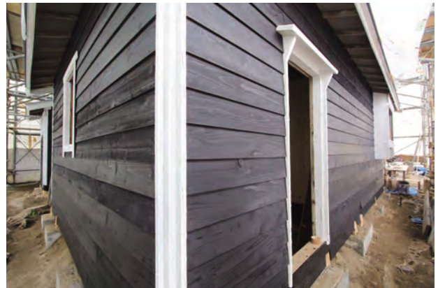
外壁塗装完了「南棟」南西よりみる
