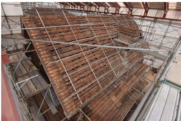
桁葺解体完了 野地板
