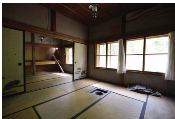
【修理前】 客室 4 北東より客室 3 を見通す
