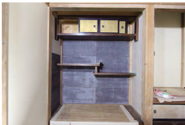
貼付壁施工完了「南棟」仏間床脇
