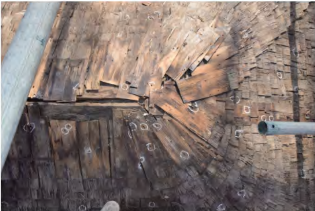
遺存していた棟飾り葺手台座・の痕跡
