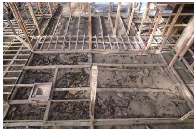
軸組解体完了 土台
