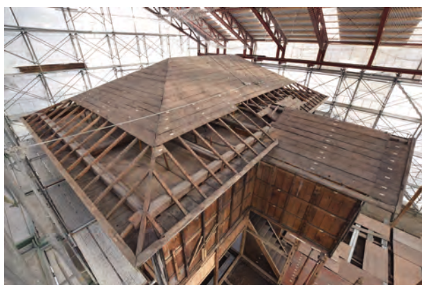
野地板解体完了 (軒先部)
