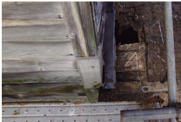
西面「北棟」壁との取合い
