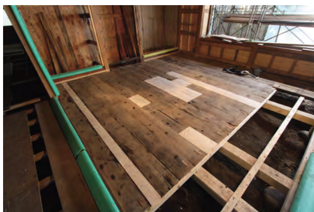
荒床施工状況「南棟」仏間 南西よりみる
