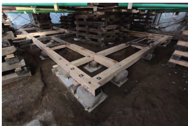
土台組立完了「北棟」南東よりみる
