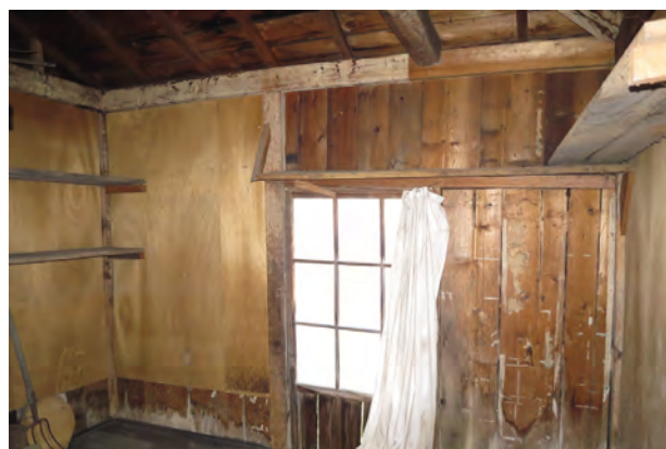
【修理前】 物置 北西よりみる
