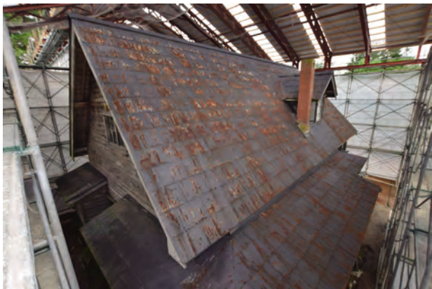
解体前状況 北東よりみる
