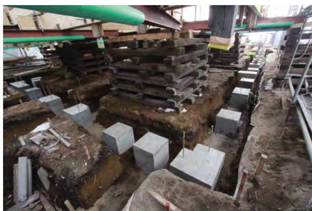
基礎コンクリート打設「北棟」北西よりみる
