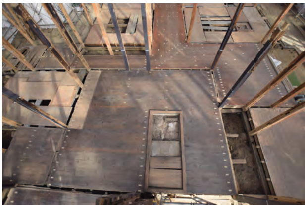
床板 居間 南よりみる
