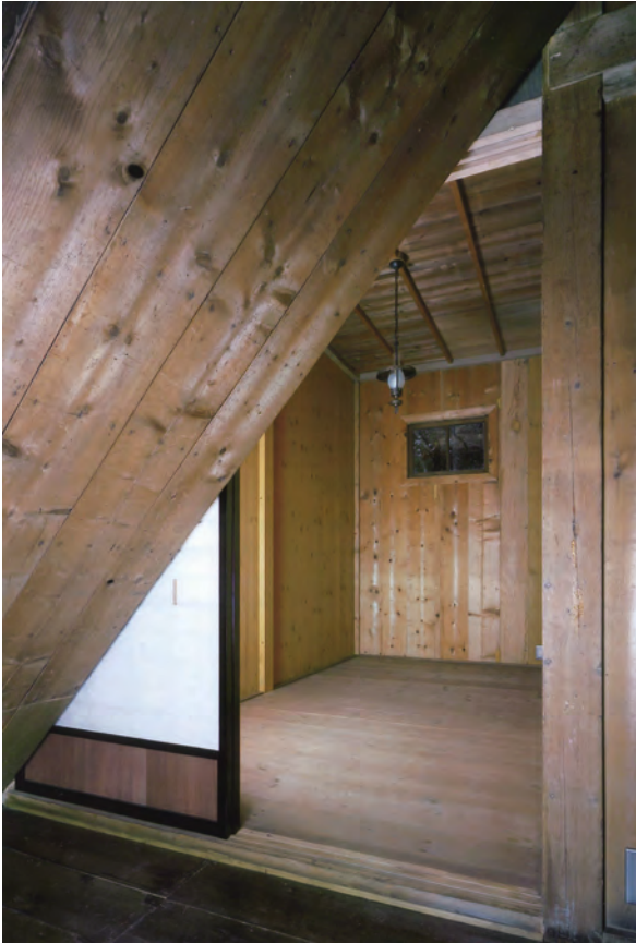
【竣工】客室（布団部屋）廊下よりみる
