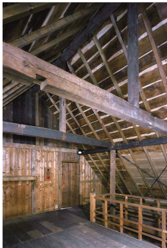
【竣工】小屋裏物置 北西よりみる
