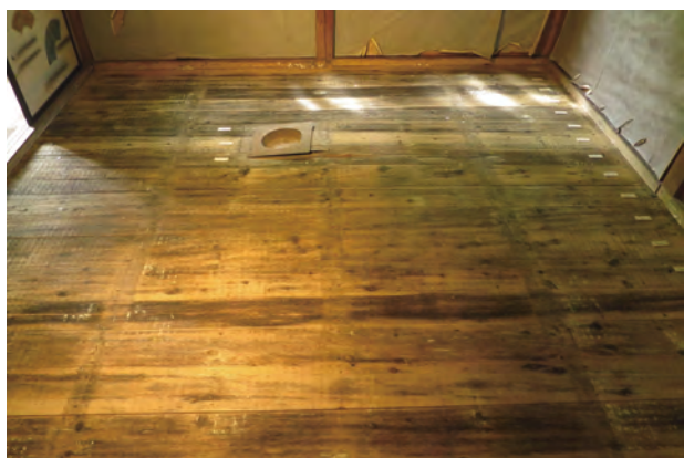
荒床 客室4 東よりみる
