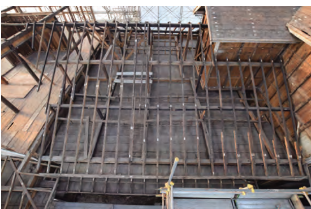
野地板解体完了 垂木
