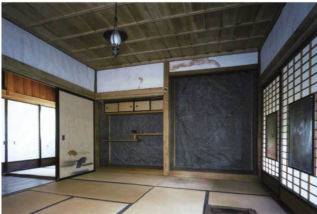
【修理前】客室8 南東よりみる
