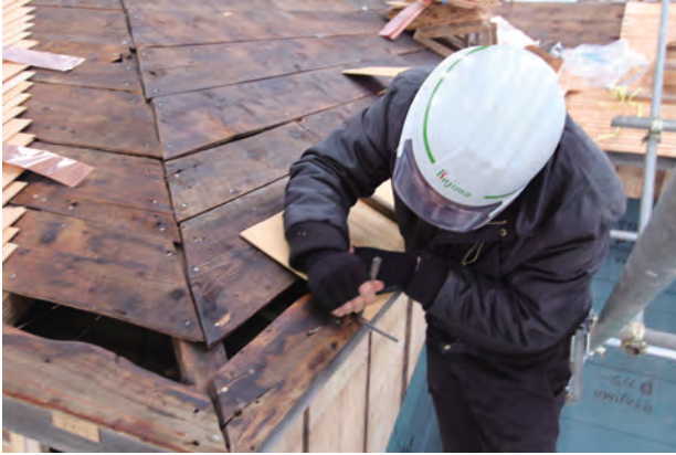
軒付施工状況
