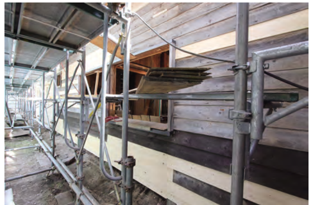
下見板張り施工完了「中央棟」南西よりみる
