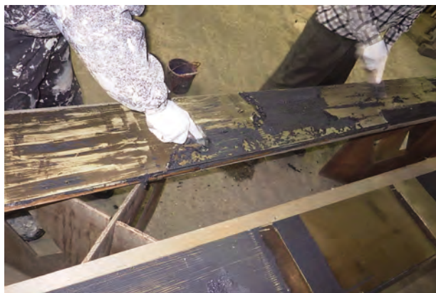
既存塗膜剥離作業
