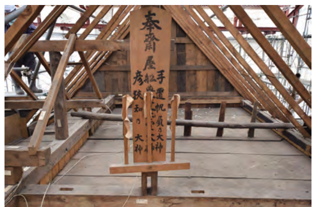
棟札取付状況 東よりみる
