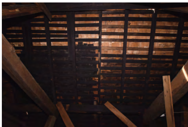
小屋裏 野地東面をみる
