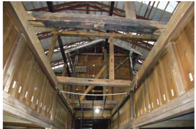
天井解体完了「中央棟」廊下 南よりみる
