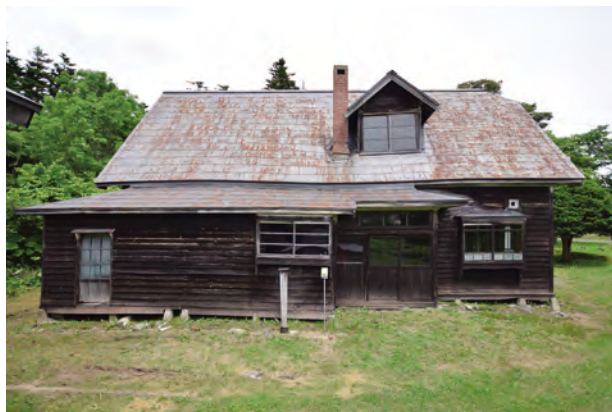
【修理前】「南棟」南面
