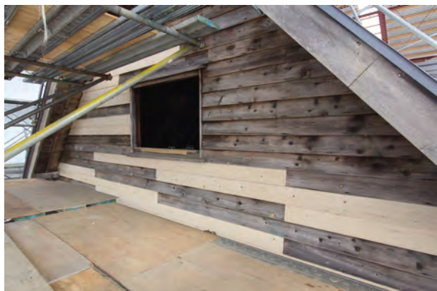
下見板張り施工完了「南棟」二階 北東よりみる
