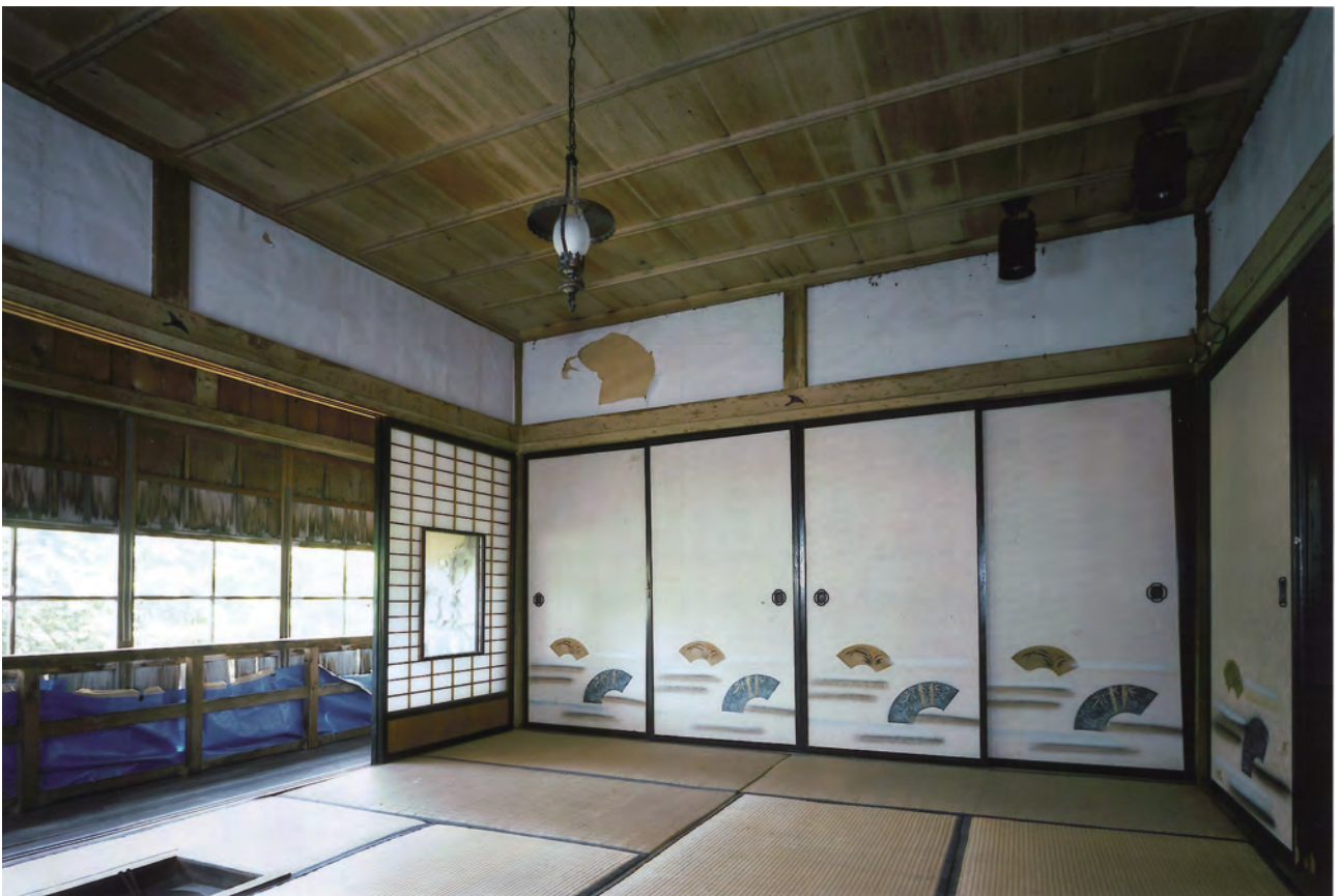
【修理前】 客室 8 北西よりみる
