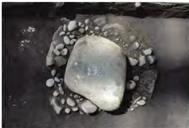
写 3-5-2 自然石基礎地業
