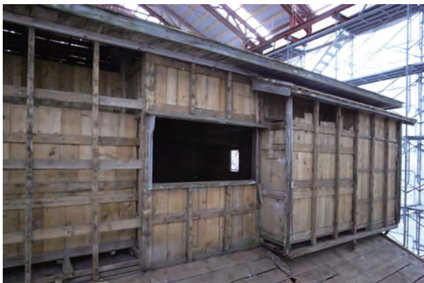
下見板解体完了 二階北面
