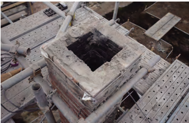
写 3-5-49 コンクリート充填範囲撤去状況 煉瓦半枚積みで内部に円筒を入れず中空の状態である。
