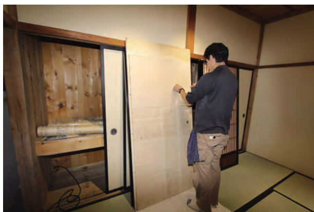
袋貼作業状況
