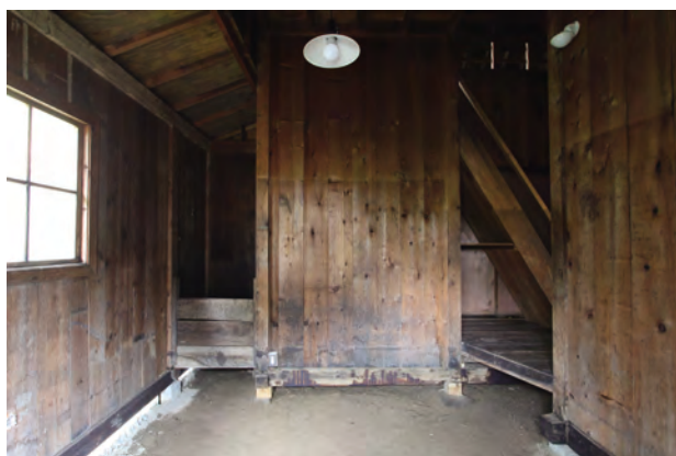
【竣工】 物置 南よりみる
