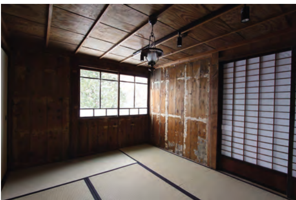
【竣工】和室2 北西よりみる
