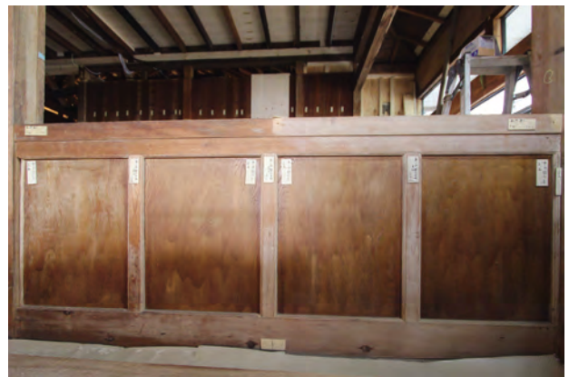
腰板施工完了 事務所 北面
