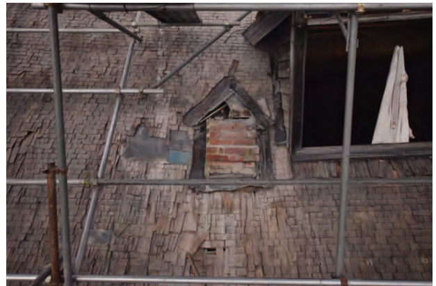
煙突の屋根突出部取付状況
