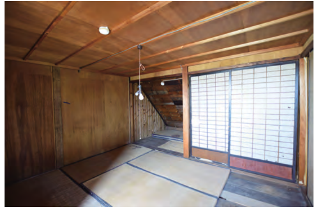
【修理前】和室1 南東よりみる
