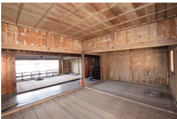
後設化粧板解体完了 客室7北西より客室6、客室8を見通す
