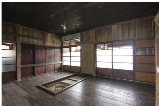
【竣工】居間 北西よりみる
