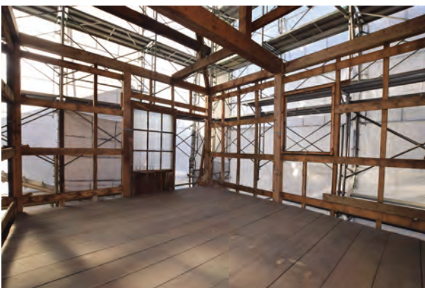
縦板張解体完了 物置 北東よりみる
