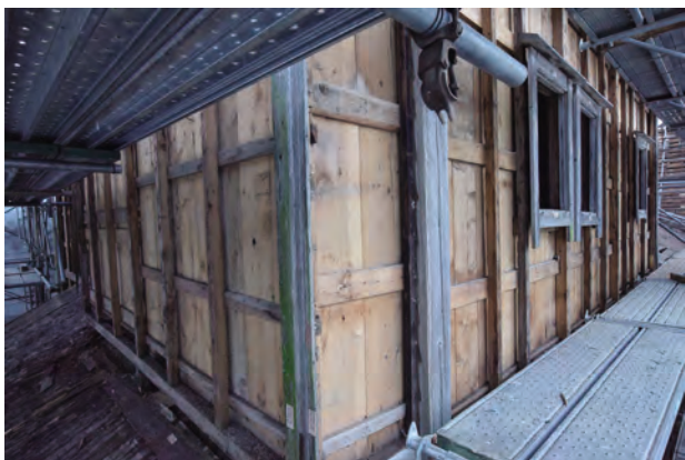
下見板解体完了 二階 北西よりみる
