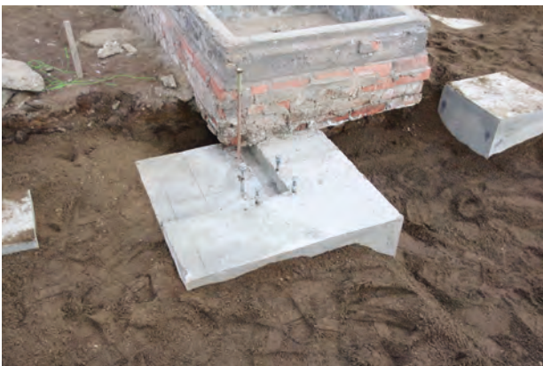
煙突部基礎コンクリート
