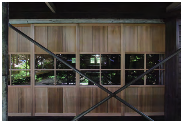
建具施工完了「北棟」客室5 東よりみる
