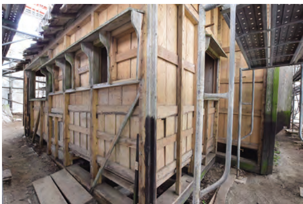
下見板解体完了 便所 北西より見る
