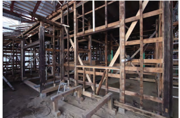
壁下地組立完了「南棟」南東よりみる
