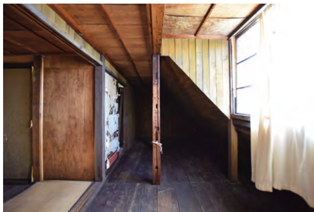
【修理前】小屋裏廊下 西よりみる
