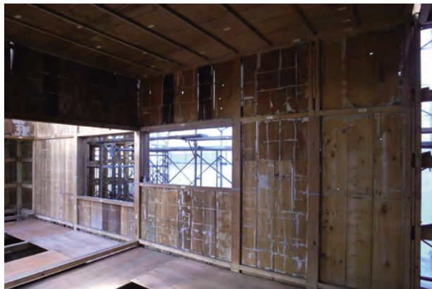
紙貼解体完了 客室2北東よりみる
