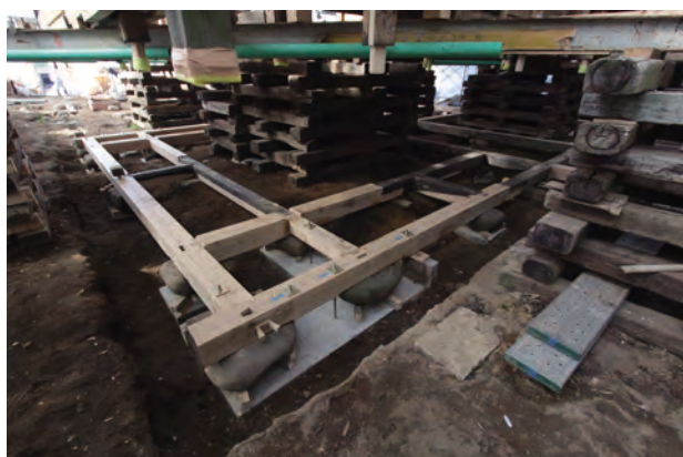
土台組立完了「北棟」北東よりみる
