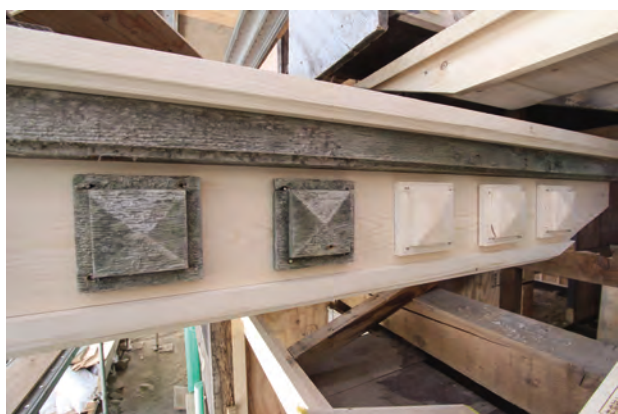
装飾補修状況 玄関鼻隠し
