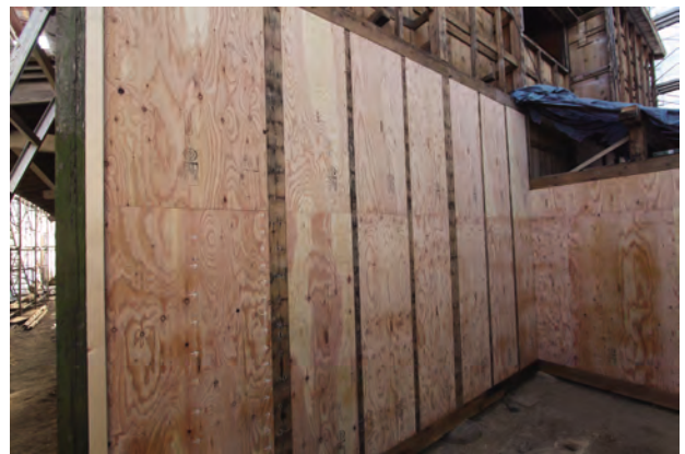
耐力壁施工状況「北棟」北面
