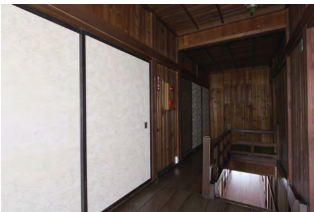
【竣工】「北棟」二階廊下 北西よりみる
