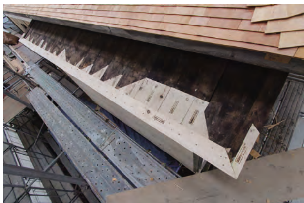
野地板繕い状況「北棟」二階東側 北東よりみる
