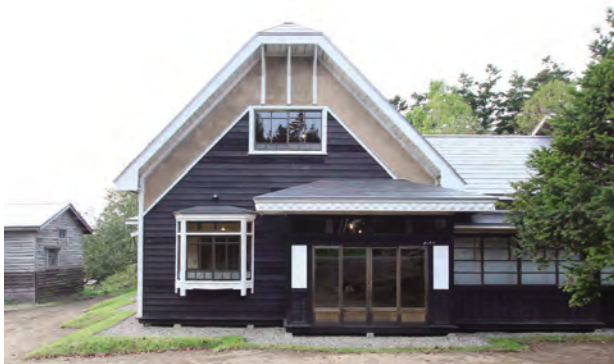
【竣工】「南棟」正面
