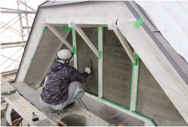
下塗り施工状況
