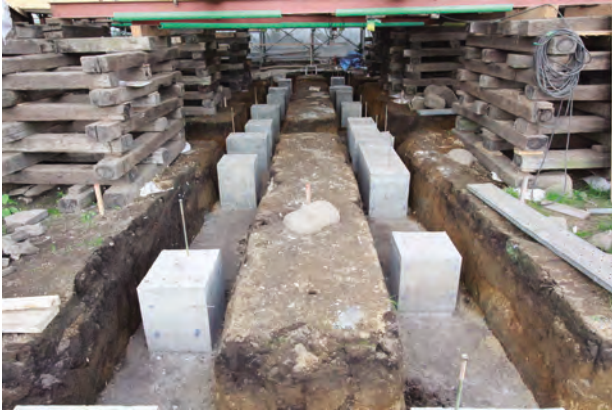
基礎立上りとアンカーボルト
