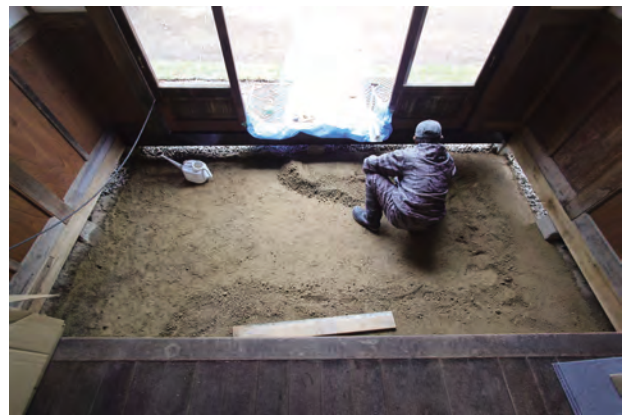
三和土施工状況 玄関土間
