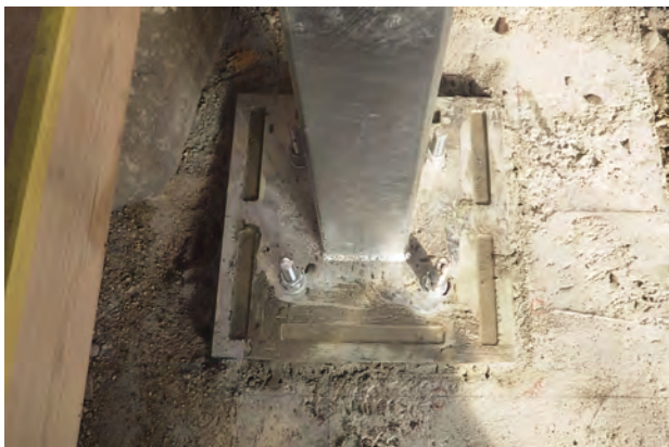
煙突補強鋼管金物と基礎の緊結状況
