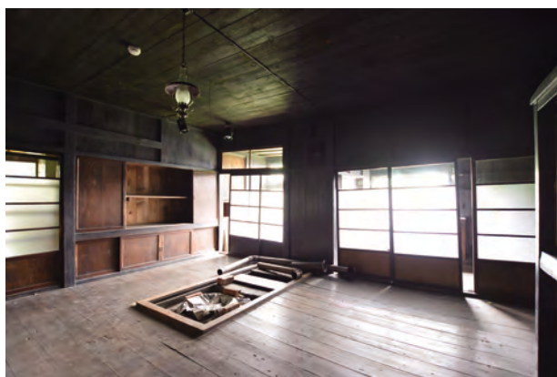
【修理前】居間 北西よりみる
