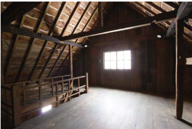
【竣工】小屋裏物置 北東よりみる
