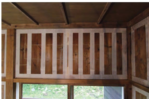
際ベタ貼完了
