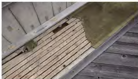
写 3-5-20 同上解体時状況
