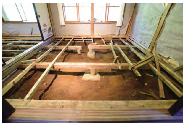
荒床解体完了 床組 客室4 東よりみる
