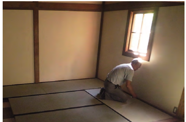
畳敷込み状況
