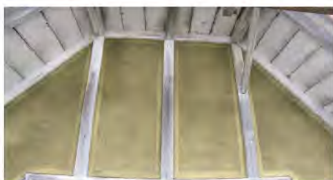
写 3-5-19 「南棟」掃付けモルタル壁
