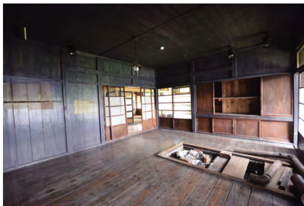
【修理前】居間 南西よりみる
