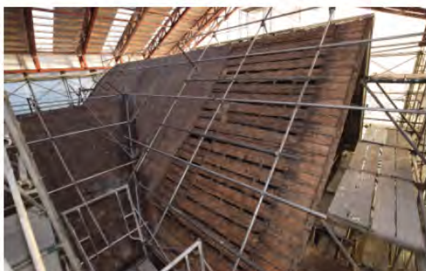
写 3-5-15 「南棟」 野地板 平には丸太挽の板を並べ、鱈羽には整形した板を突付で並べる。
