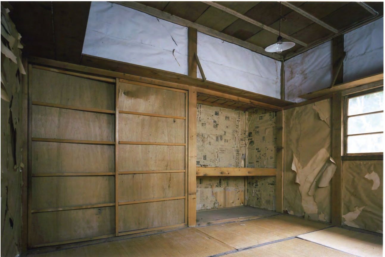
【修理前】 使用人室 北東よりみる
