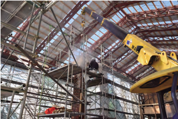
煙突解体状況
