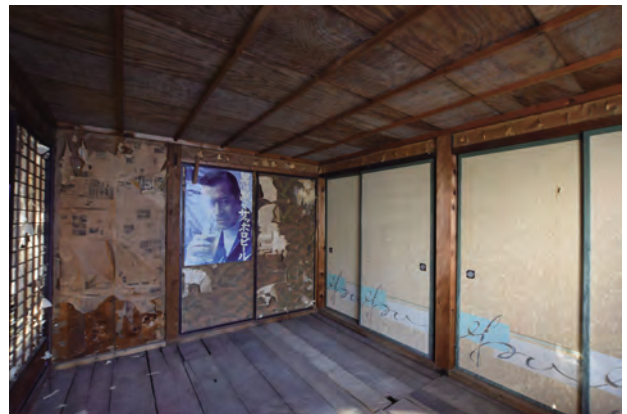
【修理前】和室2 南東よりみる
