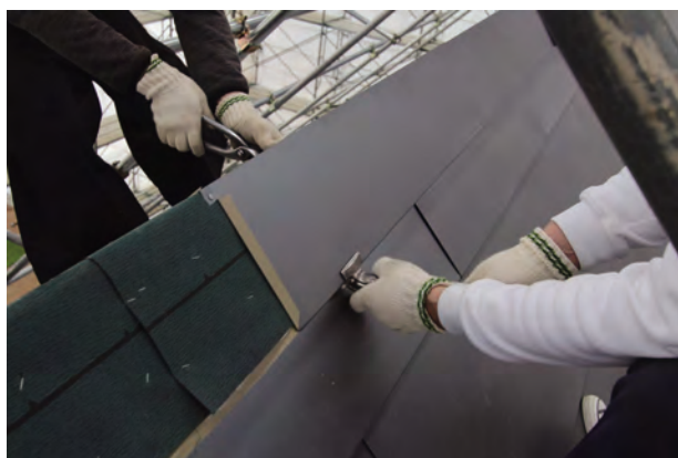
棟包み施工状況
