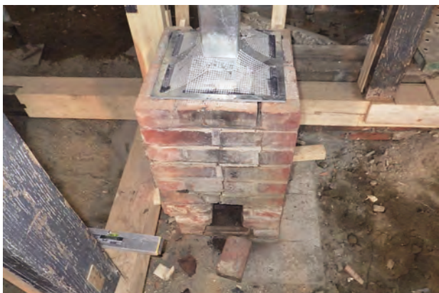
煙突補強鋼管とプレート施工状況
