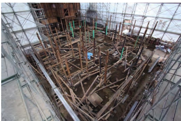
一階柱組立完了 南西よりみる
