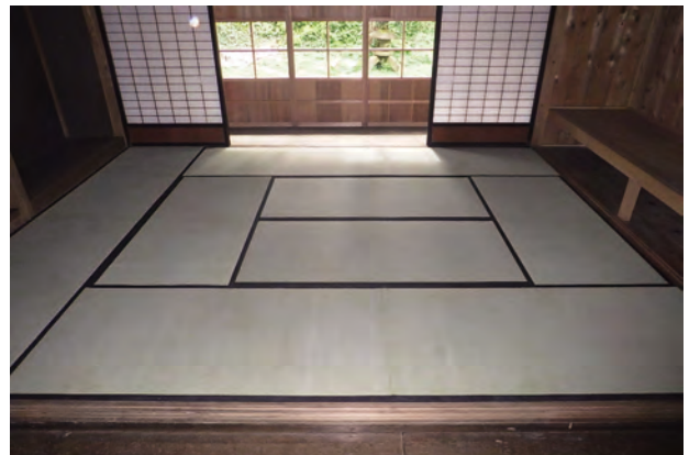
畳施工完了「北棟」客室5 西よりみる
