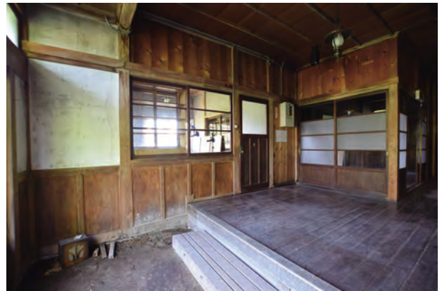
【修理前】玄関 北東よりみる
