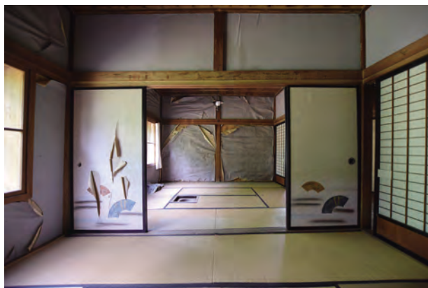
【修理前】 客室 3 より客室 4 を見通す
