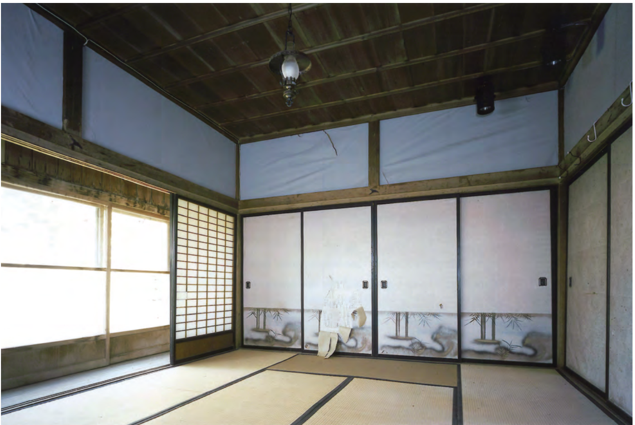
【修理前】 客室 5 北西よりみる
