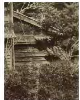
中古の改造を受けた洗面所 (昭和初期) 妻壁に庇を設け張り出している様子が見える。壁面に窓はなく板張りである。
