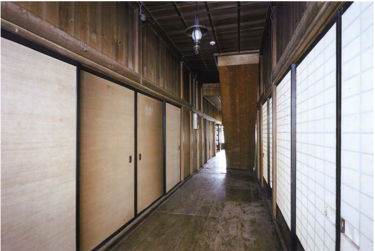
【修理前】一階廊下 北よりみる
