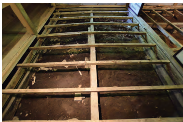
荒床解体完了 床組 客室3 東よりみる
