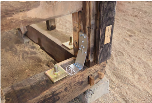
補強金物設置状況
