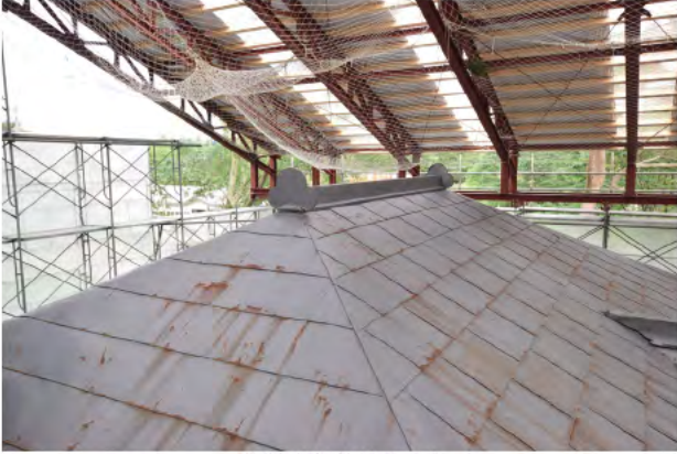
解体前棟飾り 西側
