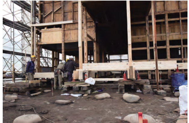
腰固め施工状況
