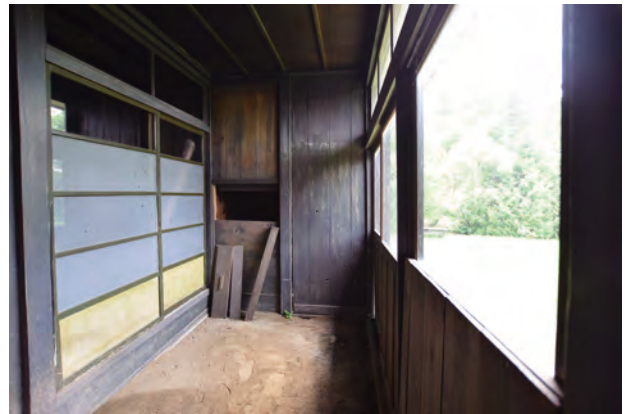
【修理前】裏玄関 西よりみる
