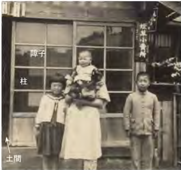
図3-3-7 昭和初期の玄関付近 玄関奥は中央に柱が建ち右側1間に引分障子が入る。その左手は土間が延びている。
