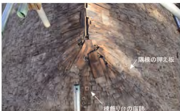
写 3-5-13 「北棟」 鉄板下に遺存していた桁葺
