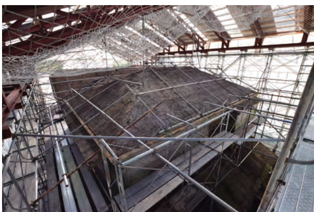
素屋根内部 北東よりみる
