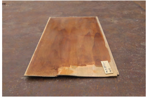
補修前 事務所腰板
