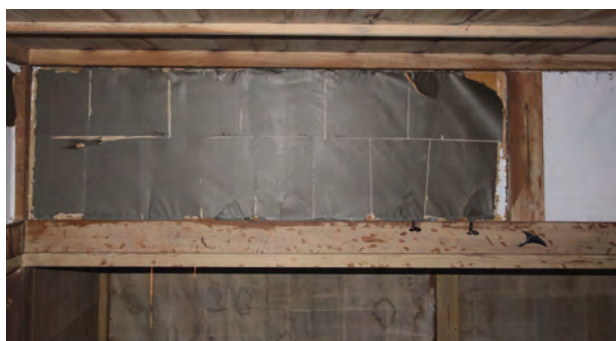
写 3-5-36 遺存していた当初壁紙 (客室8)
