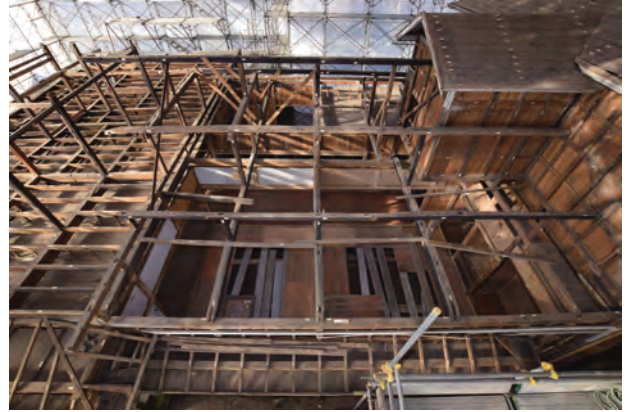
垂木解体完了 小屋組
