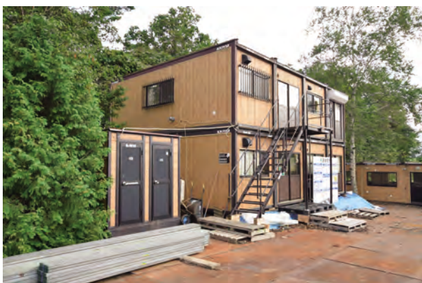
現場事務所兼作業員休憩所 北西よりみる
