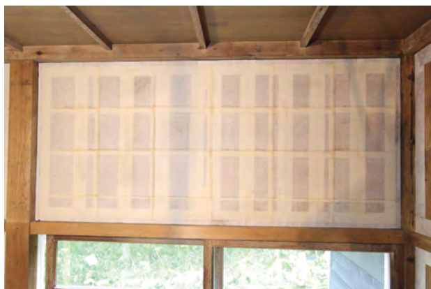
袋貼施工完了
