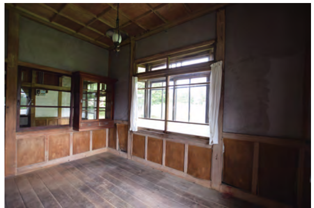
【修理前】事務所 南西よりみる
