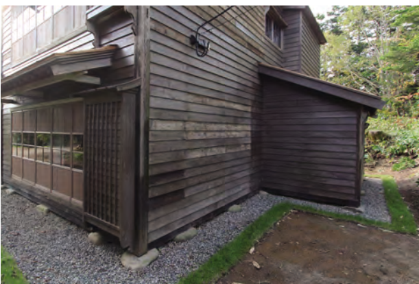
【竣工】「北棟」客室5及び便所外観 北東より
