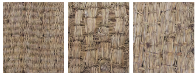
写3-5-43 南棟和室1・2 畳裏菰仕様 3種類の裏菰が使用されており、時期差があるものを寄せ集めている。
