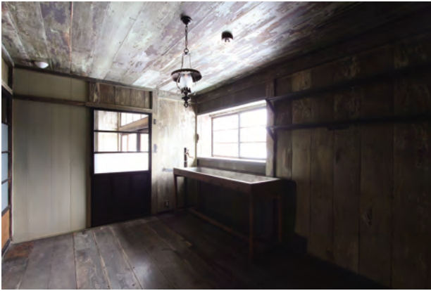
【竣工】台所 北西よりみる
