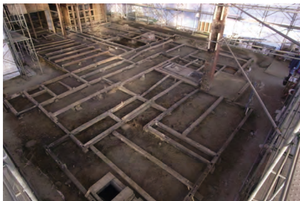
軸組解体完了 土台
