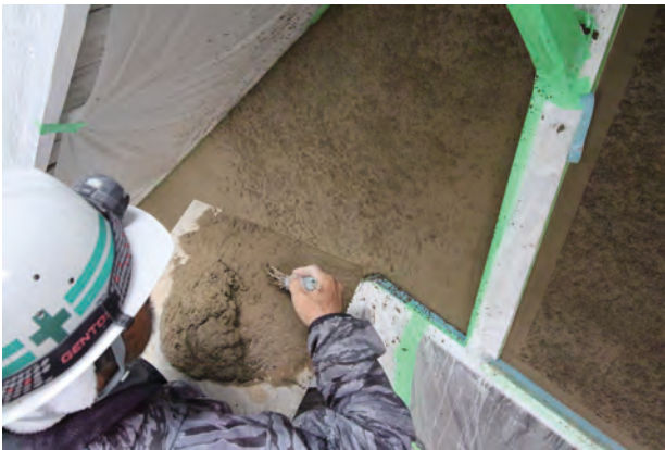
モルタル掃付け作業
