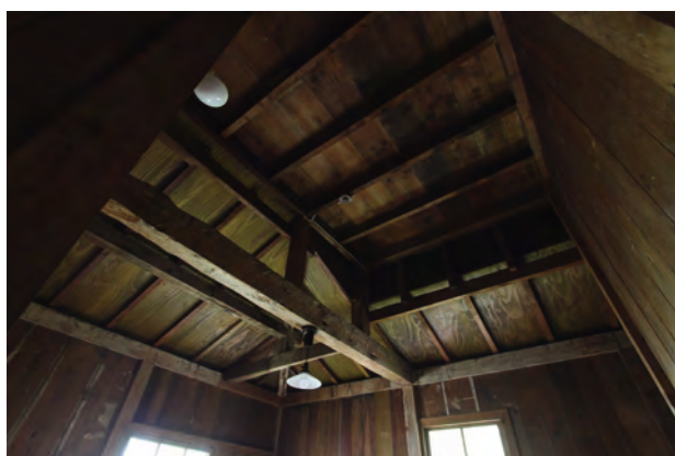
【竣工】 物置 小屋現わし天井
