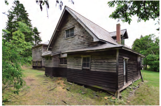
【修理前】外観 南西より
