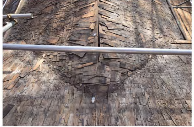
遺存していた桁葺の谷部
