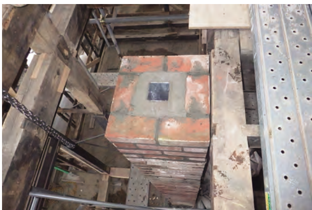
煙突組立状況
