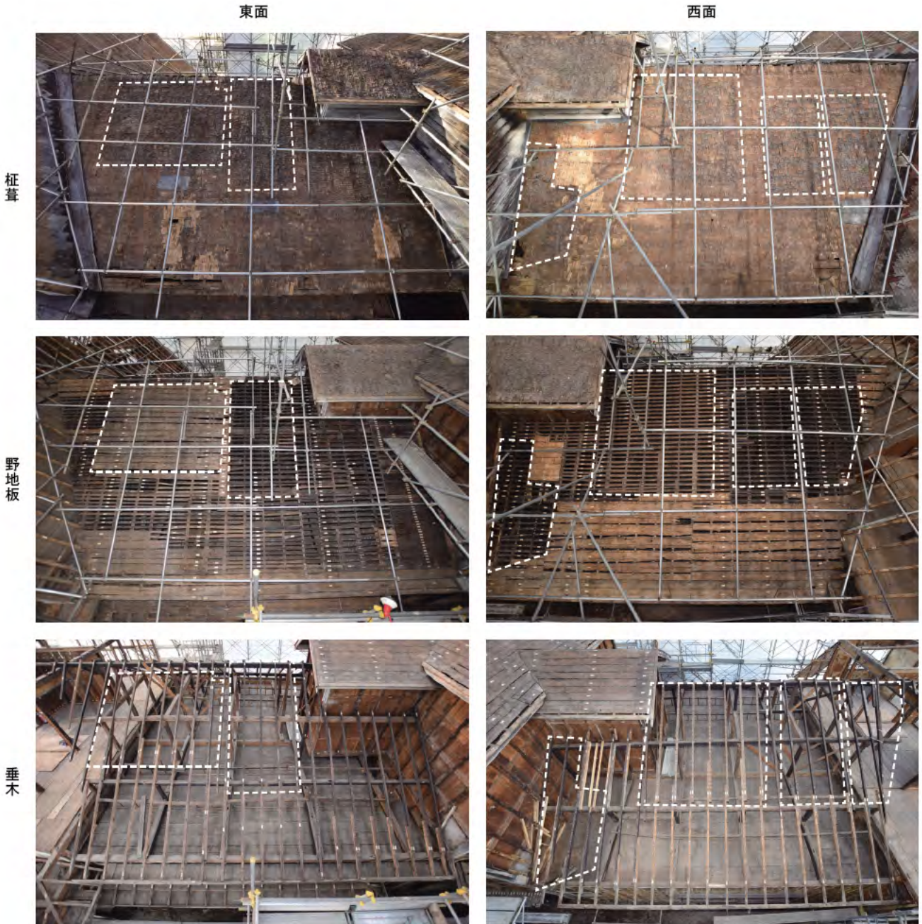
写 3-5-18 「中央棟」に再用された前身建物の屋根部材 点線に囲まれた範囲は野地板や垂木が均等に配されるとともに桁葺も古材を残しており、前身建物の状態を保持しているとみられる。組立時にはこれらの大きな塊を据えた後その周囲に適宜垂木や野地板を補足した。
