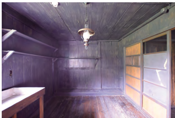
【修理前】台所 東よりみる
