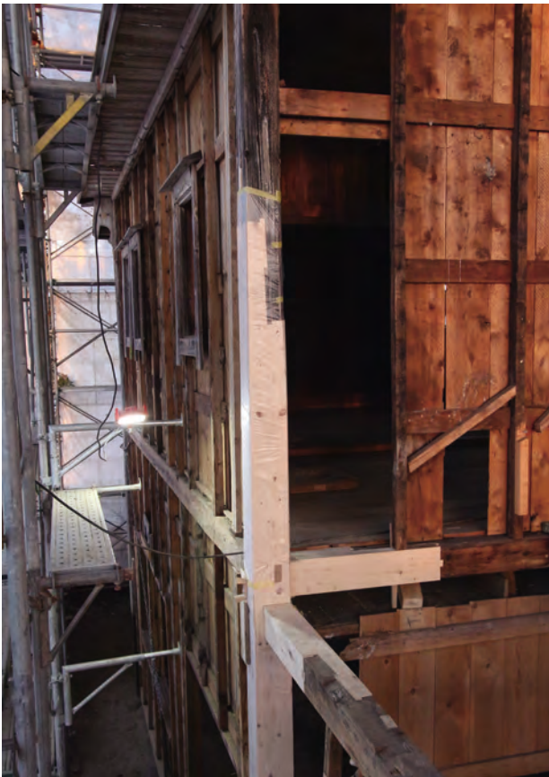
柱根継ぎ状況「北棟」と「中央棟」屋根との取合部
