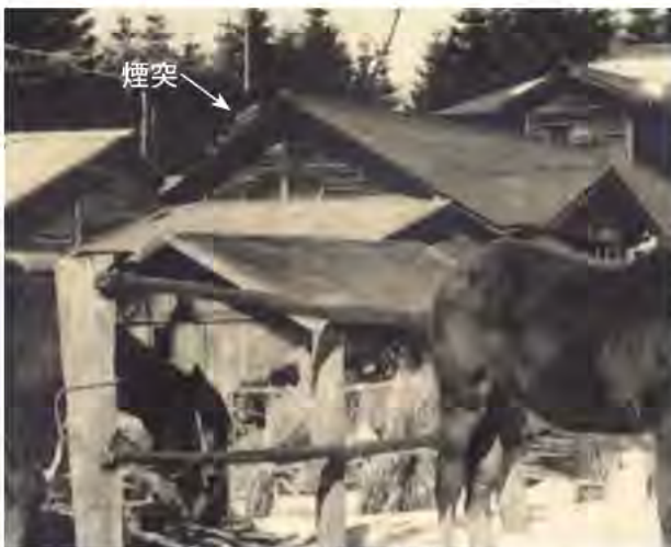
図3-3-8 Ⅲ期の建物南面 前身建物本家の妻面が写り梁間寸法や屋根形状が判明する。玄関背面側に煙突が見え、この付近に台所があったとみられる。
