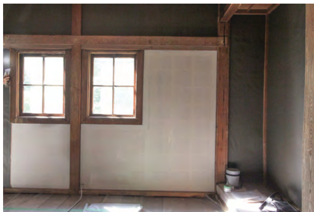
袋貼完了「北棟」客室7
