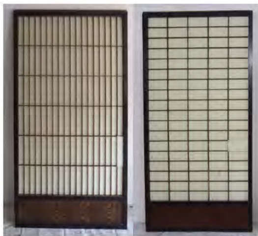
客室1・廊下境 腰付縦繁障子 組子角面取 客室2・廊下境 腰付横組障子 組子丸面取
