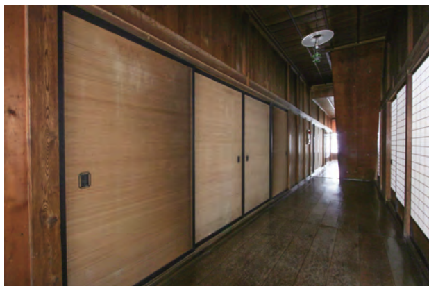
【竣工】「北棟」廊下 北西よりみる
