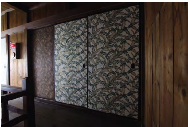
芭蕉葉模様襖取付状況「北棟」二階廊下
