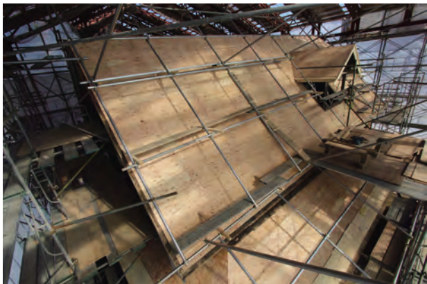
野地板施工完了「南棟」南西よりみる
