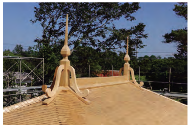
棟飾り施工完了
