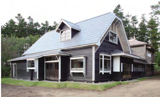
【竣工】外観 南東より
