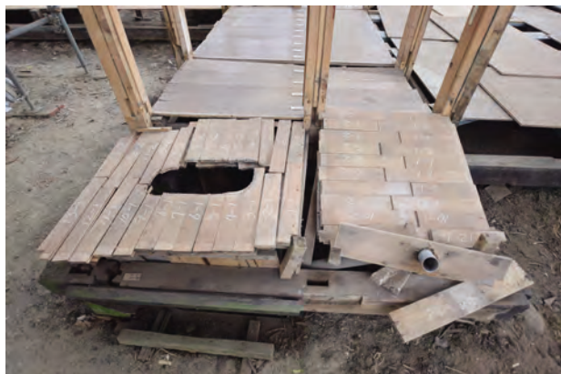
後設化粧床板 便所 西よりみる
