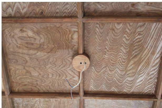
木台設置状況
