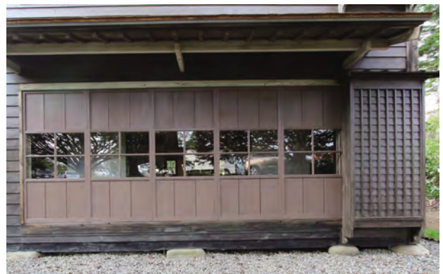
「北棟」復原建具古色塗り完了
