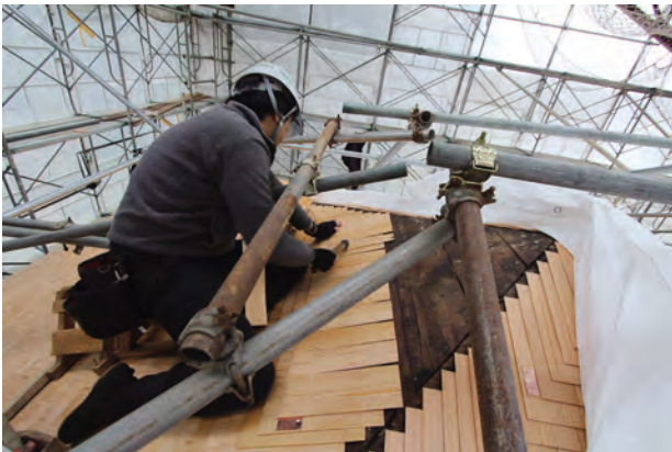
平葺施工状況
