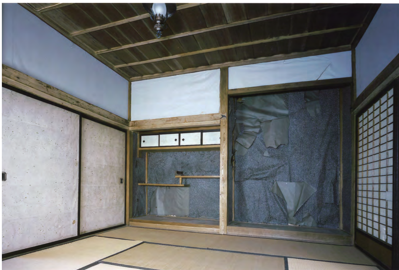
【修理前】客室5 南東よりみる
