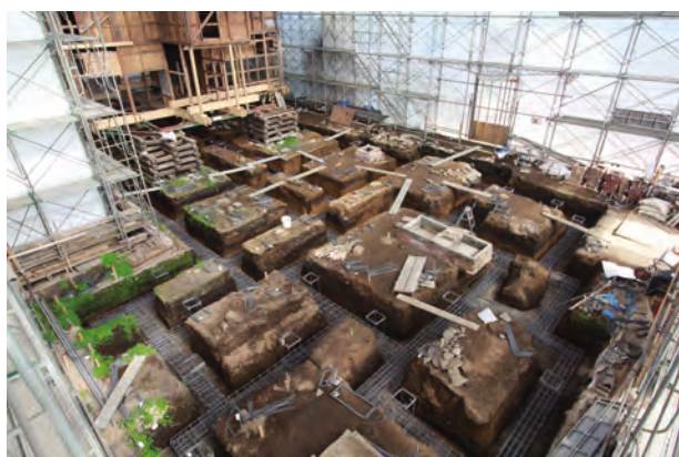
基礎配筋状況 南西よりみる
