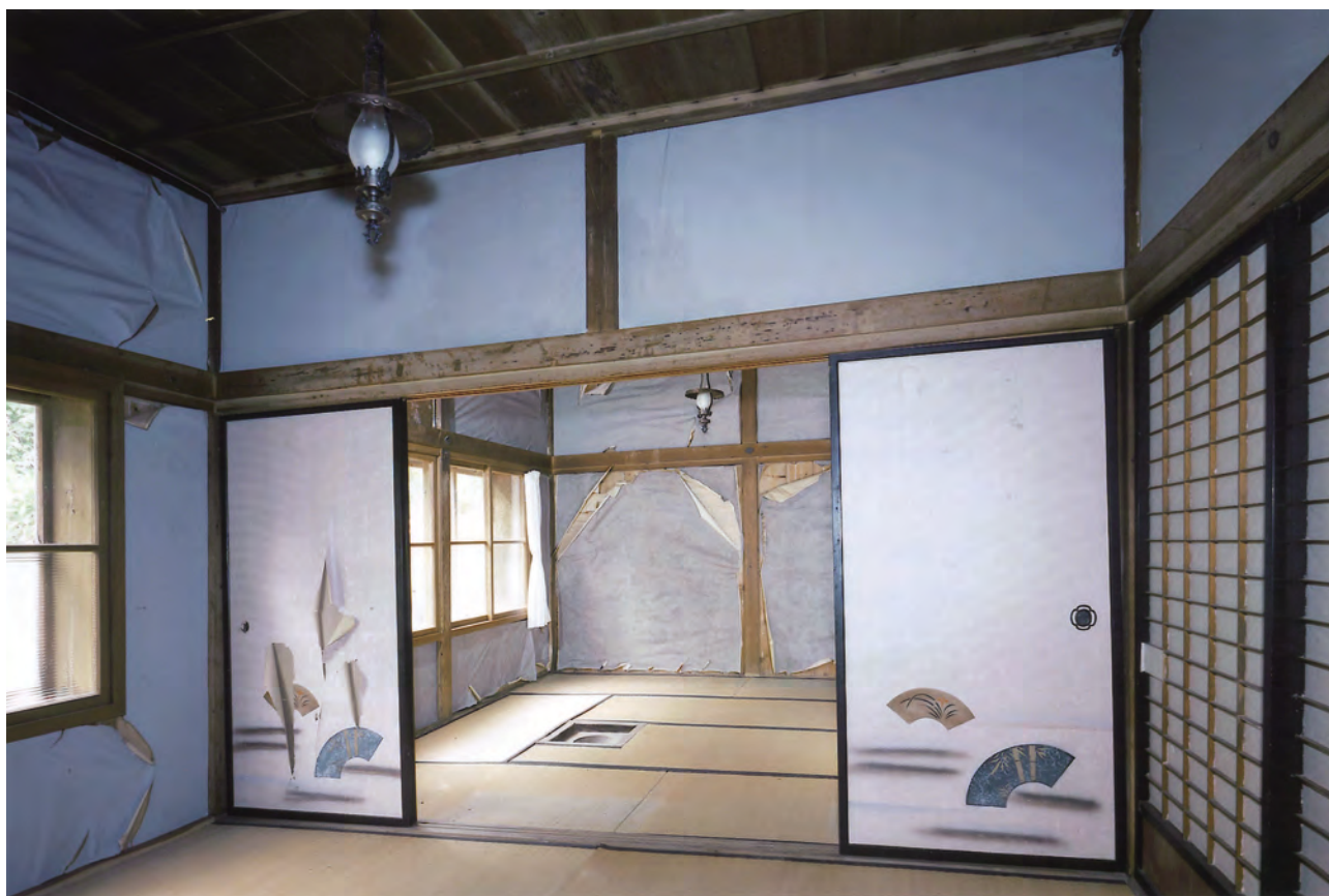
【修理前】 客室 3 南東より客室 4 を見通す
