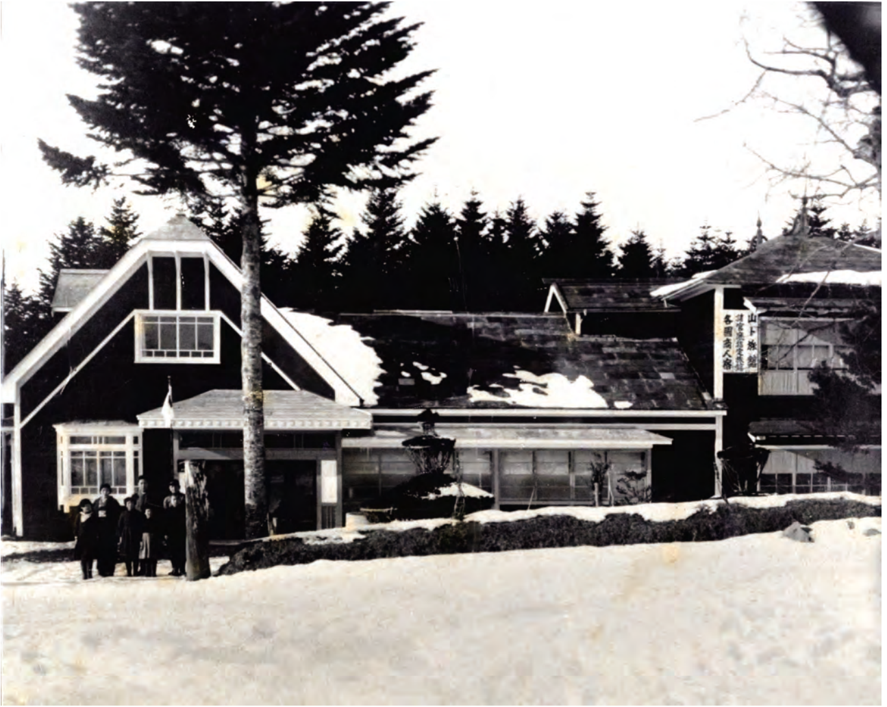
史 5 「中央棟」・「南棟」増改築後の山ト旅館（昭和 16 年）
