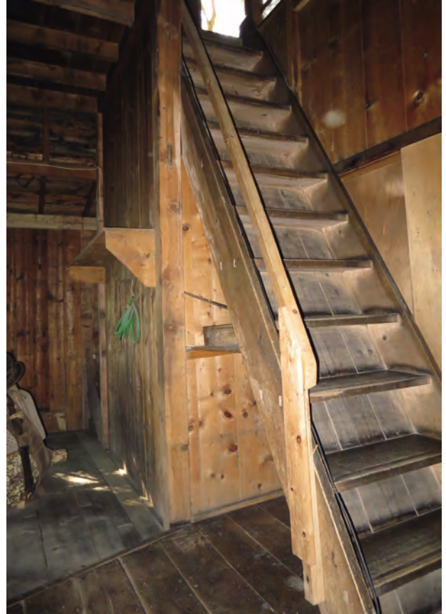
【修理前】「南棟」階段 南東よりみる
