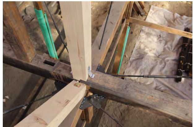
水平ブレース取付詳細
