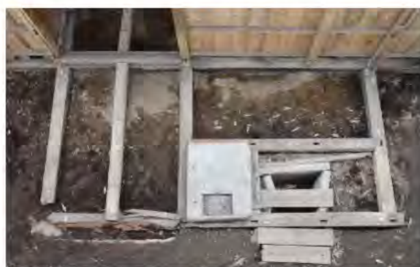
「北棟」便所 土台とコンクリート便槽
