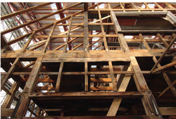
壁下地組立完了「南棟」東よりみる
