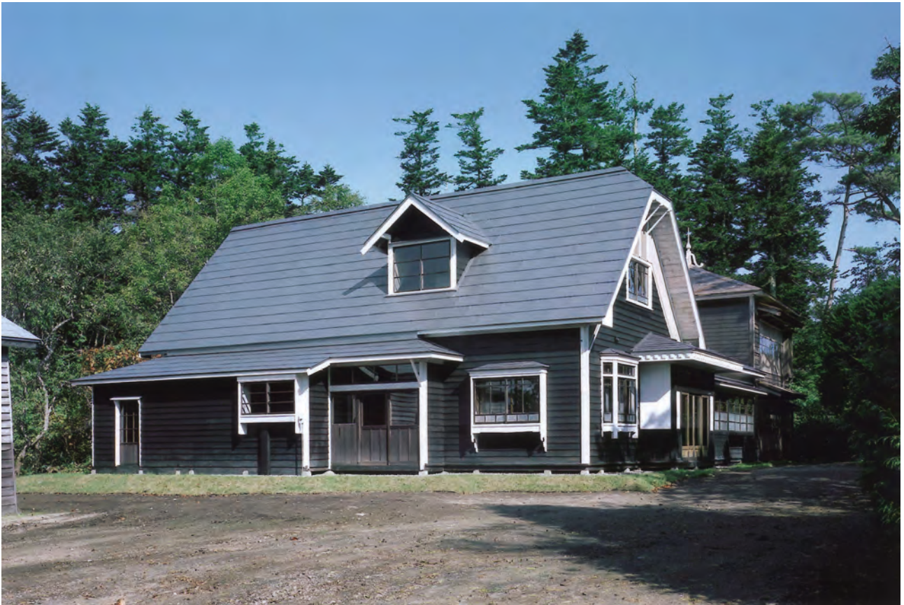
【竣工】外観 南東よりみる
