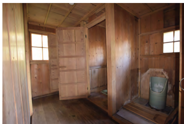
【修理前】「北棟」便所 南東よりみる
