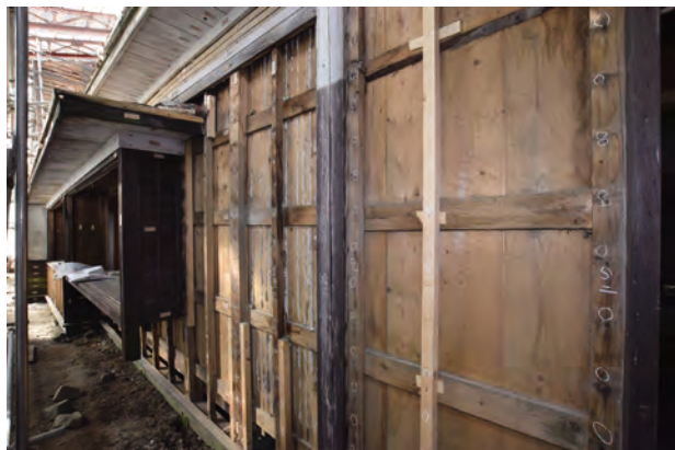
西面下見板解体完了 南西よりみる
