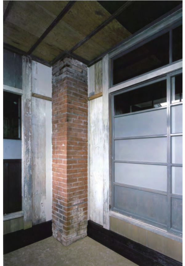
【竣工】裏玄関煙突
