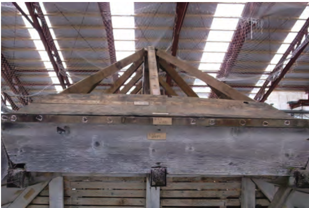
東側妻面頂部垂木
