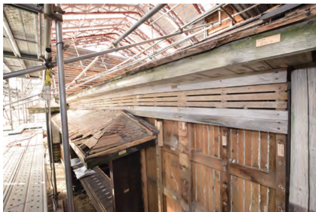
正面小壁木摺下地
