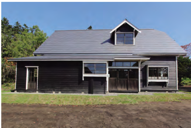
【竣工】「南棟」南面
