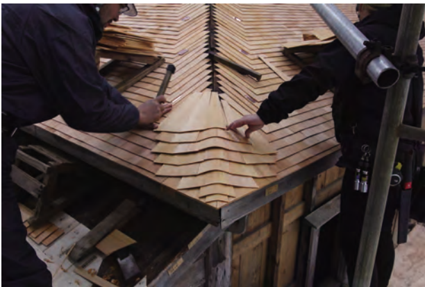
隅棟施工状況
