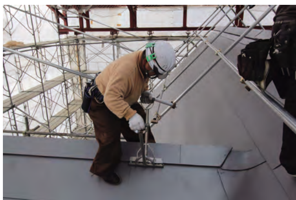
棟包み施工状況
