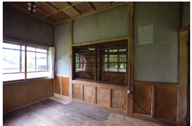
【修理前】事務所 北東よりみる
