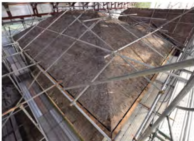
写 3-5-12 「北棟」 鉄板下に遺存していた桁葺
