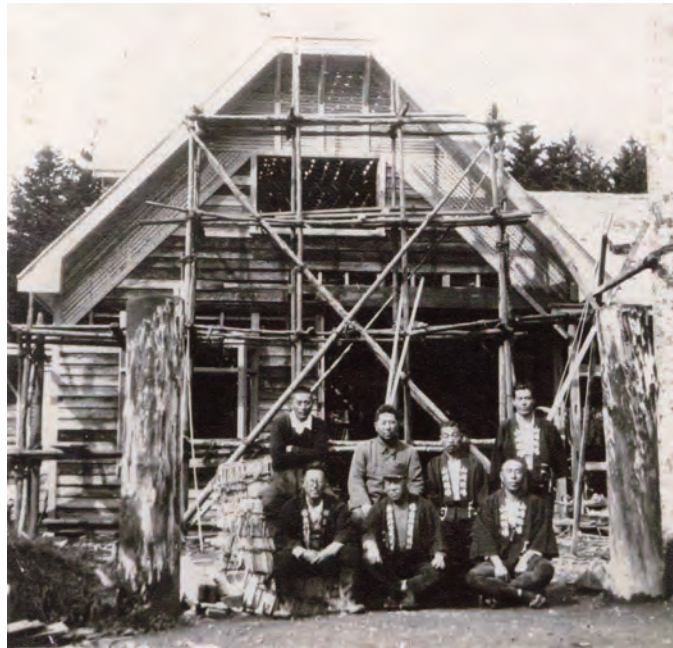
史 14 「南棟」改築工事中（昭和 16 年）
