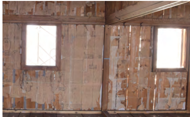
写 3-5-39 客室6 (左) と客室7 (右) の下貼り遺存状況 客室7はこれまでに2回下貼りの袋貼を撤去した痕跡があり、客室6は最初の貼り替え時に重ねて貼られたため下貼りの残存状況がいい。
