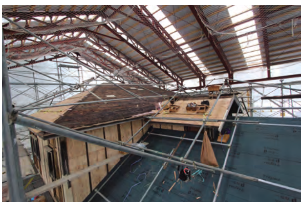
野地板施工完了「北棟」南西よりみる
