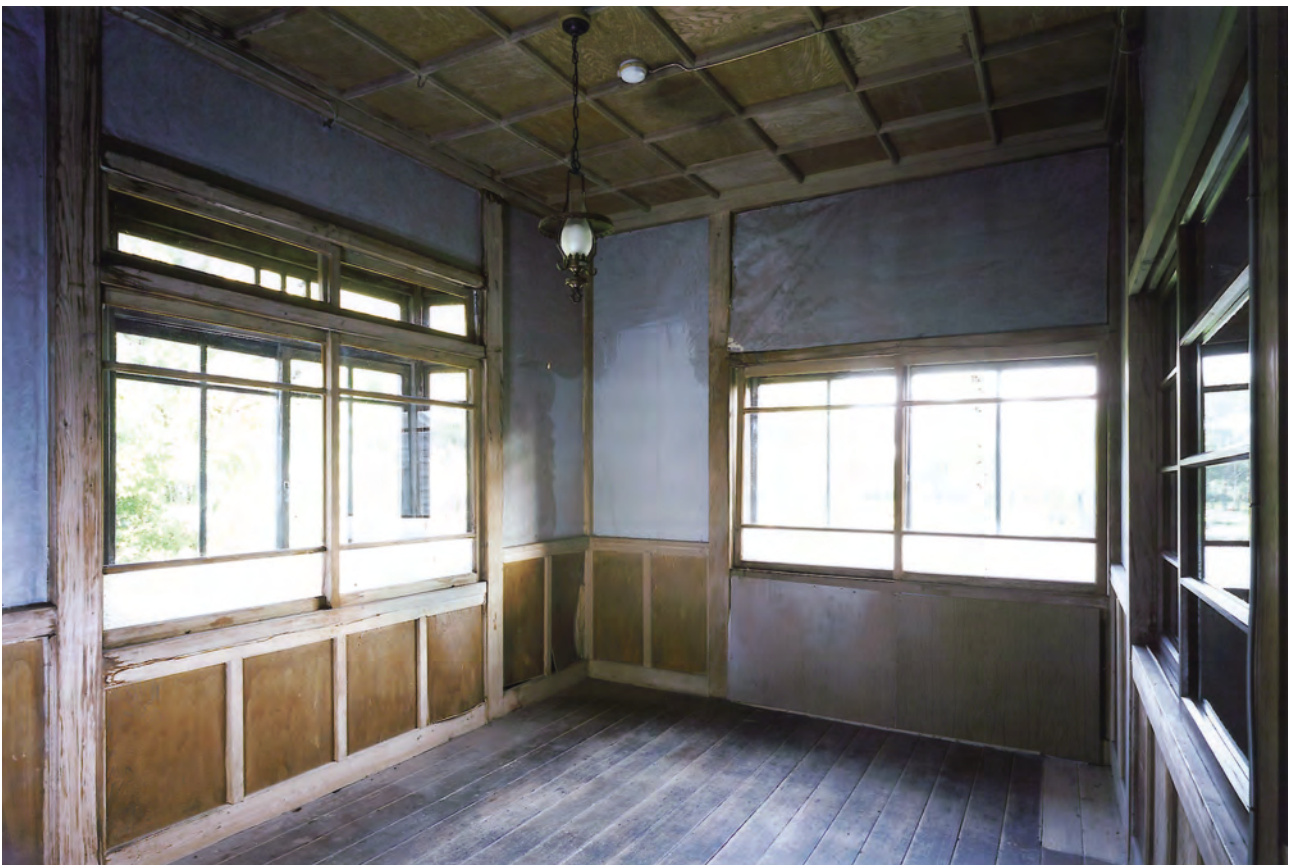
【修理前】事務所 北西よりみる
