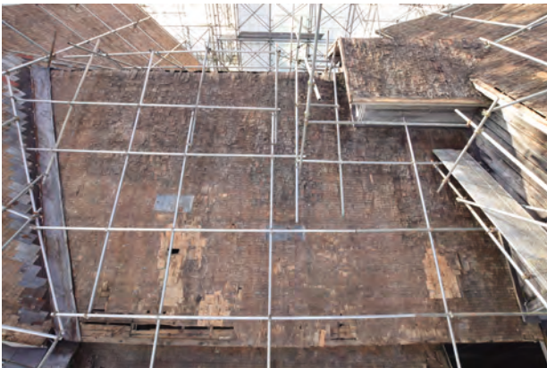
鋼板葺解体完了 東面桁葺
