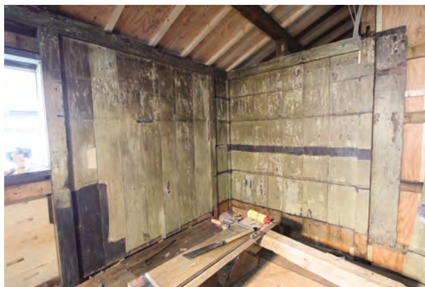
化粧板取付状況 台所 北東よりみる
