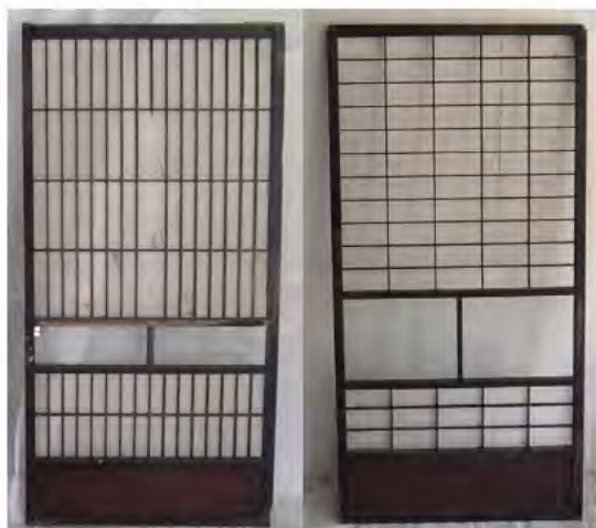
ランプ室前 腰付額入縦繁障子 組子丸面取 ランプ室・便所境 腰付額入横組障子 組子角面取
