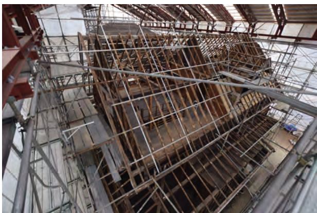
野地板解体完了 垂木
