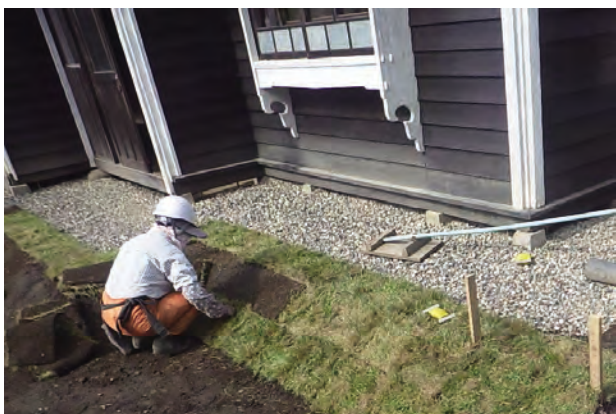
法面芝張施工状況
