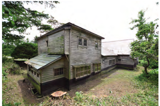
【修理前】外観 北西より
