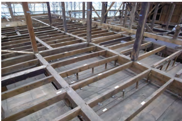
荒床解体完了 床組 和室2 南東よりみる
