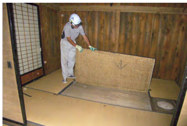
畳撤去状況 客室6 北西よりみる
