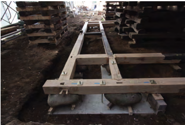
アンカーボルトと土台の緊結状況
