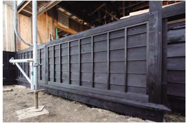
外壁塗装施工完了「中央棟」南東よりみる
