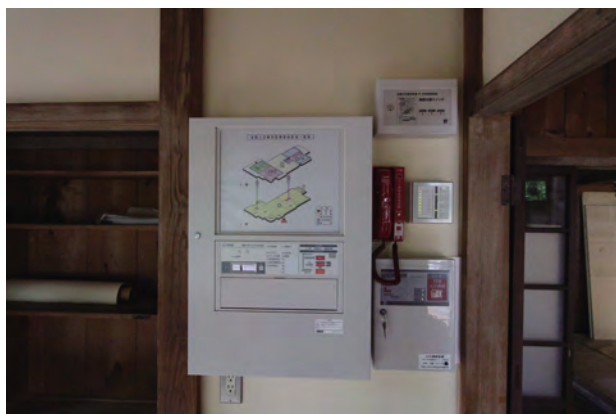
分電盤等取付完了
