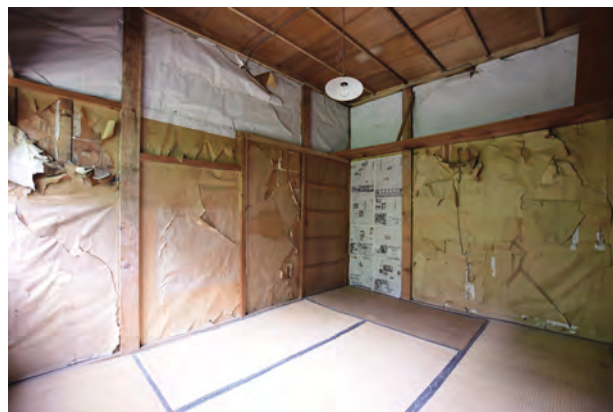
【修理前】 使用人室 南西よりみる
