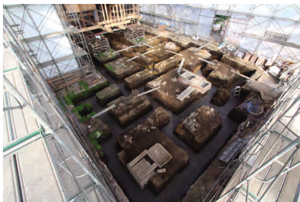
捨てコンクリート打設状況 南西よりみる
