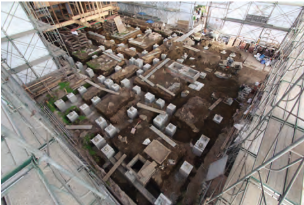
基礎コンクリート打設 南西よりみる
