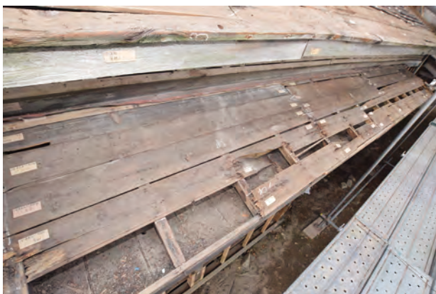
野地板 東側底 南東よりみる
