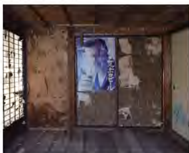
写 3-5-30 「南棟」客室1・2境に転用されていた「北棟」旧一階押入襖戸
