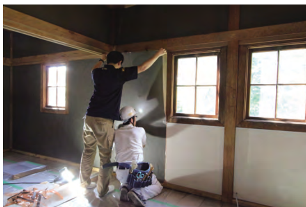
上貼施工状況
