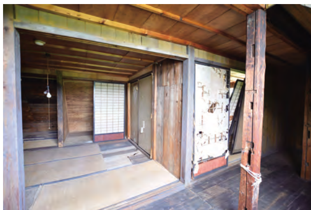
【修理前】小屋裏廊下南西より和室1を見通す
