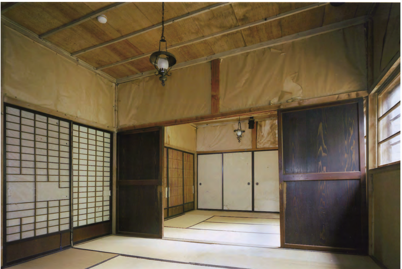
【修理前】 客室 2 北西より客室 1 を見通す
