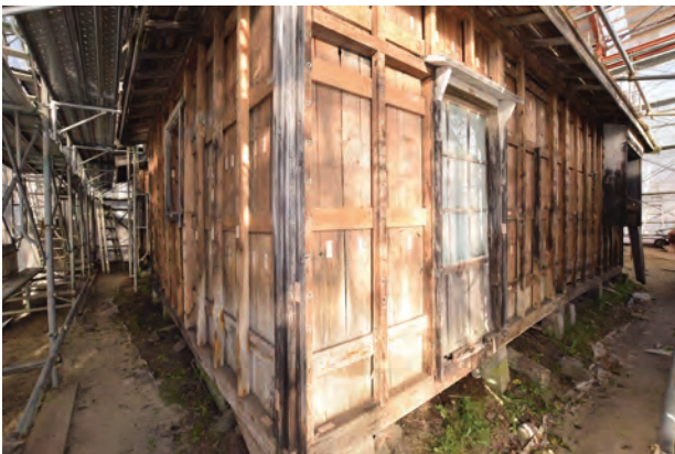
下見板解体完了 南西よりみる
