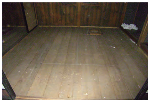
荒床 客室7 東よりみる
