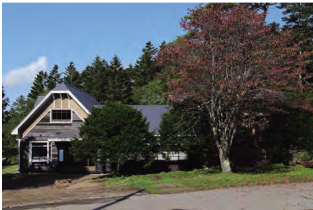
【竣工】外観正面（東面）
