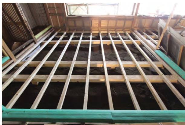
床組組立完了「南棟」仏間 西よりみる
