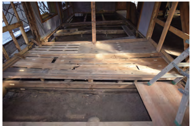
後設床板 客室2より客室2 押入、客室3 押入をみる
