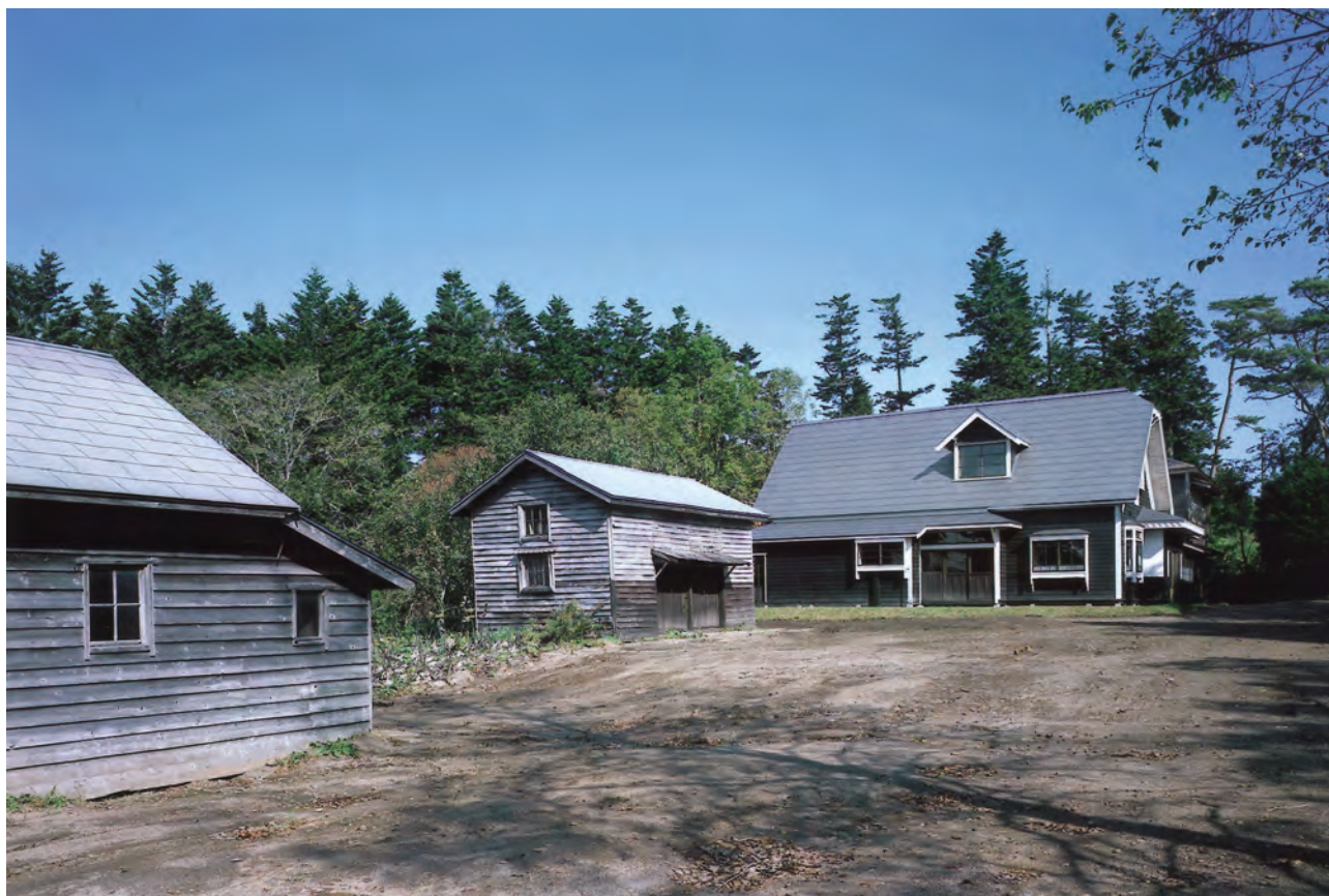
【竣工】外観 南東よりみる
