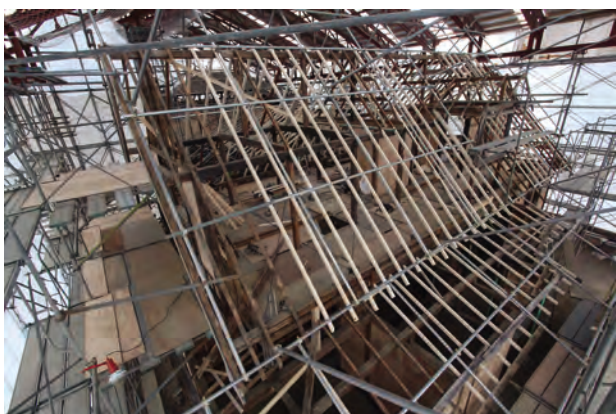
垂木組立完了「南棟」南西よりみる
