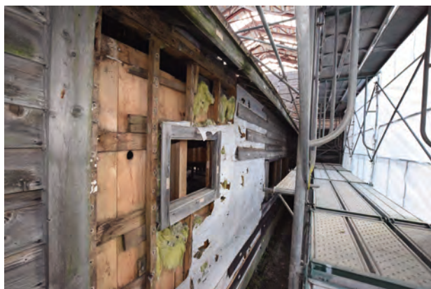
北棟取合い部西側下見板解体完了
