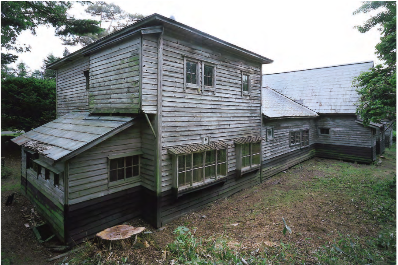
【修理前】外観 北西よりみる
