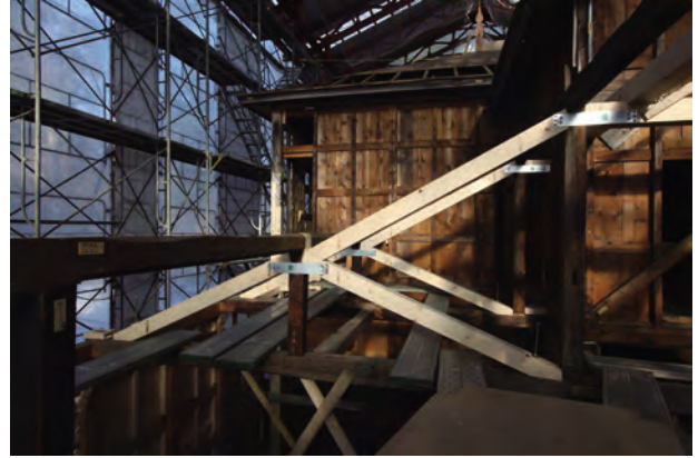
補強トラス設置状況
