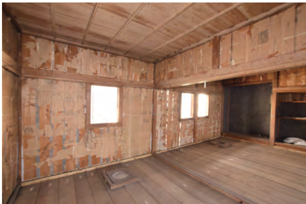
後設化粧板解体完了 客室6南東より客室7を見通す
