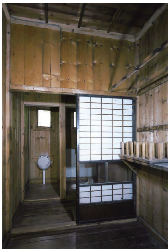
【修理前】ランプ室より便所を見通す
