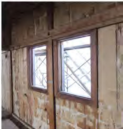
二階同位置（客室7）の窓額縁
