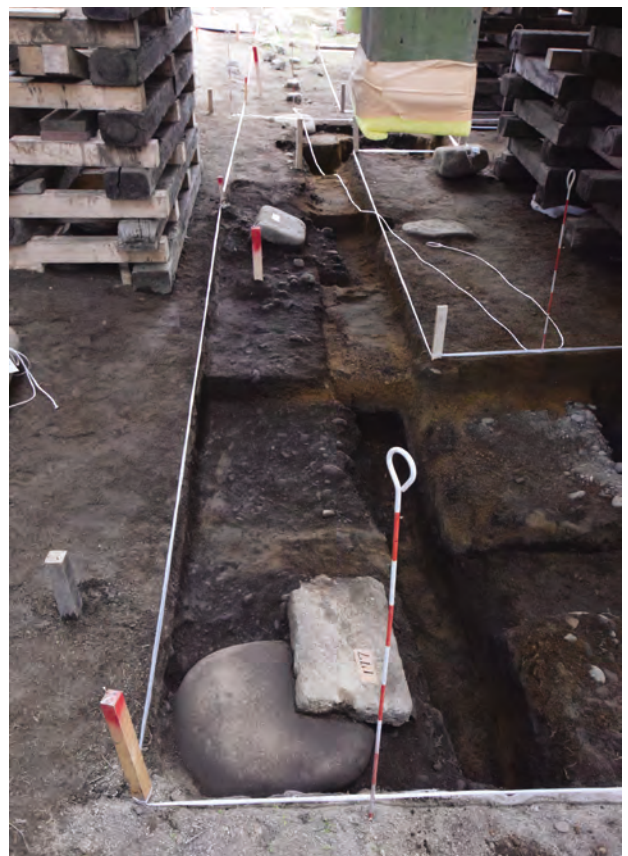
写 3-1-7 礎石の不陸 (北棟)
