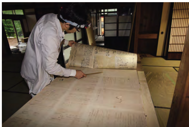
襖紙貼替作業状況
