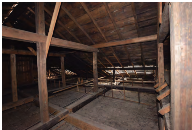
小屋裏 南西よりみる
