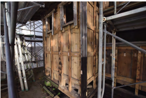
下見板解体完了 便所 南よりみる
