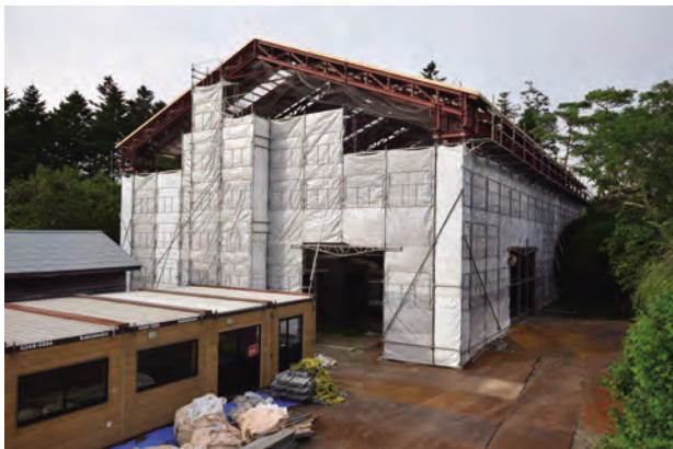
素屋根外観 南東よりみる
