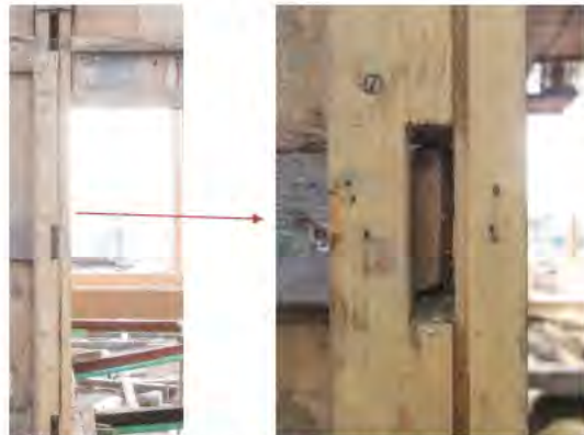
く-七の柱北面に残る当初板壁の痕跡
