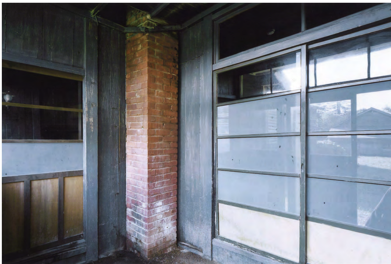
【修理前】裏玄関 南東よりみる
