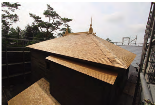
葺葺施工完了「北棟」北西よりみる
