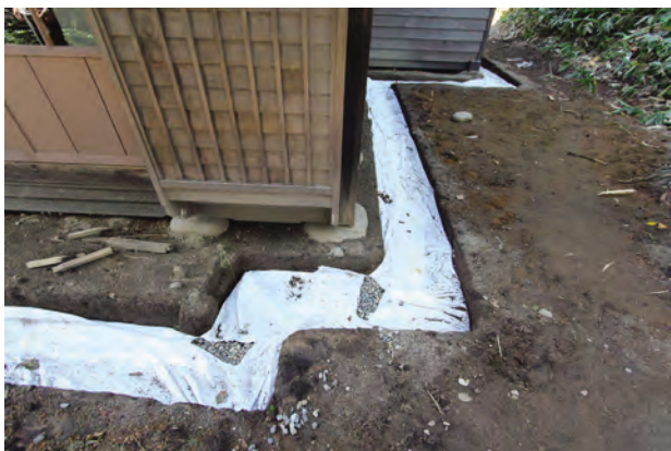
不織布透水シート施工状況
