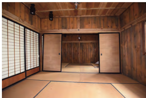
【修理前】客室7より客室6を見通す
