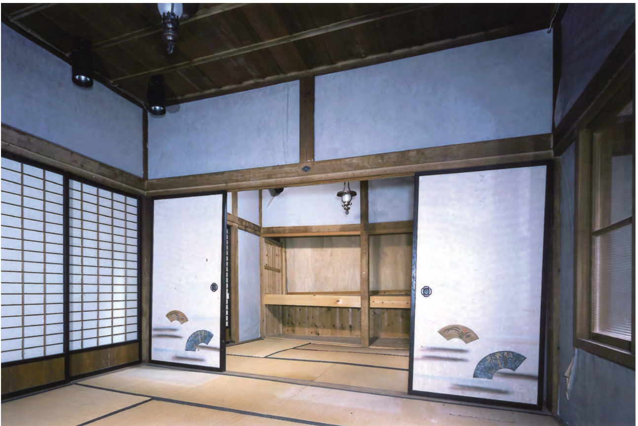
【修理前】 客室 4 北西より客室 3 を見通す
