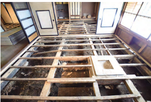
荒床解体完了 床組 茶のから仏間をみる
