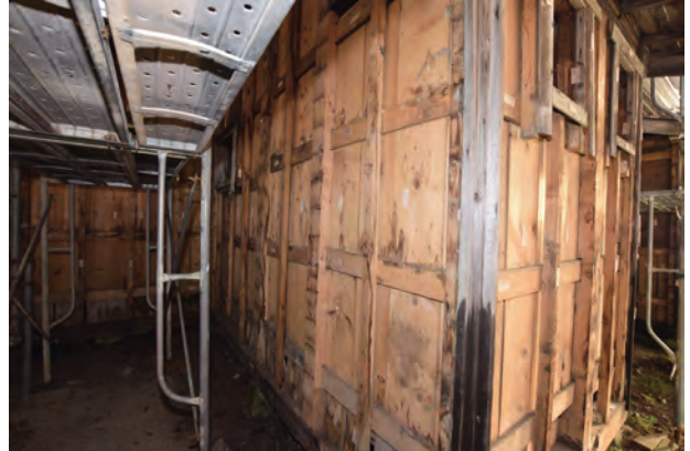
下見板解体完了 便所 北西よりみる
