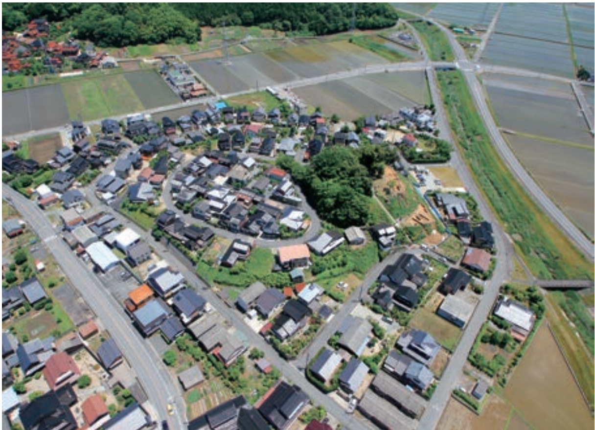
石井要害跡全景（西から）
