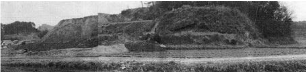
住宅造成工事中の状況（南から）
