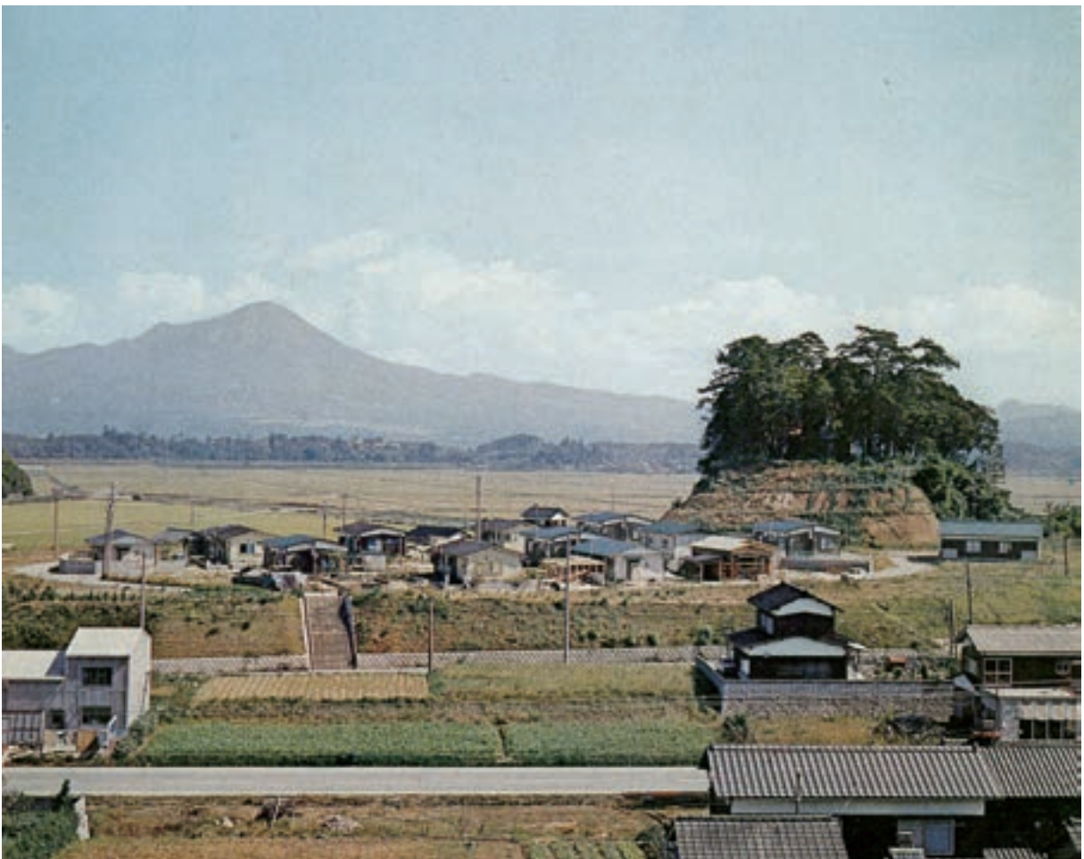
住宅造成工事完成後の状況（北西から）
