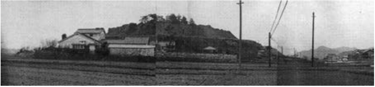
住宅造成工事中の状況（北から）
