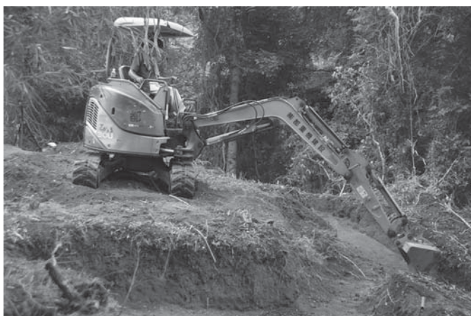
7. 掘削作業風景 (北東→)
