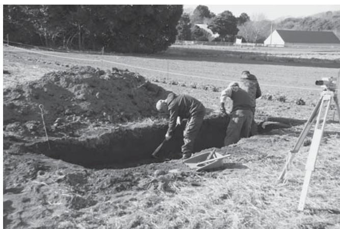
8. 作業風景 (南東→)
