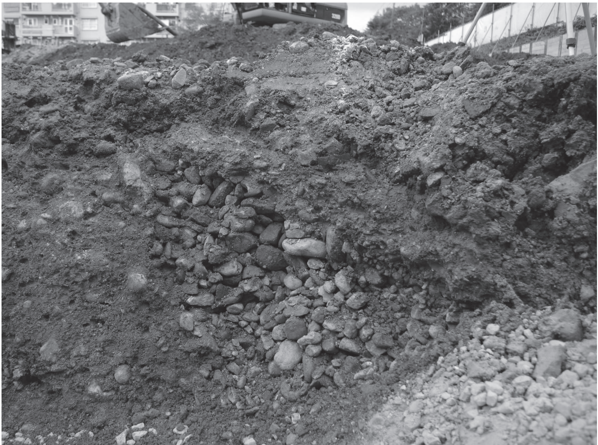
2 No.9-11：西側石垣裏込め（南から）
