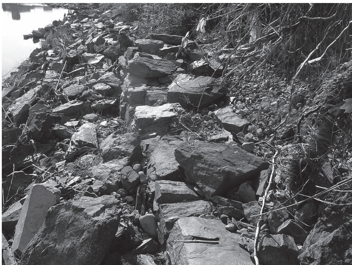
2 ②地点 石積と護岸捨石（北から）
