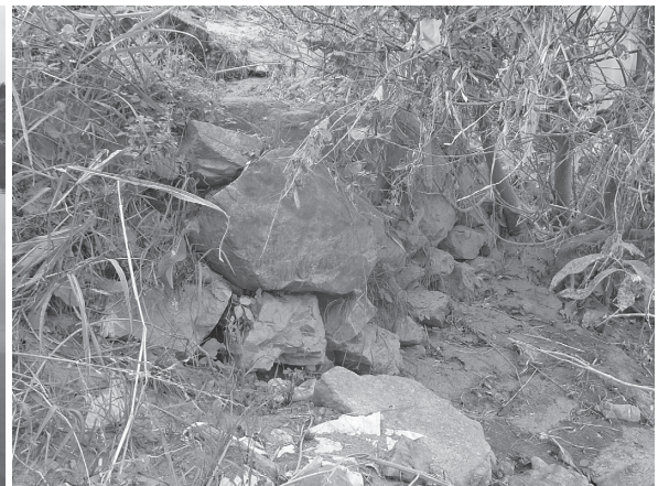
図 50 ⑤地点 石積（南東から）
