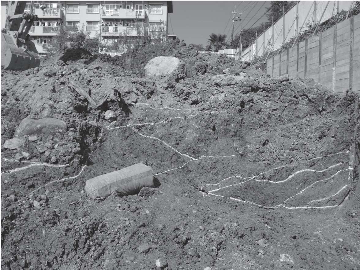
1 No.10断割り北壁断面（南から）
