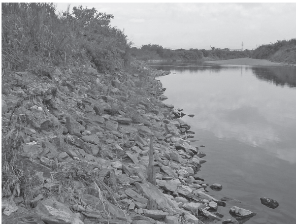
図 49 ④地点 杭列及び護岸捨石（南から）
