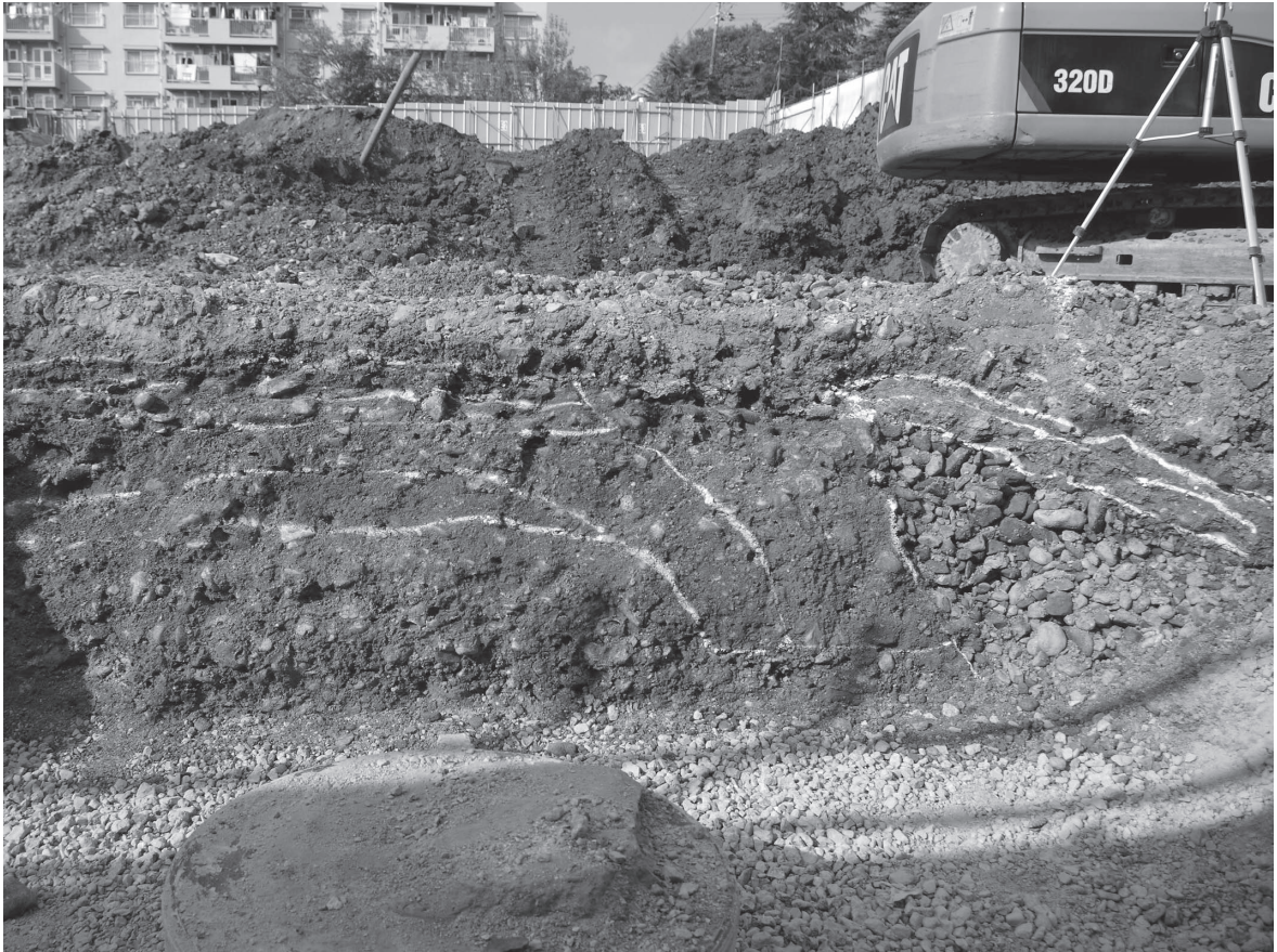
1 No.9 断割り北壁断面（南から）
