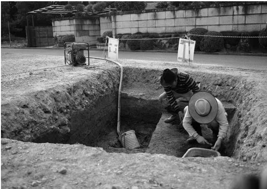
西区作業風景
