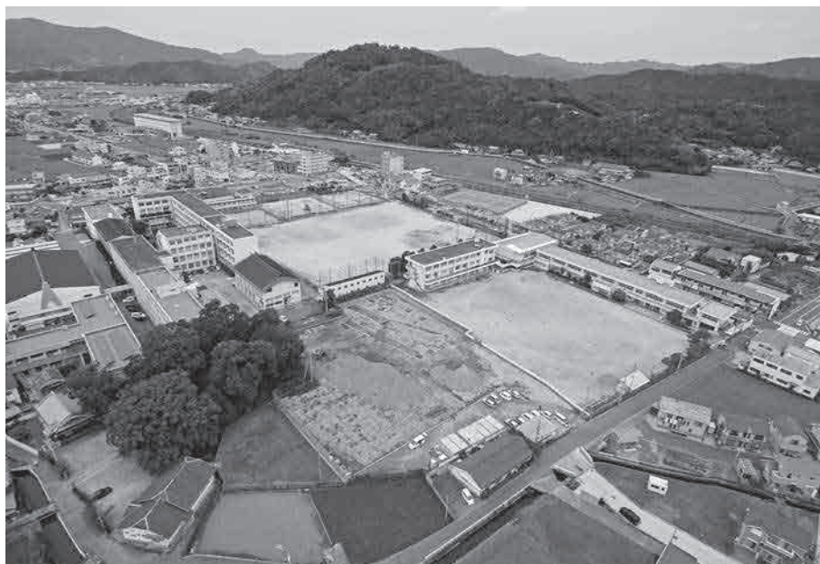
1. 遺跡近景 (南東上空から)
