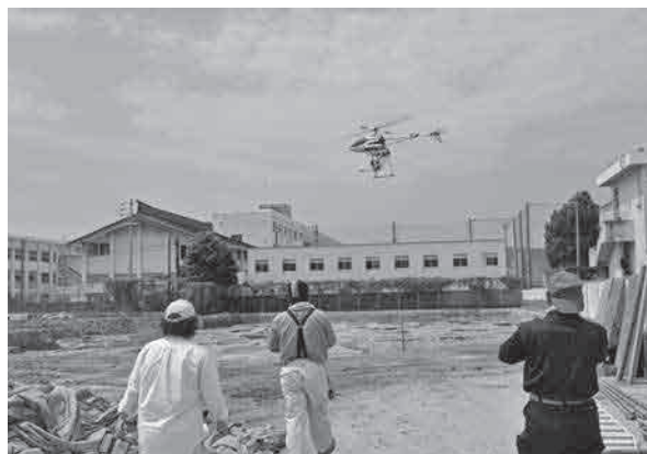
写真11 航空写真撮影風景
