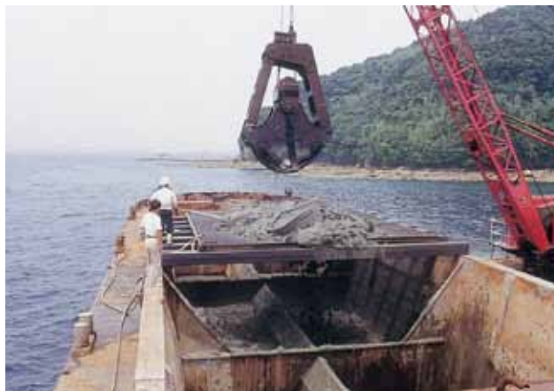
1. I 層シルト層浚渫状況
