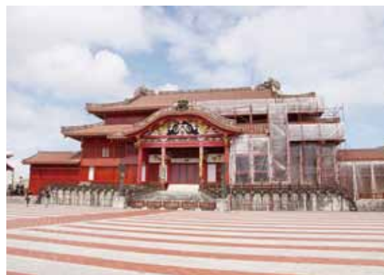
図版16 首里城正殿における塗装修理の現況
