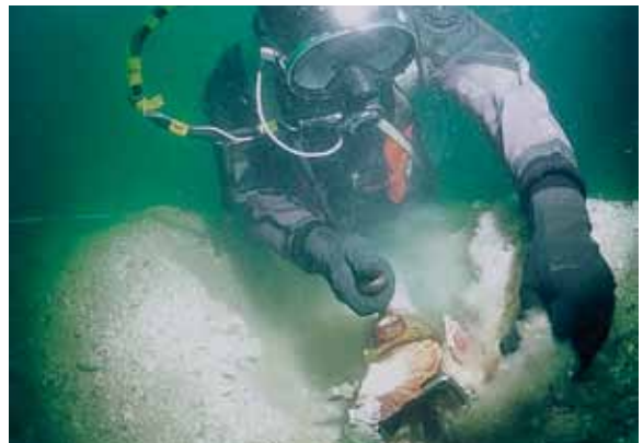
6. 砂層の調査状況
